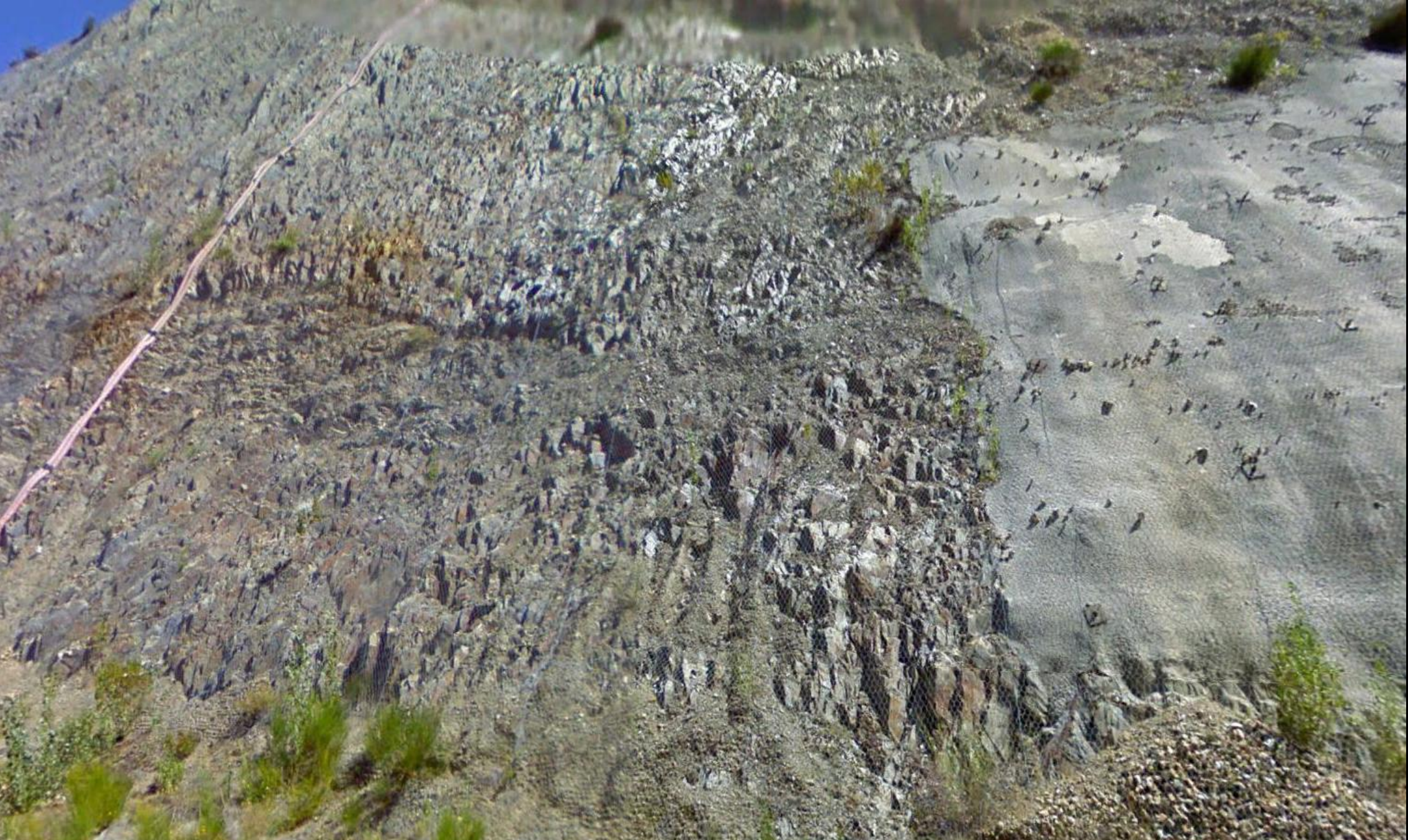
Gunitado, bulonado y mallazo en las pizarras cuarcitas y areniscas, Serie de Los Cabos, Cambrico-Ordovícico. SE de Trabadelo, León. E Hoja de Oencia.
