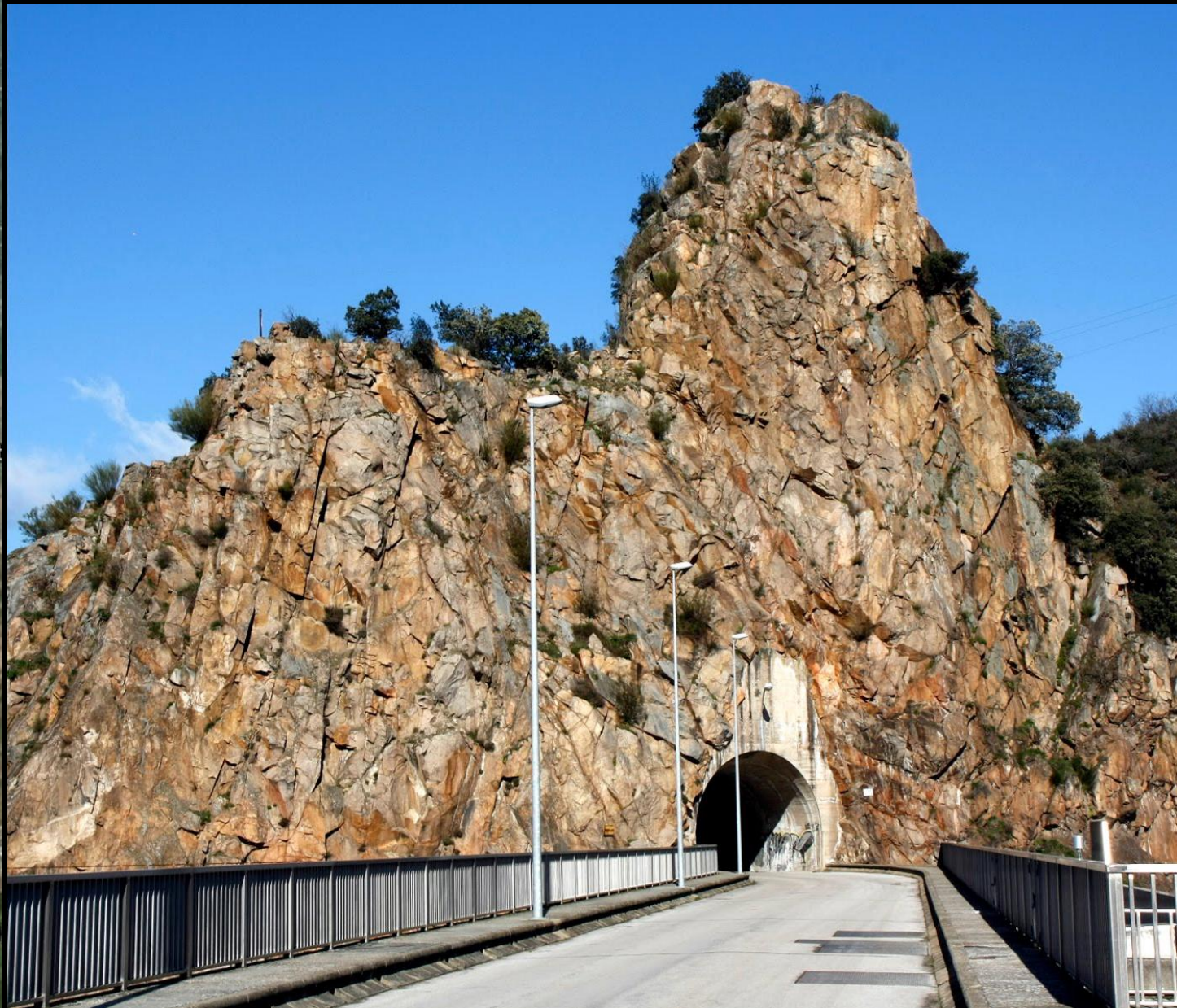
Embalse de Bárzana, en el Río Sil. E Hoja de Ponferrada. Areniscas del Ordovícico Sup. Estribo derecho. (por Cardega-Google)
