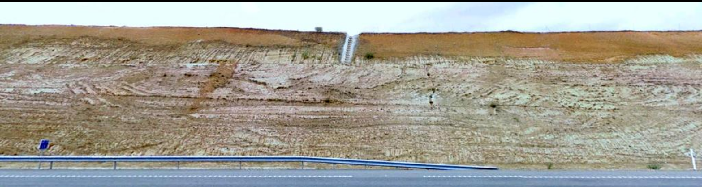
Talud en la Autopista León-Astorga. Entre materiales del Neógeno, Terciario. SE de San Justo de La Vega. Centro N Hoja de Astorga.
