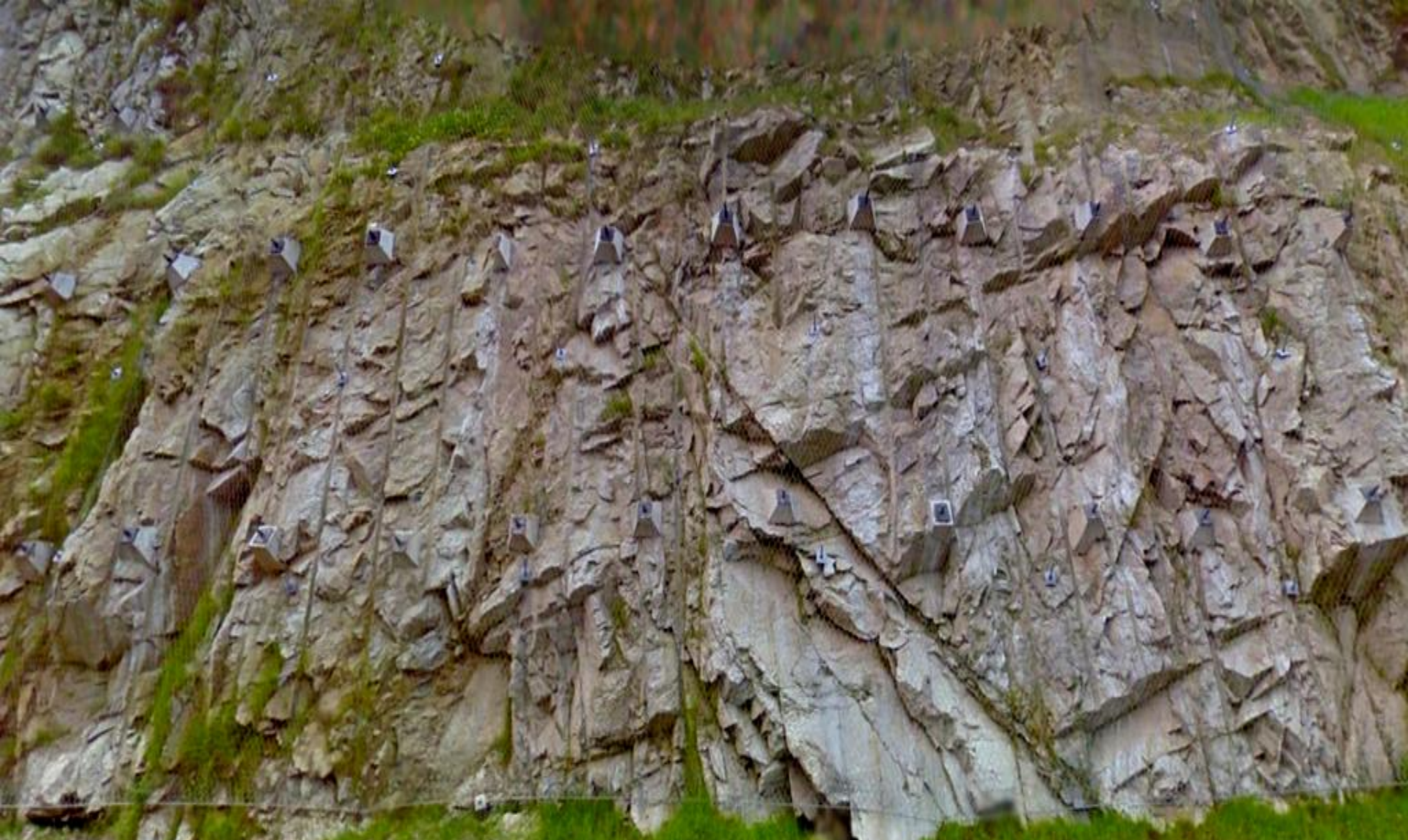
Granito tectonizado, bulonado y con mallazo, en talud junto al Río Bidasoa. Hoja de Vera de Bidasoa.
