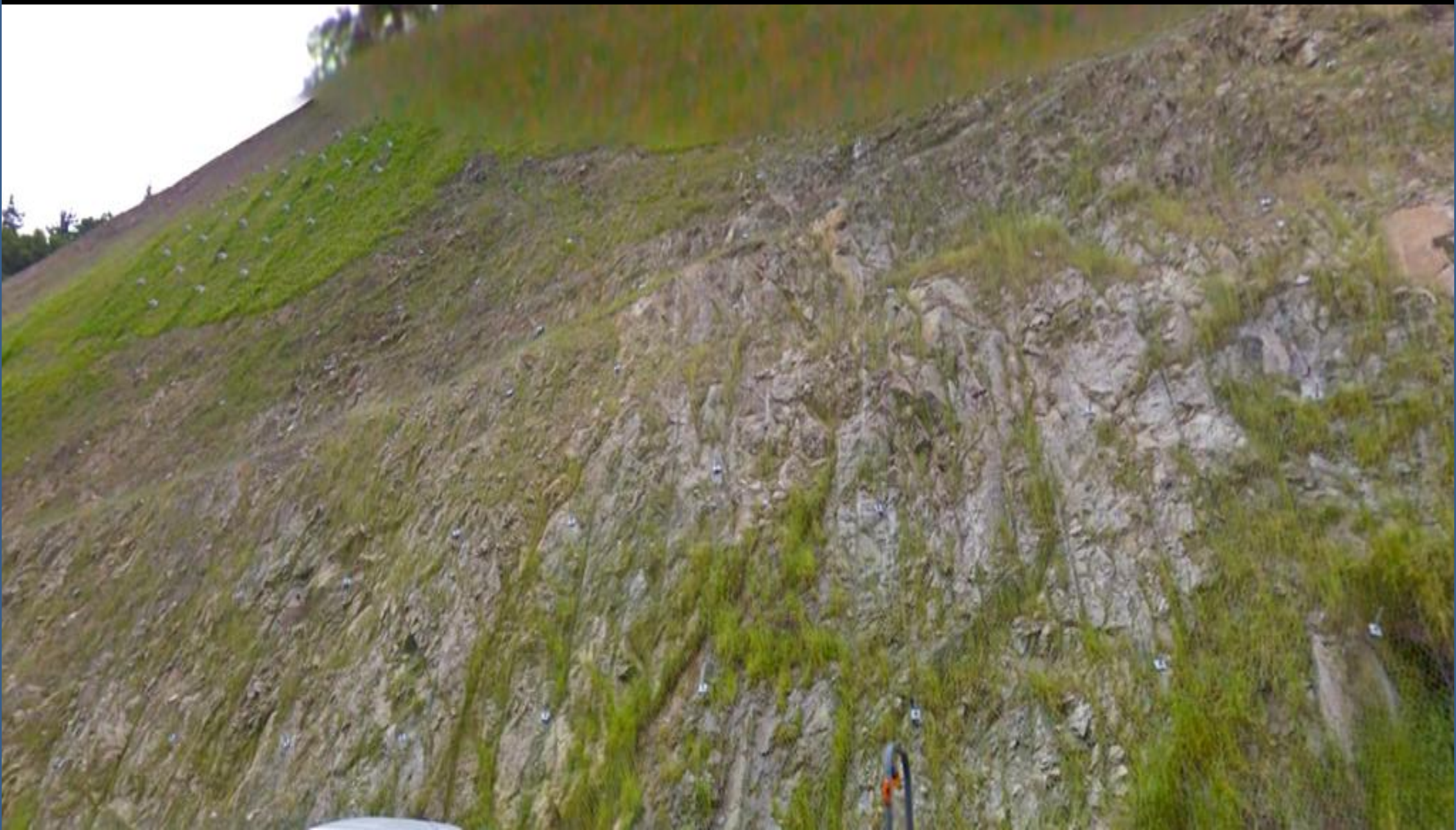
Granito con mallazo y bulones. Junto al Río Bidasoa. Hoja de Vera de Bidasoa.
