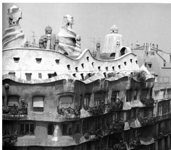
Casa Milá o pedrera
