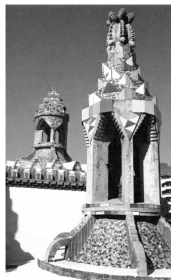
Torres de ventilación de la finca Güell
