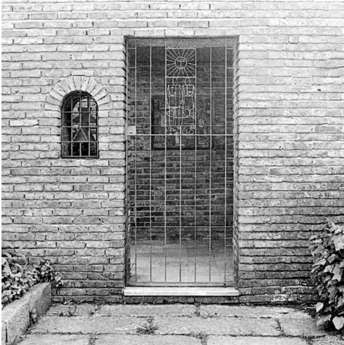
Reja constructiva a través de la cual se puede apreciar un mosaico. Vivienda de Mario Lorigo
