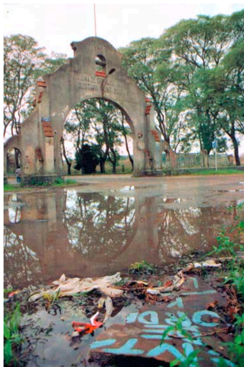
Estado actual de la entrada al hospital Saint Bois
