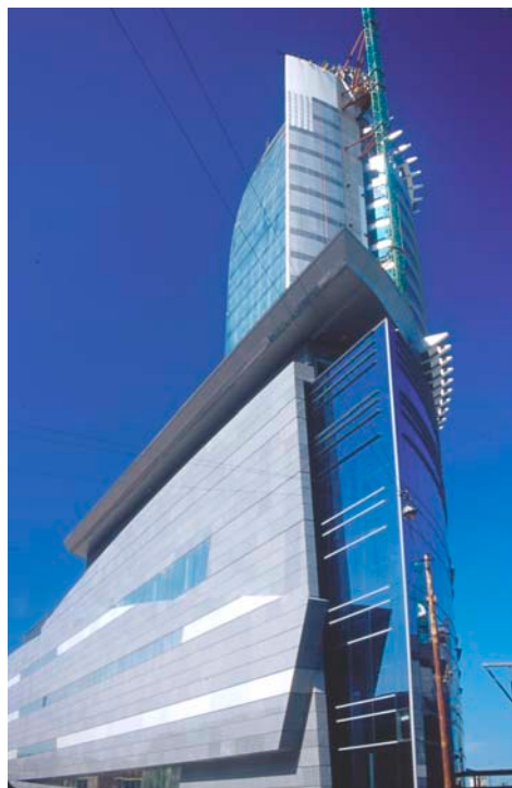
Torre de telecomunicaciones de ANTEL en Montevideo
