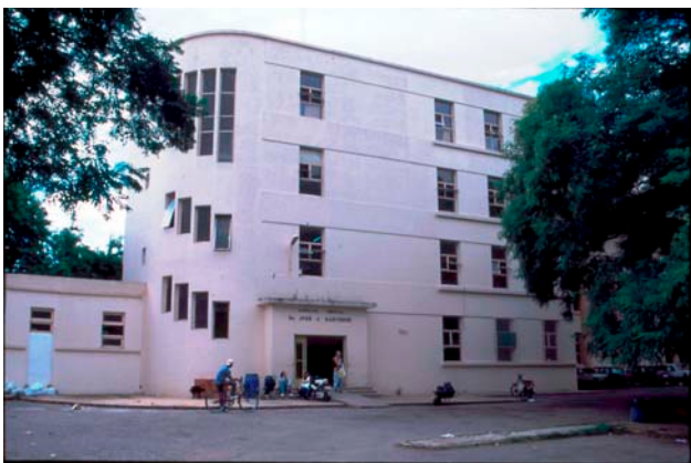
Vista del pabellón Martirené en la actualidad
