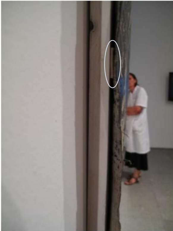
Fig. 24. Detalle sistema de colgado Antiluna , Pinot Galizio - Autoría propia.
