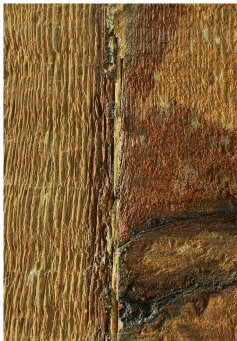
Fig. 78. Detalle de la zona de la unión intervenida en el reverso de la tabla .
