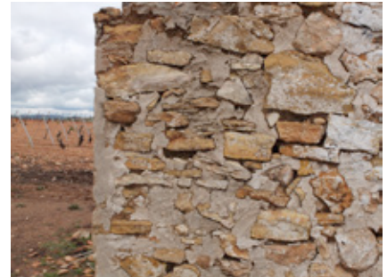
Foto 1. Fachada lateral izquierda.
