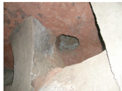
Foto 1. Techo sala de tinajas
