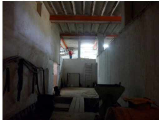
Imagen 3. Escalera de acceso y estructura de la zona de acceso a la trulleta.
