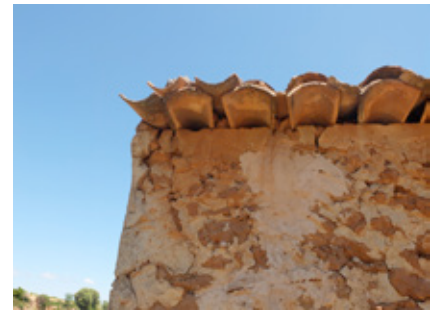
Foto 1. Fachada lateral derecha.
