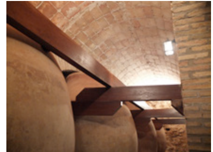
Foto 1. Galería de tinajas, con refuerzo de madera
