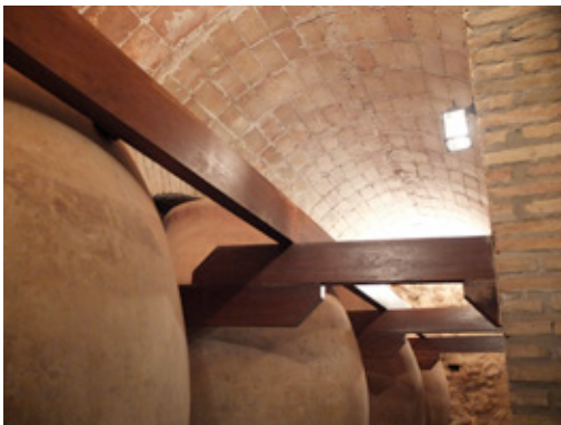
Imagen 29. Bóveda que cubre la sala de tinajas. La estructura de manera es reciente
