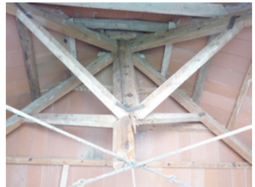
Imagen 21. Estructura de cubierta de las torres
