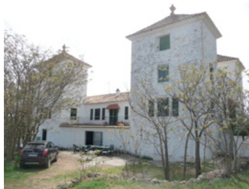
Imagen 5. Fachada trasera que recae a patio interior.
