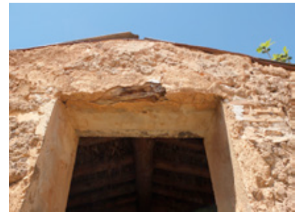
Foto 1. Fachada lateral izquierda.
