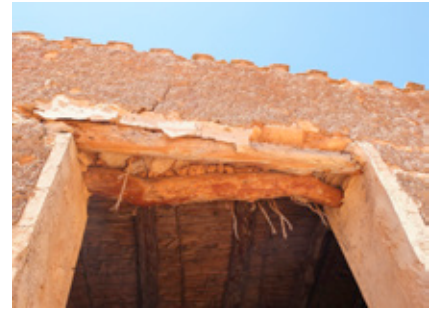
Foto 1. Fachada lateral derecha.
