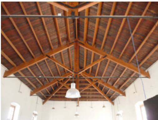
Imagen 11. Estructura de cubierta inclinada correspondiente al edificio.
