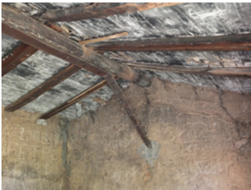
Imagen 16. Detalle estructura de cubierta.
