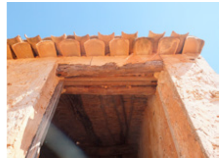
Foto 1. Fachada lateral izquierda.
