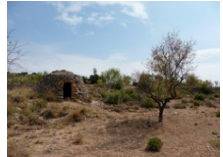
Foto 1. Vista general de la parte posterior.
