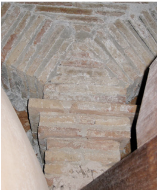
Imagen 28. Pilastras de apoyo a los arcos en sala de tinajas, Plaza Mayor 5
