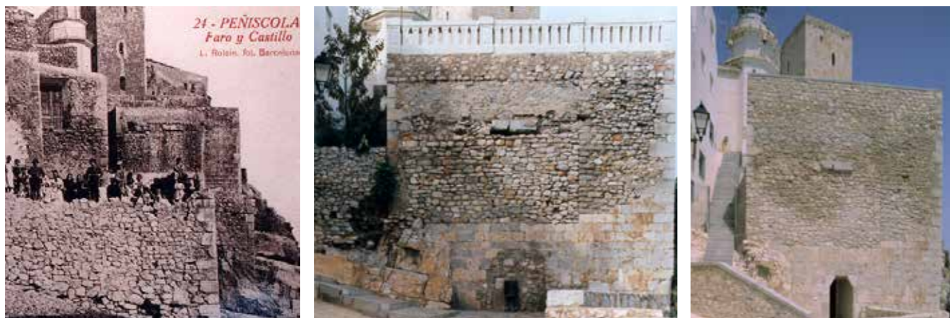
Fig. 1.17. Vistas del antiguo almacén de pólvora, a la izquierda foto de aproximadamente 1930 de L. Roisin, importante para detectar el cambio de parapetos y zonas de paso de ronda lateral. En el centro en 1998, estado anterior a la restauración con zonas muy transformadas y a la derecha estado final en 2002, tras recuperar paso lateral y acceso antiguo.
