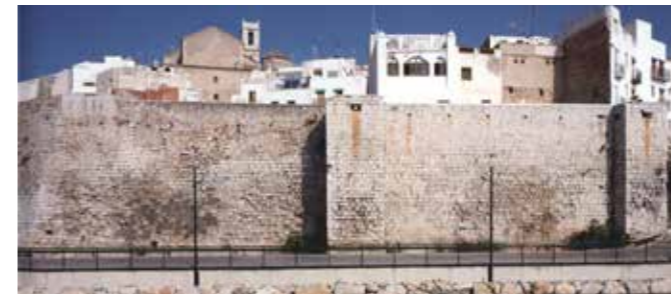
Vista de la muralla de la Fuente antes de las obras. (MJB 1999).
