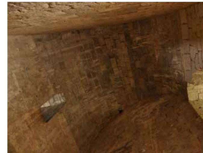
Bóveda de la sala anexa a la Casa de la Cisterna. (MJB 2010).
