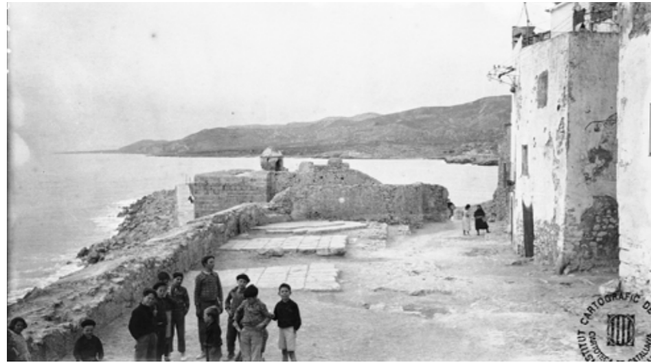
Fig. 4.4.10. Vista de la batería de la Reina desde el baluarte del Príncipe hacia 1930. (I CGC. RF.48606)
