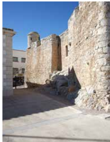
Fig. 4.1.198. Vista exterior del revellín para la protección de la puerta del castillo. Citado en la carta del Duque de Calabria de 1535, para las obras de fortificación en el castillo. (MJB 2016).
