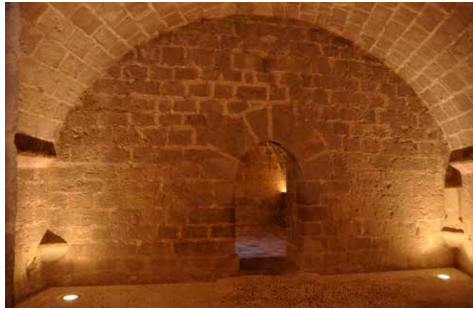
Fig. 4.1.29. Primera sala del cuerpo de guardia, con la puerta del aljibe. En las esquinas se ven los arranques de los nervios no construidos. (MJB 2015).
