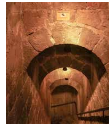
Fig. 4.1.173. Escalera de acceso desde el patio de armas con las bóvedas escalonadas. (MJB 2017).
