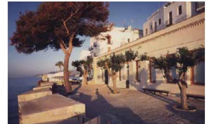
Vista exterior del Museo del Mar después de las obras. (MJB 1995).
