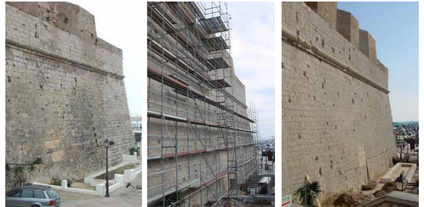
Vista del baluarte de Santa María antes, durante y después de las obras. (MJB 2000) (MJB 2001) (MJB 2002).
