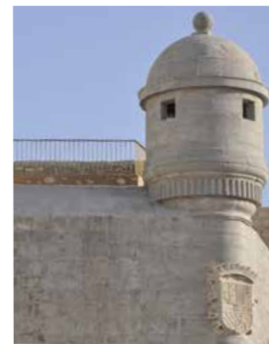
Fig. 4.2.77. Vista de la garita restaurada. (MJB 2012).
