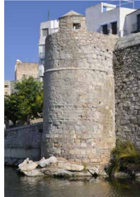
2010. Después de las obras. (MJB 2010).
