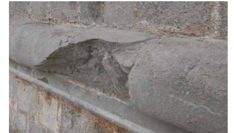
Albardilla remate de la Portada - obra con la realización de armado de varilla /después con reintegración de faltante y marcado de la fecha en zona superiores que se ve desde la plaza de enfrente (MJB 2010/2012)
