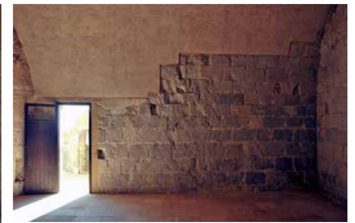
Fig. 4.1.113. Vista del muro con la puerta de salida a la terraza de la torre. (MJB 2015).
