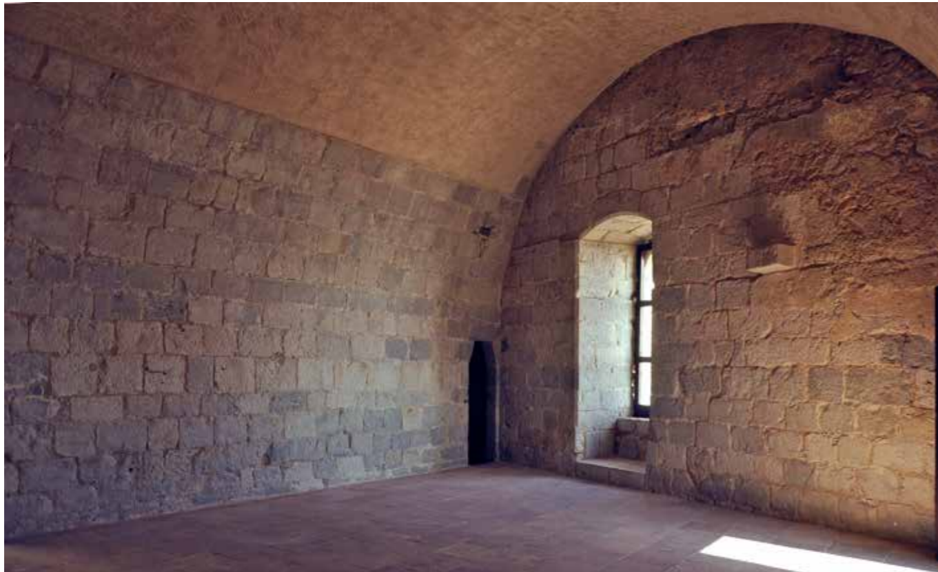
Fig. 4.1.108. Muro lateral izquierdo con arranque de la bóveda de sillería, y única puerta de acceso original a la cámara mayor. A la derecha ventana sobre la puerta principal. Bóveda de ladrillo construida a mediados del siglo XX, recientemente restaurada con revoco de cal. (MJB 2015).
