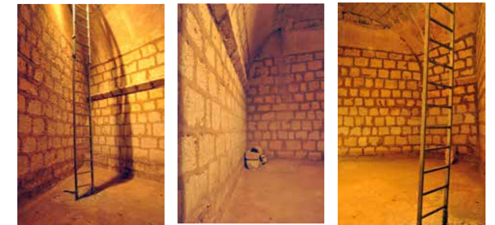
Fig. 4.1.57. Vistas generales del aljibe. En la del centro se puede apreciar una de las conducciones con huellas de la caída de agua.
