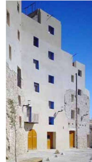
Fig. 4.3.30. Vista de las edificaciones de la plaza de Les Caseres construidas sobre la muralla medieval, tras la restauración realizada en 1998. (MJB 1998).
