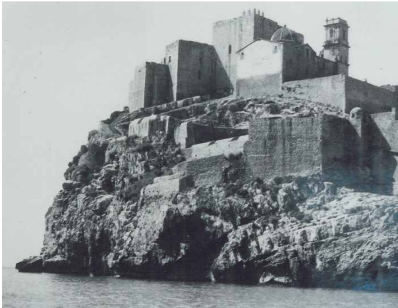
Fig. 4.4.61. Vista de las baterías alta y baja del Maset desde el nivel del mar hacia mediados de siglo XX. Se puede ver la continuidad de la fábrica antigua en la parte inferior de la batería baja del Maset y los muros semiderruidos exteriores. Más retrasado el nuevo muro con merlones que debió hacerse a finales del XVIII o principios del XIX. (Foto cedida por J. Esbri).
