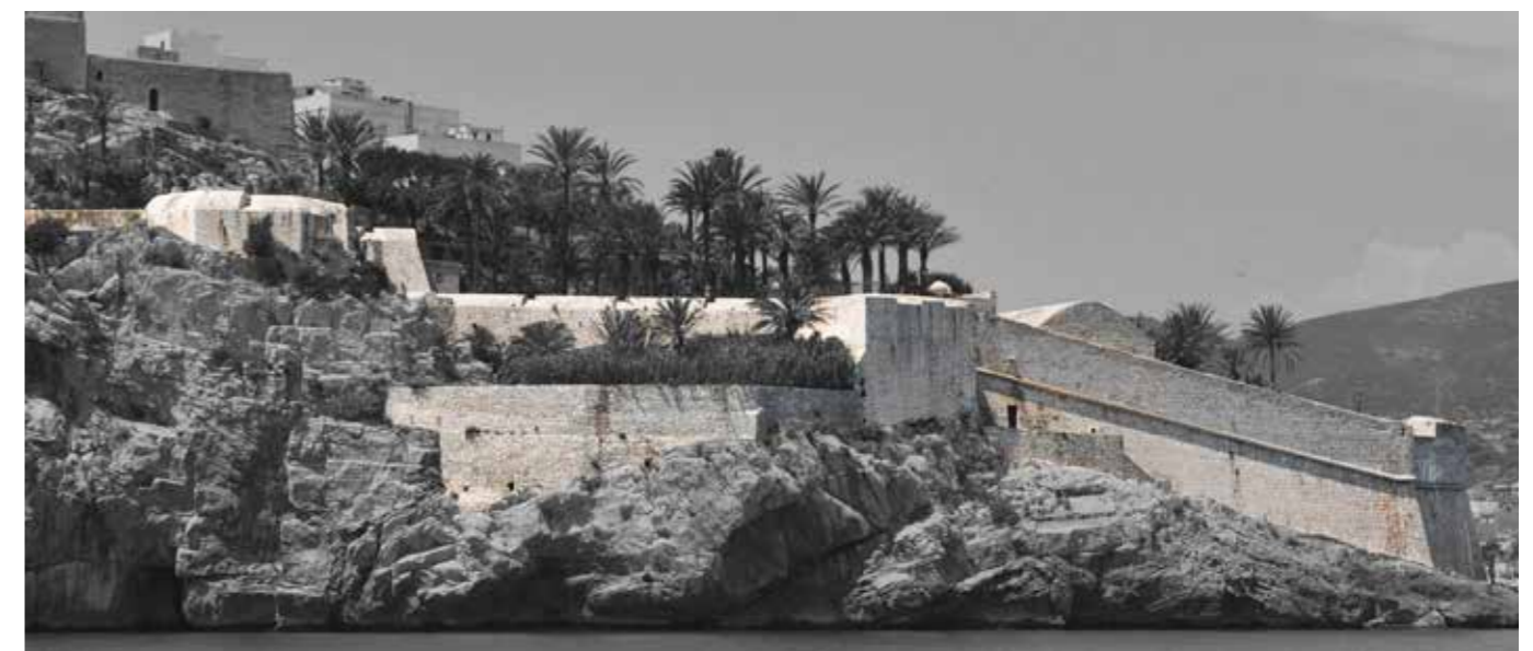
Fig. 4.4.58. Vista actual de las baterías alta (Boctoglio) y baja del Maset, con el muro de unión entre ambas y la plataforma baja delante, que integra en su base parte del antiguo lienzo medieval. Se puede ver a la derecha la conexión entre la batería baja del Maset y la cortina del Olvido, donde empieza la muralla de Felipe II. (MJB 2010).
