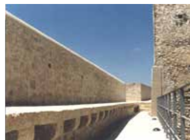
Fig. 1.2. Fotos comparativas de la localización del paso de ronda medieval en proyecto piloto. Arriba al hacer las catas y abajo después de la obra. (MJB 1996-1998)
