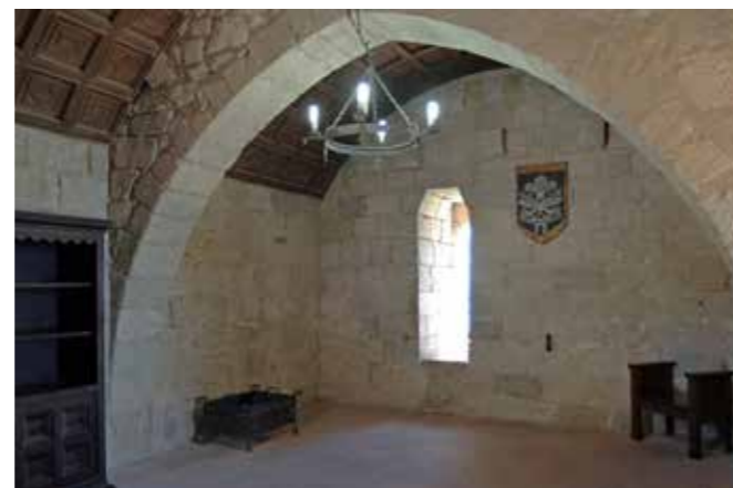
Fig. 4.1.122. Vista del arco diafragma ojival y la ventana este. (MJB 2014).
