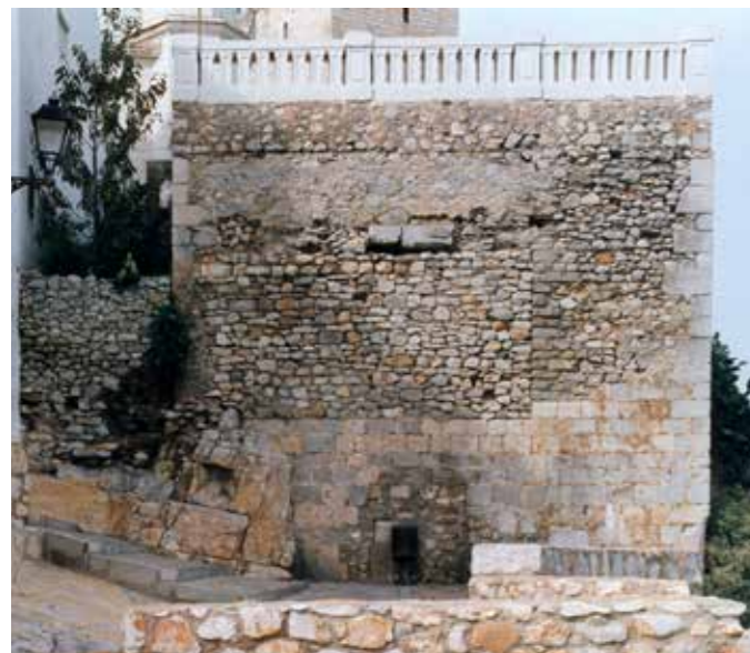
Almacén de Pólvora antes de las obras. (MJB 2000).
