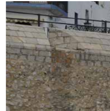
Fig. 4.3.52. Detalle de los parapetos abocelados. (MJB 2012).
