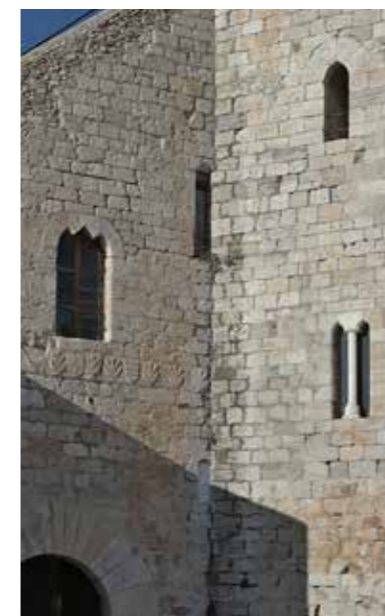
Fig. 4.1.90. Vista de los tragaluces en la esquina de la fachada. (MJB 2016).
