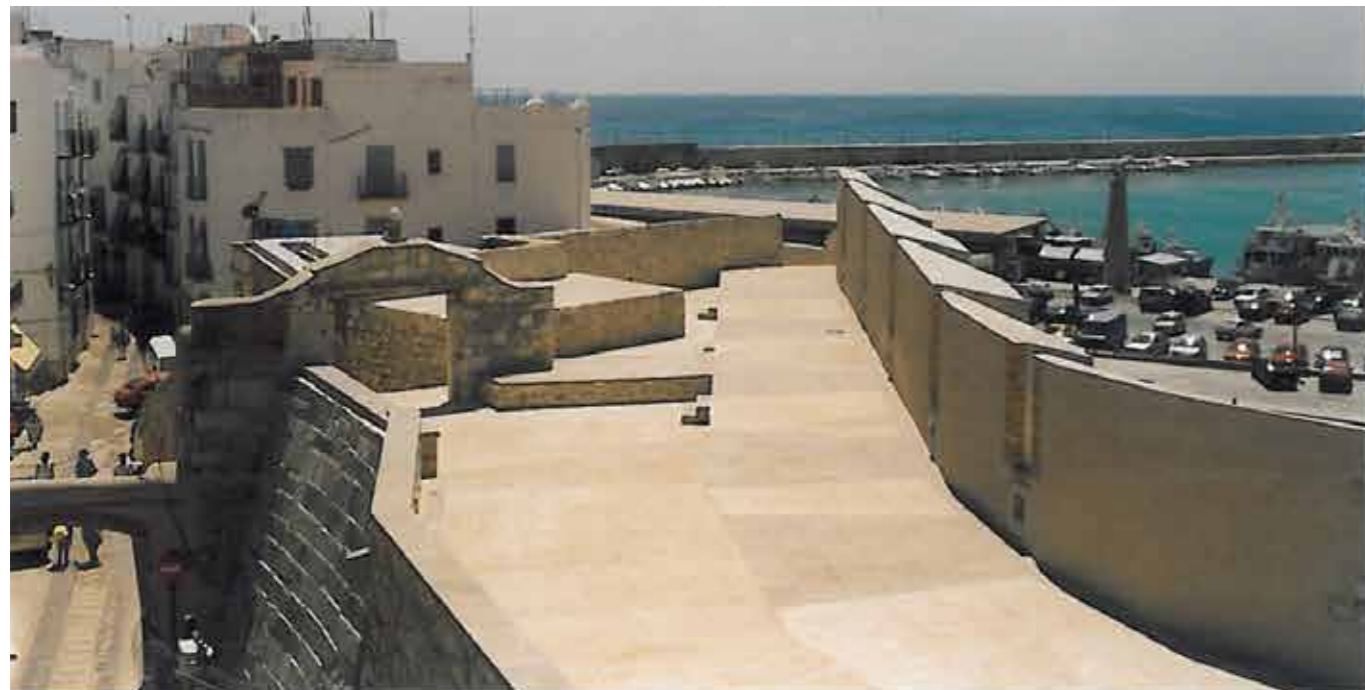
Fig. 4.3.21. Foto de la batería de Santa Ana después de la restauración. (MJB1999).
