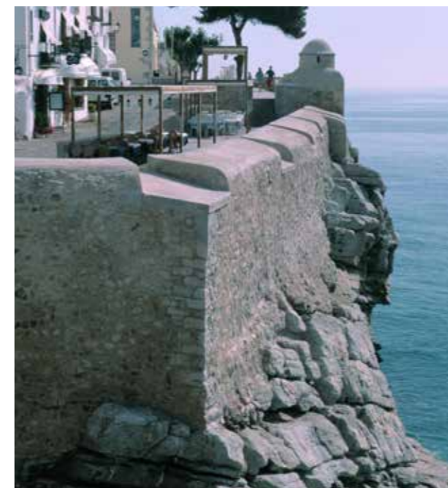
Fig. 4.4.14. Vista de la batería de la Reina y el baluarte del Príncipe después de la restauración. Se ven los nuevos diseños de pérgolas realizadas en ese momento para dejar paso junto a la muralla. (MJB 2002).
