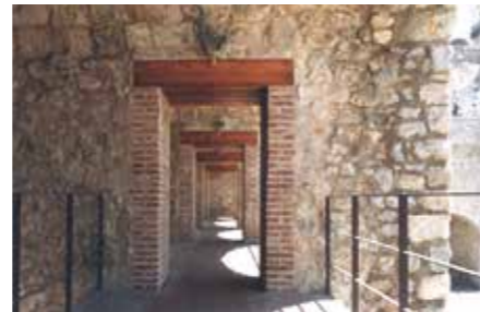
Después de las obras. (MJB 1998).
