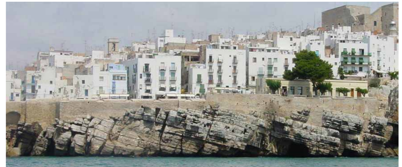
Bateria de la Reina y baluarte del Príncipe después de las obras. (MJB 2002).
