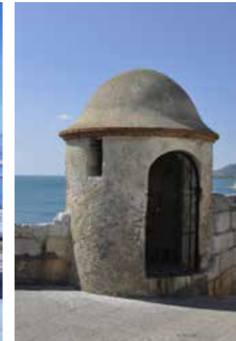
2010. Después de las obras. (MJB 2010).
