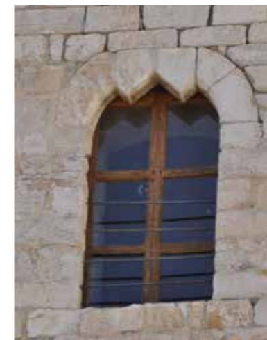
Fig. 4.1.111. Ventana sobre la puerta principal (MJB 2015).
