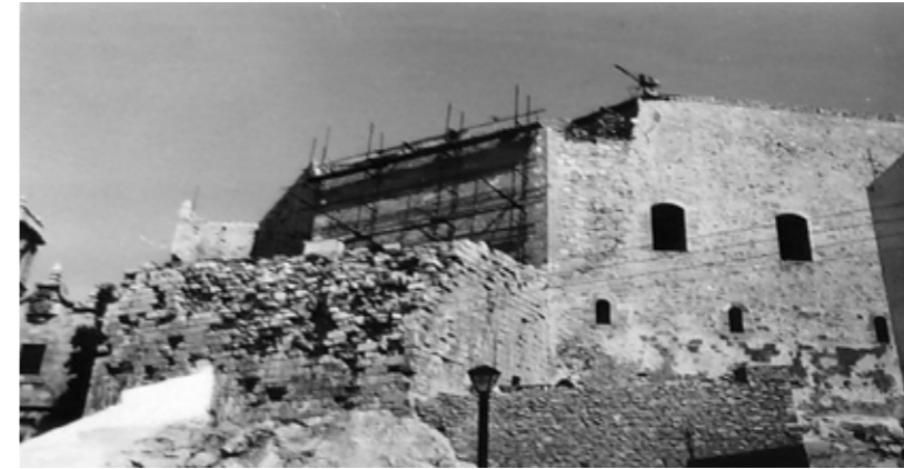
Andamio en la cara oeste del Salón Gótico (obras C. Ungría 1970)
