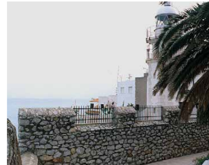
Vista de la terraza del faro antes de las obras. (MJB 2000).
