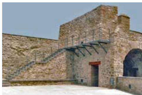
Después de las obras. (MJB 1998).
