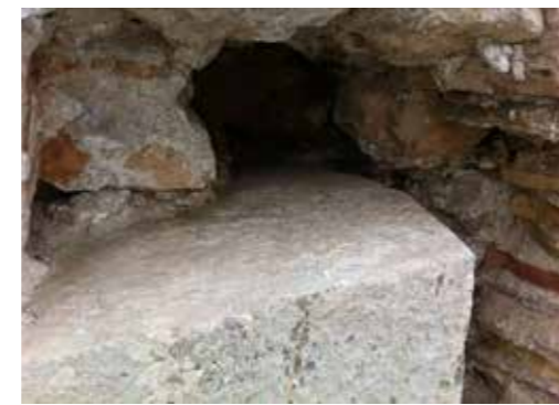
Figura 4.2.40. Remates de cantería bajo revestimiento moderno y cata en la esquina. (MJB 2013).
