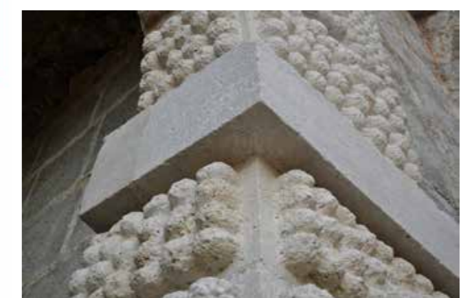
Fig. 4.2.66. Detalle del ornamento con bolas y de la albardilla. (Balaguer 2012).
