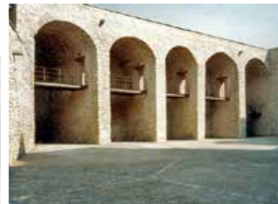
Después de las obras. (MJB 1998).
