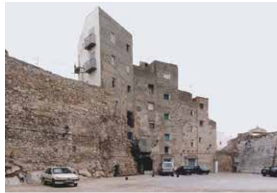
Antes de las obras. (MJB 1996).
