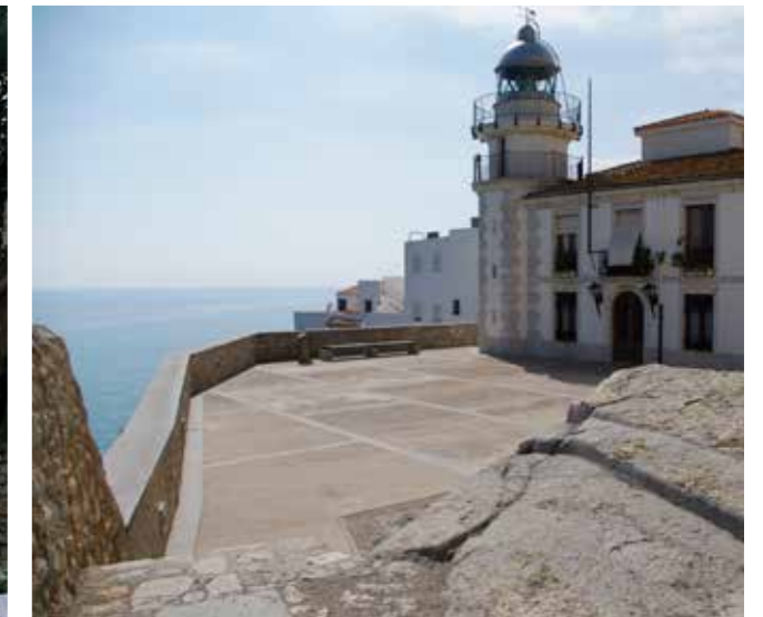
Vista de la terraza del faro después de las obras. (MJB 2002).
