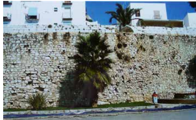
1990. Antes de las obras. Fotos del proyecto. (C. Bento).
