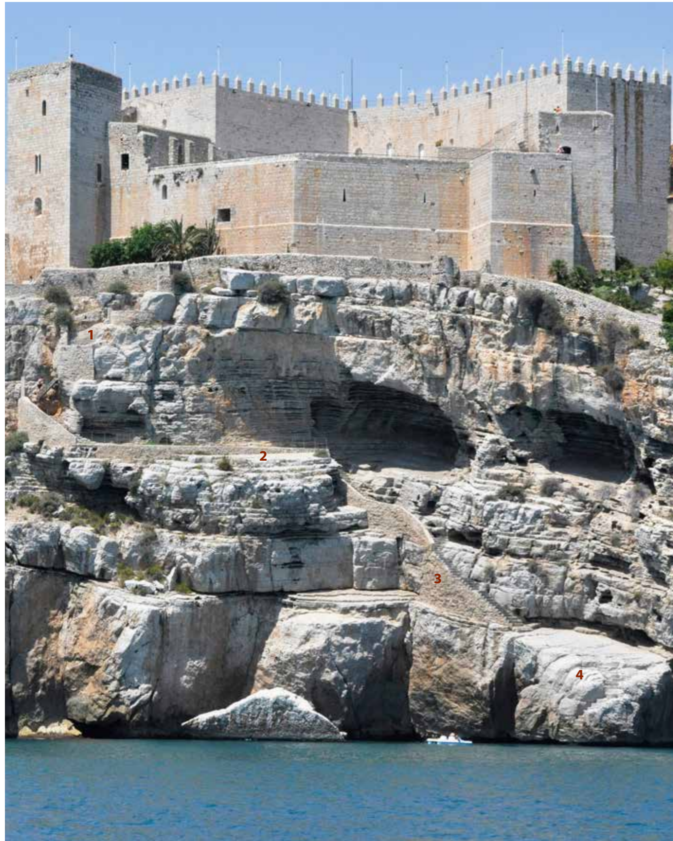
Fig. 4.4.46. Vista desde el mar de la escalera del Papa Luna. Arriba a la izquierda acceso y primer tramo, tapado por las rocas y muros de mampostería hasta el puente levadizo (1). En el centro tramo horizontal bajo las rocas (2). A la derecha abajo tramo sinuoso adaptándose a las rocas sobre muro de mampostería (3). En la esquina inferior derecha peldaños tallados en la roca hasta la orilla (4). (MJB 2010)
