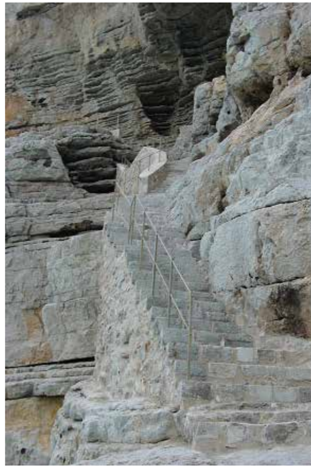
Fig. 4.4.49. Vista del último tramo de la escalera después de su restauración. (MJB 2010).
