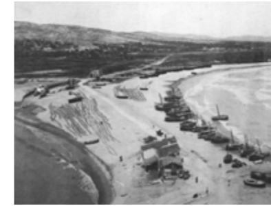
Fig. 4.3.3. Vista del tómbolo a principios de siglo XX. Las barcas se dejaban sobre la playa y había mucha inseguridad para los pescadores. Por este motivo se emprendió la construcción del puerto en el siglo XX.
