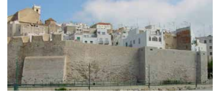
Vista de la muralla de la Fuente después de las obras. (MJB 2002).
