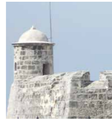
Fig. 4.2.117. Parapeto abocelado de cantería diseñado por B. Antonelli para San Salvador de la Punta en la Habana. (J. Mulet 2014).
