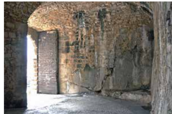
Fig. 4.2.56. Interior del portal antes de la restauración. Puerta exterior y hoja de la puerta. (MJB 2010).
