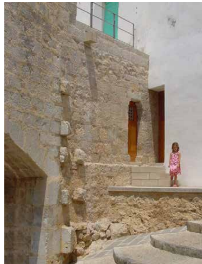
Fig. 4.3.45. Foto del portal Sant Pere tras la restauración de 2002, que dejó al descubierto el antiguo acceso al cuerpo de guardia y donde se ve que el paramento de sillería del torreón formaba parte del propio portal. (MJB 2002).
