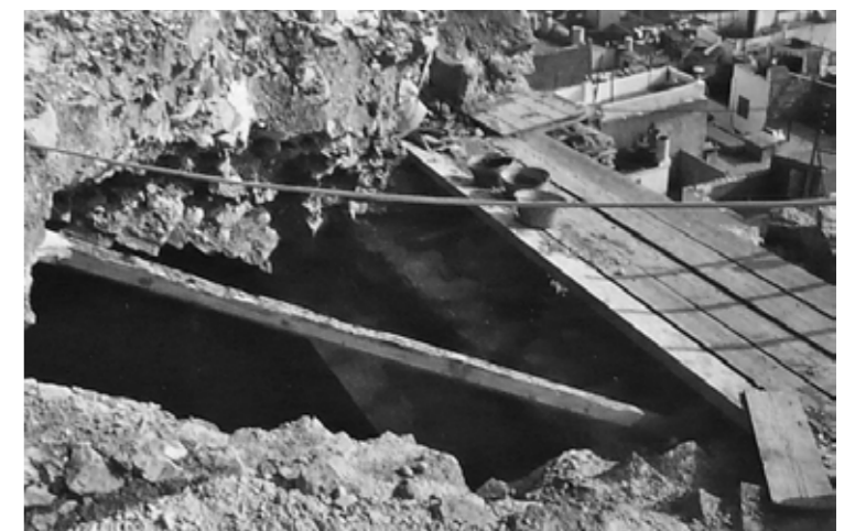
Reparación de la cubierta del salón gótico, desde el exterior. (V. Caballero 1970).
