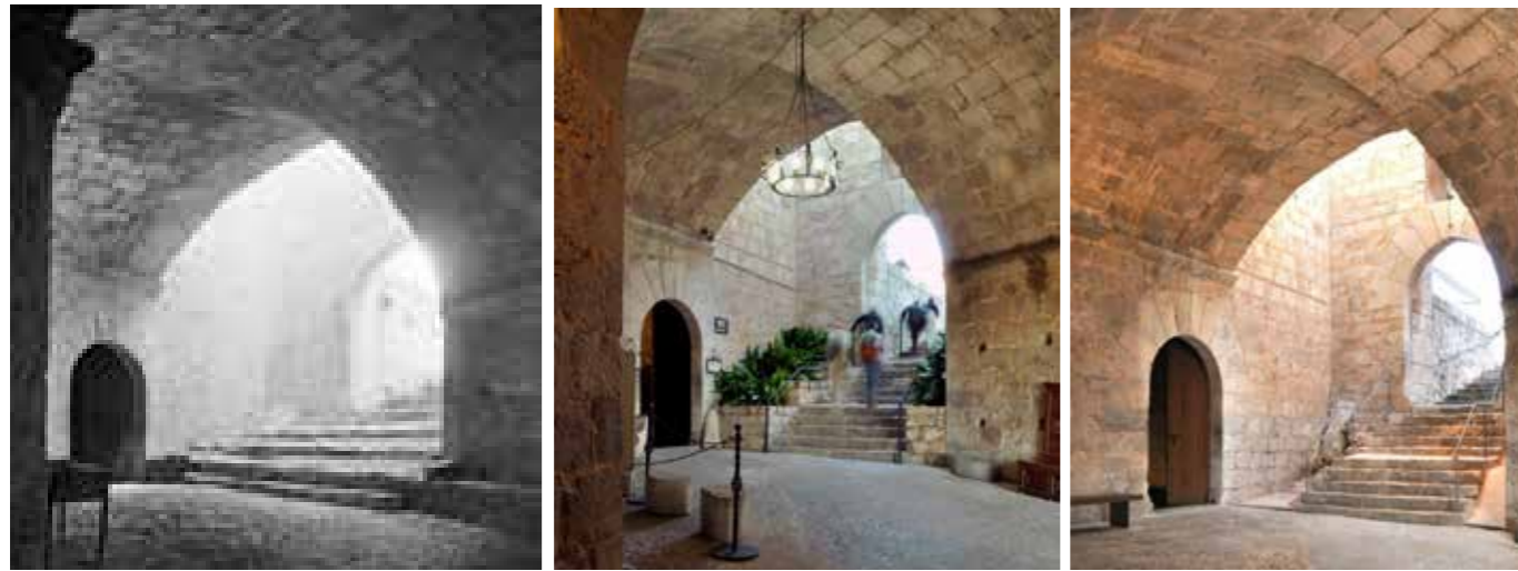
Fig.1.15 . Vistas de escalera del castillo en diversos momentos, a la izquierda foto de 1950 que ha inspirado la restauración, en el centro en 2013, estado anterior a la restauración y a la derecha estado final en 2015 tras eliminar maceteros y dejar a la vista rocas y vestigios localizados de las sucesivas fases de la escalera.
