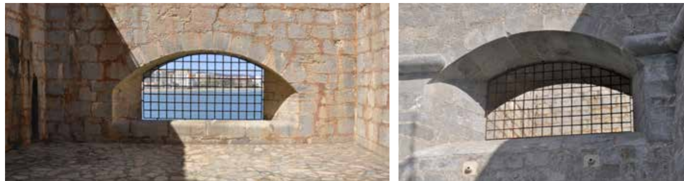
Fig. 4.2.13. Arriba, lienzos con las cañoneras bajas de las casamatas. A la izquierda la mayor (C3) y a la derecha la menor (C2). Planos de proyecto (MJB 2010). Abajo, tronera de la casamata mayor (C3) desde el interior con el parapeto abocelado, y a la derecha, desde el exterior. (MJB 2012).
