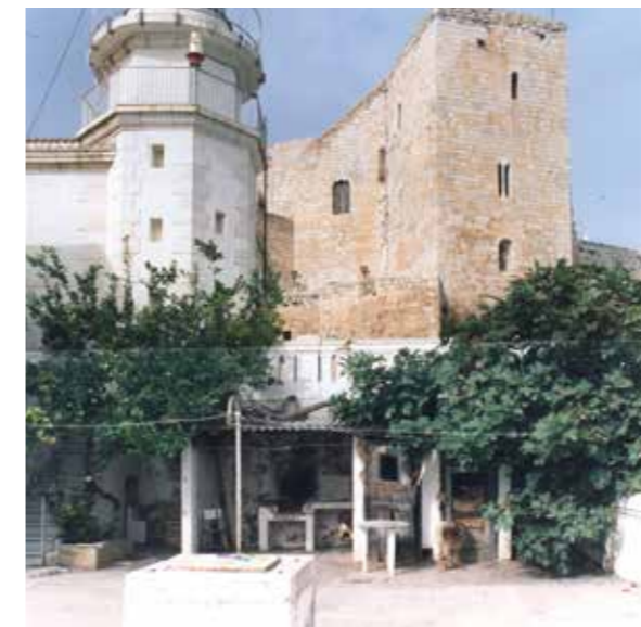
Vista de la cubierta del almacén antes de las obras. (MJB 2000).
