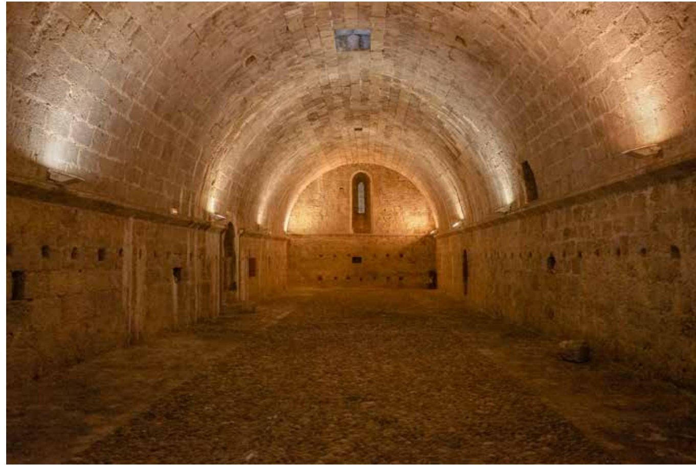
Fig. 4.1.168. Saló del Cónclave. Vista hacia el oeste. En el muro de la izquierda, entrada desde el patio de armas con el primer peldaño de trazado curvo y a la derecha puerta de acceso a la mazmorra. Al fondo ventana con arco de medio punto similar a la de la iglesia y a la derecha sobre la moldura, una de las dos ventanas de dintel recto y esquinas achaflanadas que hay en el muro norte. Los huecos de las paredes podrían corresponder a estructuras de madera para las camas de los soldados o para el servicio de la bodega. (MJB 2017).
