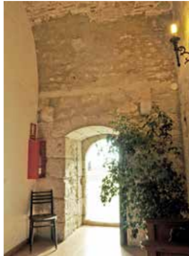
Fig. 4.1.163. Vista del acceso desde la terraza sobre el salón del Cónclave. (MJB 2016).
