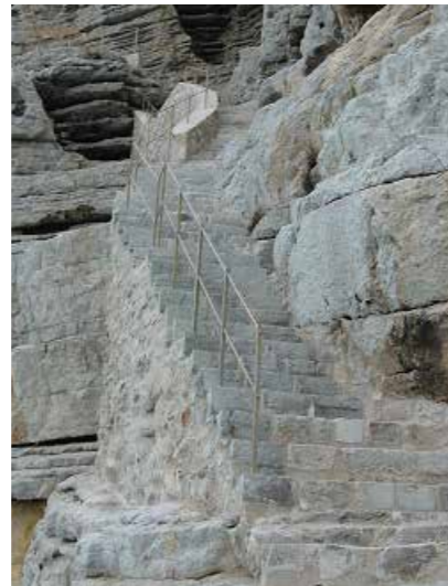
Tramo inferior de la escalera después de las obras. (MJB 2002).
