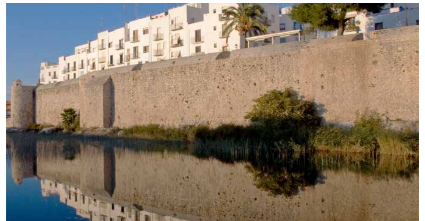
Fig. 4.3.53. Vista de la batería del Bufador hacia la torreta del Papa Luna. En la parte central se ve un resalte que se correspondería con una de las torres de la muralla medieval cuyas almenas se derribaron en el siglo XVI. (MJB 2009).
