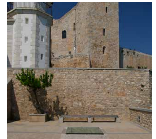
Vista de la cubierta del almacén después de las obras. (MJB 2002).
