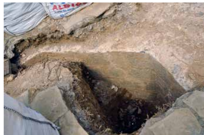
Fig. 4.2.25. Cata 1 en la batería del Calvario, donde localizamos en 2013 el muro de cierre de la casamata con chaflán y sin contrafuertes, según se ve plano de Desnaux. Aquí se produjo un cambio de plan respecto al proyecto de Gonzaga. (Balaguer 2013).
