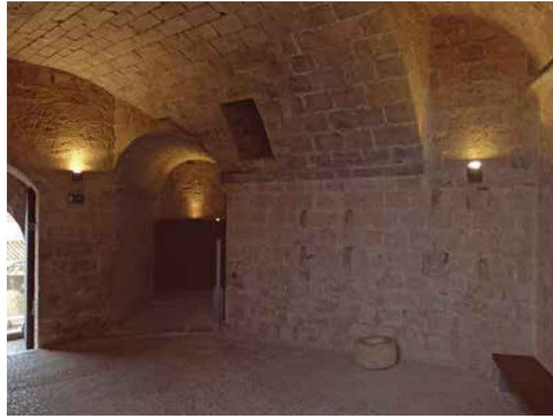
Fig. 4.1.24. Base de la torre izquierda y tragaluz en la bóveda principal. (MJB 2015).
