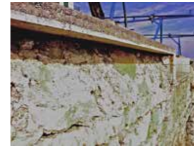
Fig. 4.4.32. Vista de los merlones del baluarte del Príncipe desde el acantilado, donde se ve la traza curva por debajo del aplacado de 1993. (MJB 2001).
