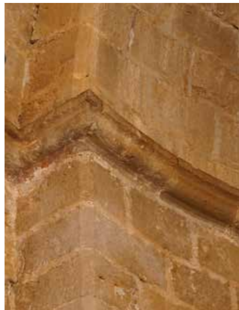
Fig. 4.1.157. Detalle de la imposta de sección curva. (MJB 2013).
