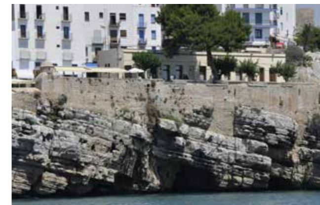
Vista del baluarte del Príncipe y el edificio Les Costures. (MJB 2010).
