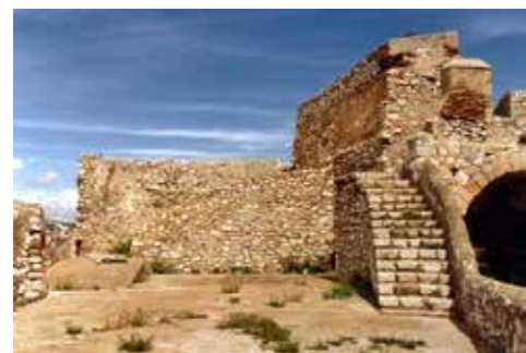
Antes de las obras. (MJB 1996).
