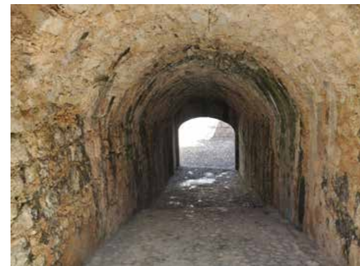
Fig. 4.2.17. Túnel T1 de acceso a la casamata mayor C3. (MJB 2012).
