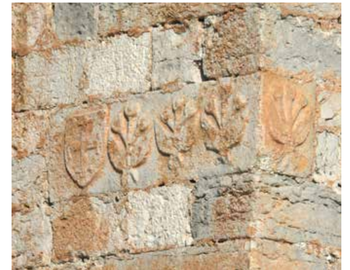
Fig. 4.1.185. Piedra labrada en la esquina de la torre maestra. (MJB 2015).
