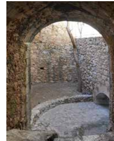
Fig. 4.2.16. Túnel T1 de acceso a la casamata menor C2. (MJB 2012).
