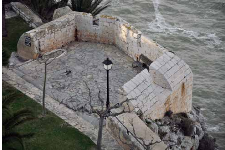
Fig. 4.4.59. Tramo de muralla entre las baterías baja y alta del Maset, con los dos niveles y los remates con sección curva y troneras. (MJB 2012).
