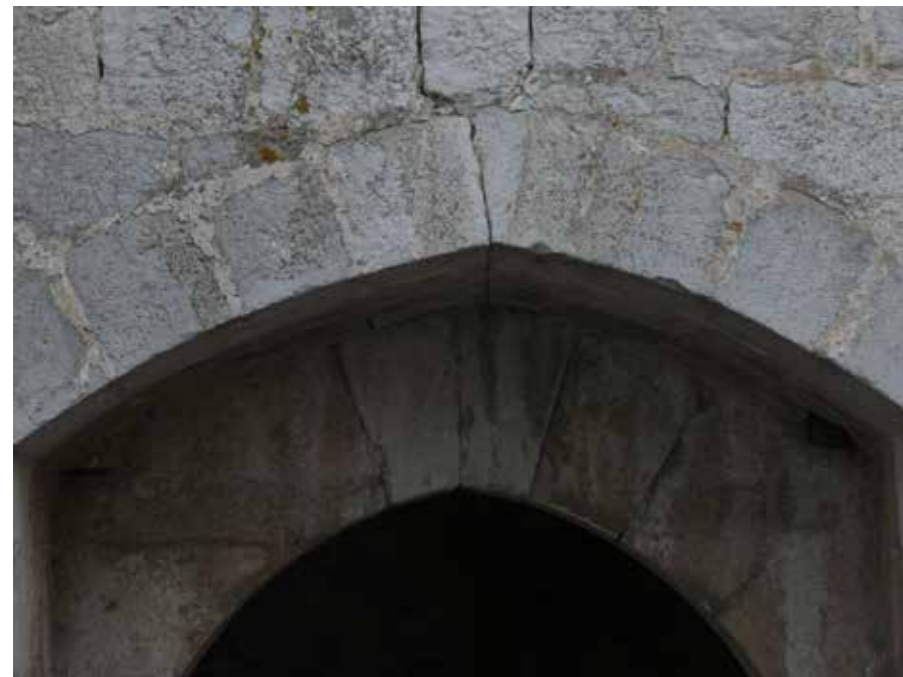
Fig. 4.1.179. Capialzado de la puerta de acceso al patio de armas. (MJB 2015).
