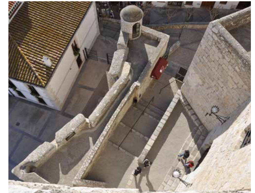
Fig. 4.1.15. Vista superior del bastión construido en la primera mitad del siglo XVI. (MJB 2016).
