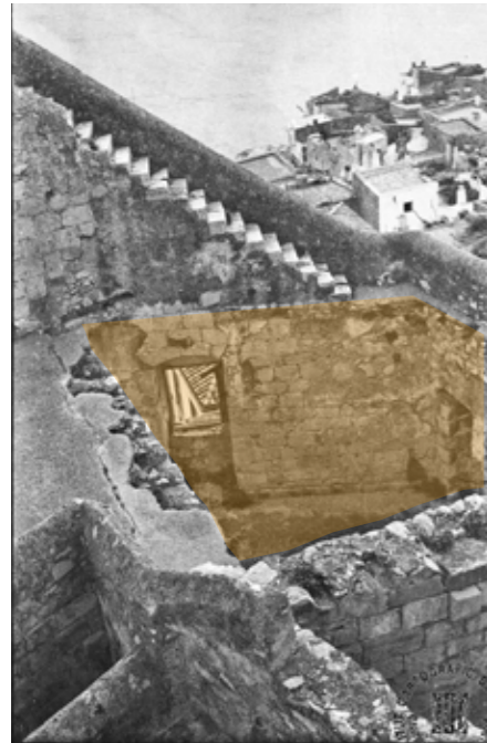
Fig. 4.1.114. Fotografía de principios de siglo XX donde se puede observar la sala antes de la construcción de la bóveda de ladrillo. En trama se ha superpuesto el nivel que tendría el pavimento de la terraza antes de la destrucción del siglo XIX. (ICGC. RF.48614)
