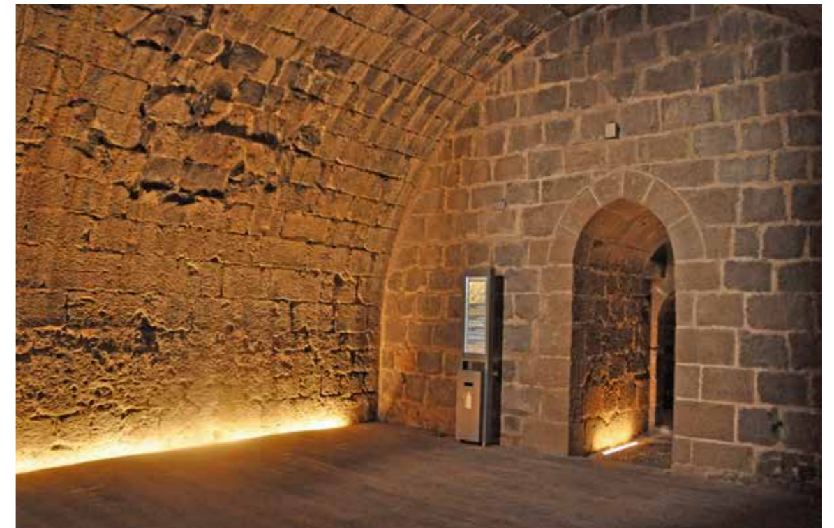
Fig. 4.1.64. Entrada desde la sala del fondo del estable, donde se puede apreciar la reconstrucción del hueco de paso y el muro, y la bóveda deteriorada por la explosión. (MJB 2015).
