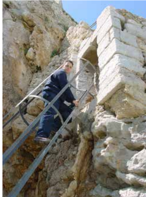
Tramo superior de la escalera antes de las obras. (MJB 2000).
