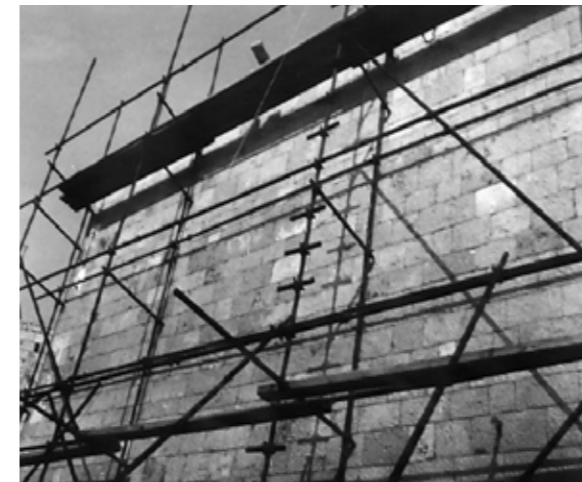
Vista de los andamios en los paramentos exteriores. (V. Caballero 1970).
