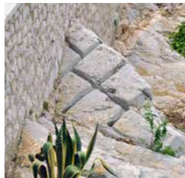
Fig. 4.2.102. Cortes en la roca para extraer bloques de piedra junto a la rampa de Felipe II que evidencian el proceso de trabajo de los "arrancadors." (Balaguer 2013).
