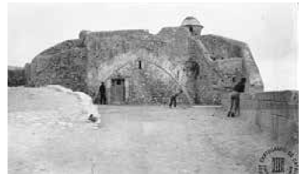
Fig. 4.3.58. Vista del fortín del Bonete desde la calle Atarazanas. El arco apuntado está tapiado con puerta y hueco superior para uso indeterminado. (ICGC. RF. 48605).
