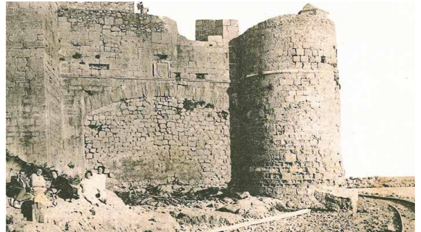
Fig. 4.3.41. Foto de la década de 1920, durante la construcción del puerto, donde apreciamos la proporción original del arco (Cedida por J. Esbri).
