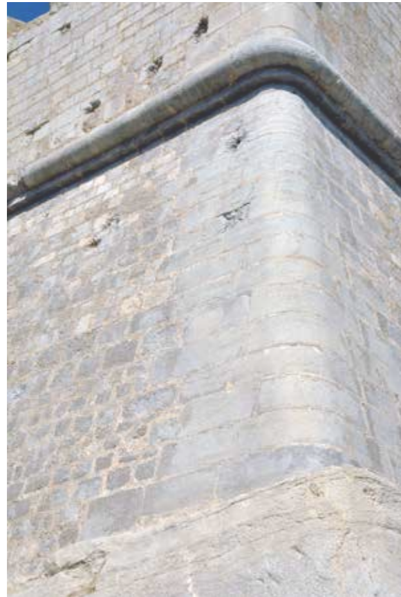
Fig. 4.2.98. Esquina sur del Baluarte Real. Sillería montada sobre la roca labrada y cordón tipo 1. (MJB 2013).
