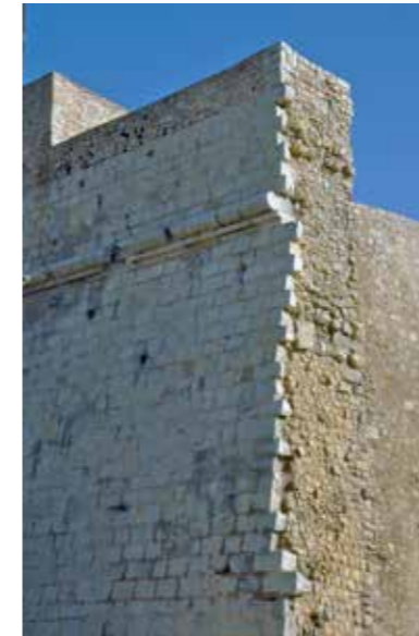
Fig. 4.2.86. Sección de la muralla en el extremo sur donde se interrumpió la obra del proyecto de Gonzaga. (MJB 2012).
