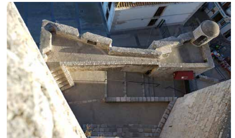
Fig. 4.1.201. Vista superior del revellín, con las troneras y las dos plataformas para la artillería. La garita es una construcción del siglo XX. (MJB 2016).
