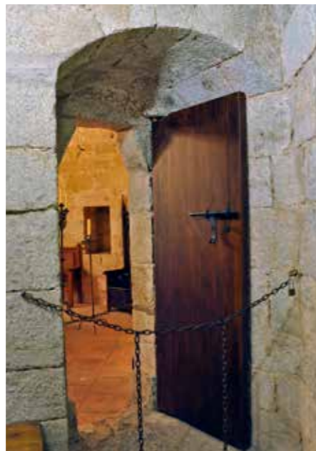
Fig. 4.1.156. Puerta de la sacristía hacia el presbiterio. (MJB 2013).
