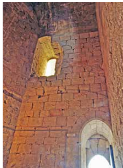
Fig. 4.1.141. Huecos de la sala anexa al patio de armas. Huellas de bóveda. (MJB 2012).
