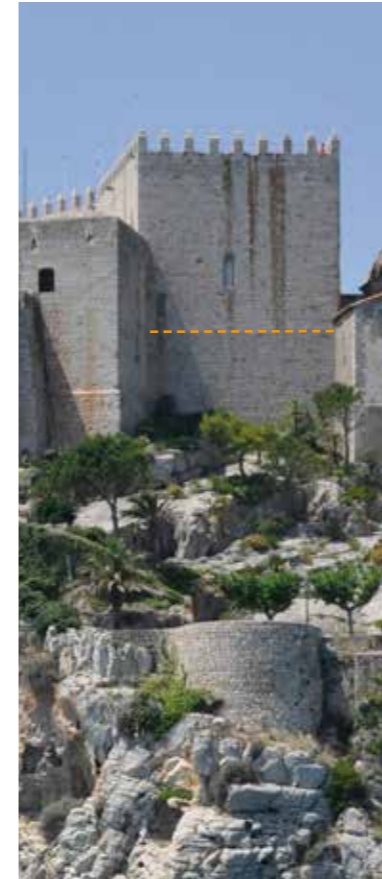
Fig. 4.1.158. Vista exterior de la iglesia con las ventanas del ábside y de la sacristía. Con línea de puntos se marca el nivel del pavimento de la nave. (MJB 2010).
