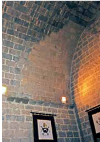
Bóveda del Salón Gótico. Esquina reparada (MJB 2010)
