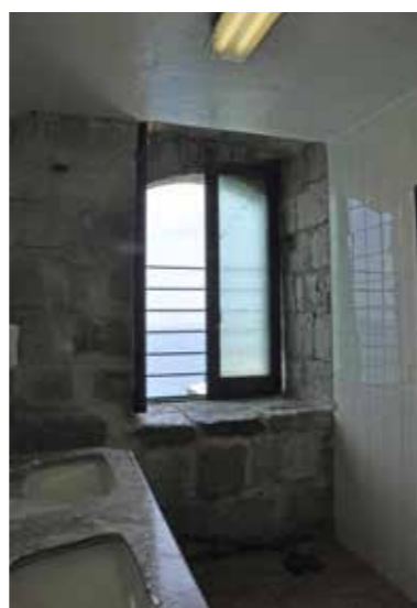
Fig. 4.1.165. Vista de la ventana desde el interior. (MJB 2016).
