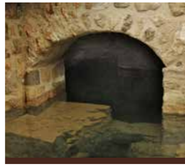
Fig. 5.12. Vista del arco de acceso a la caja de la fuente, descubierta en la restauración tras los revestimientos de aplacado de una escalera hecha en el siglo XX. (MJB 1999).
