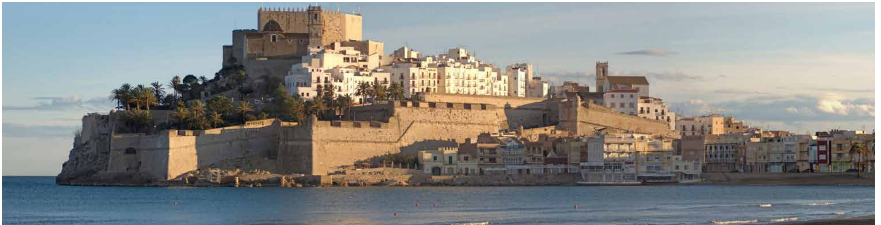
Fig. 4.2.2. Vista de la muralla desde la playa norte. (MJB 2010).
