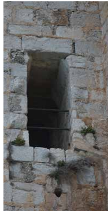
Fig. 4.1.100. Vista exterior del hueco de la probable letrina. Pueden observarse las piedras rotas que evidencian la existencia de un cuerpo volado. (MJB 2015).
