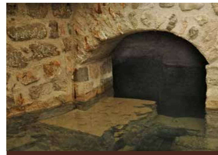
Fig. 4.3.11. Vista del arco de acceso a la caja de la fuente, descubierta en la restauración tras los revestimientos de aplacado de una escalera hecha en el siglo XX. (MJB 1999).
