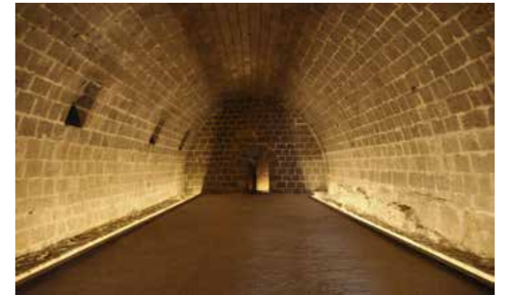
Sala caballerizas antes (MJB 2014) y después de las obras (MJB 2015). En los laterales se deja a la vista el nivel de suelo original descubierto y la base del muro labrada en la roca.
