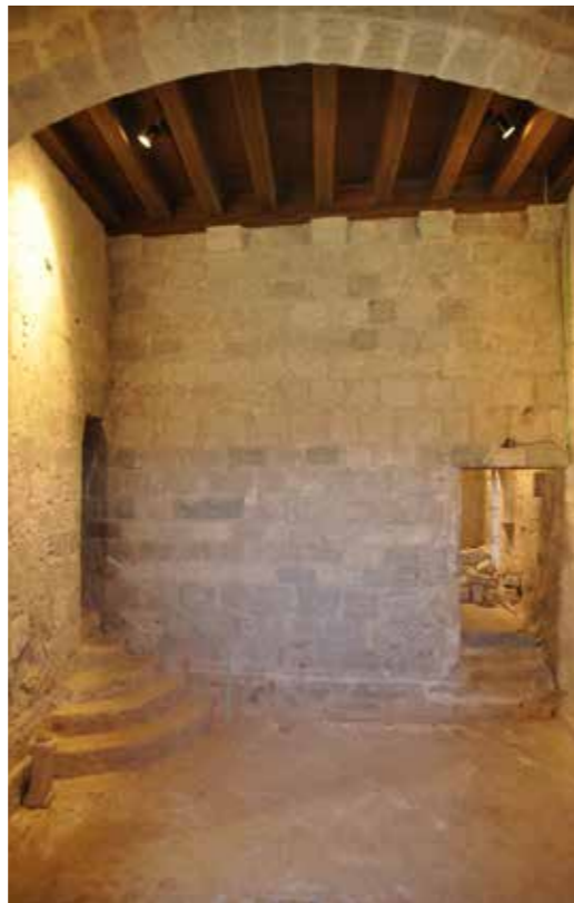
Fig. 4.1.95. Vista desde el muro este. A la izquierda, escalera del acceso original, a la derecha, el acceso moderno abierto posiblemente en el siglo XIX. En el pavimento se pueden ver las canalizaciones de yeso. (MJB 2015).
