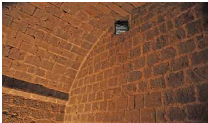
Fig 4.1.54. Hueco de ventilación desde el interior. (MJB 2015).
