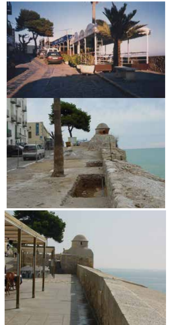
Fig. 4.4.18. Batería de la Reina. Arriba, antes de la restauración en 1998 donde se ve la rampa de la calle. En medio, proceso de catas en año 2000, donde ya localizamos los niveles y piezas de plataformas y parapetos. Abajo, resultado final en 2002 tras recuperar los niveles a la cota original de la batería integrando las plataformas. (MJB 1998-2002).
