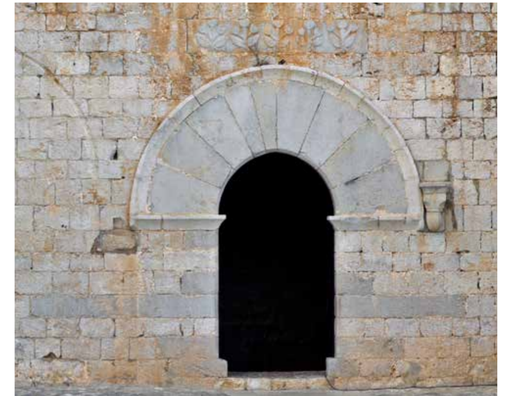
Fig. 4.1.159. Vista frontal de la puerta de la iglesia. (MJB 2016).
