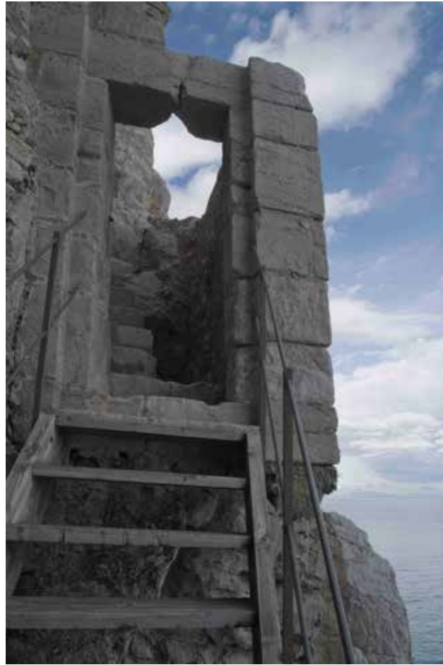
Fig. 4.4.48. Vista de la puerta del puente levadizo y escalera de madera, realizada en la restauración del año 2000. (MJB 2010).
