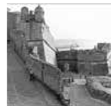
Fig. 3.32. Restos de la batería La Preciosa y muros de protección del portal Fosc en 1956. Detalle. (N. Sánchez Calvo).
