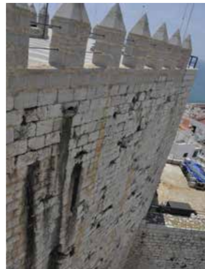
Vista de la gargola de desagüe de la cubierta. (MJB 2010).
