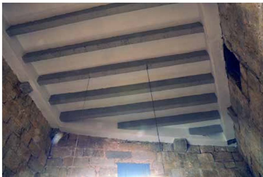
Fig. 4.1.117. Cuarto de las campanas. Cubierta de vigas de hormigón. (MJB 2015).
