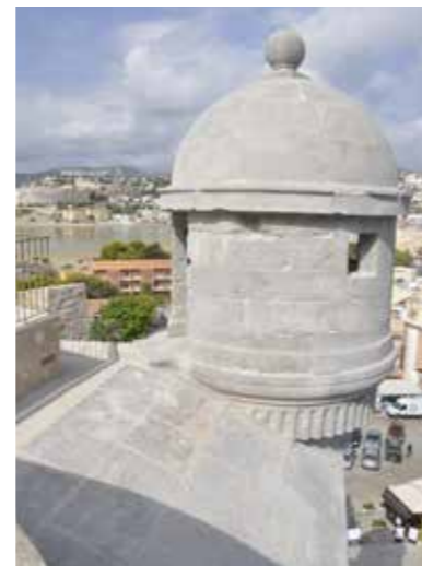
Fig. 4.2.115. Garita y parapeto corrido abocelado. (MJB 2012).
