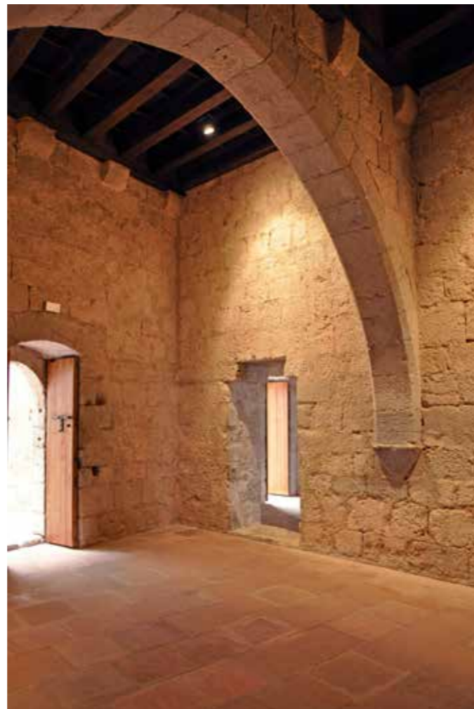
Fig. 4.1.87. Vista de la entrada y el hueco con la estancia 1. (MJB 2015).
