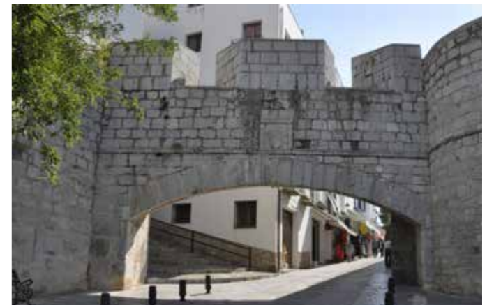
2010. Después de las obras. (MJB 2010).
