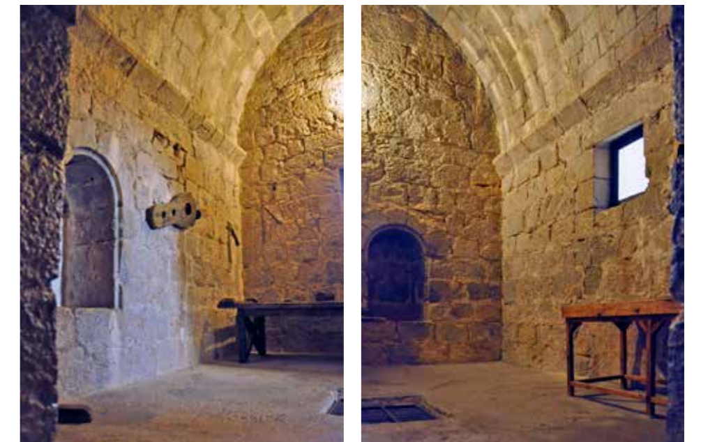
Fig. 4.1.174. Vista de la mazmorra superior desde la entrada con dos hornacinas, dos ventanas rectangulares y la trampilla de comunicación con la mazmorra inferior. (MJB 2013).
