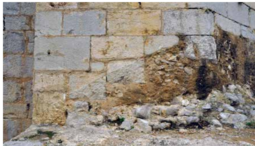
Fig. 4.2.47. Huellas de la marca del parapeto abocelado desaparecido en el muro lateral de una de las troneras. (Balaguer 2013).
