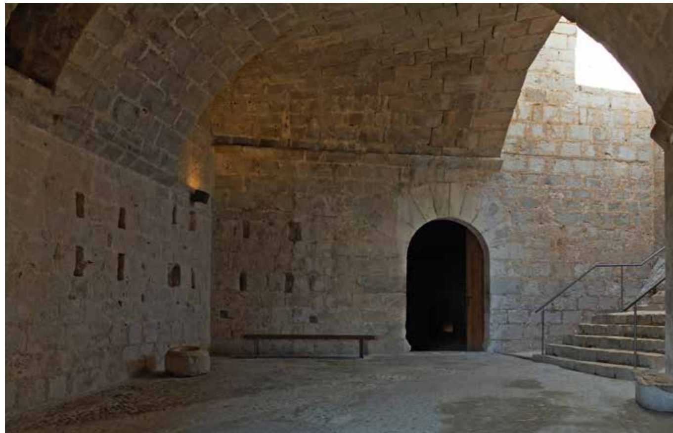
Fig. 4.1.26. Vista del zaguán hacia la entrada de las caballerizas. (MJB 2015).
