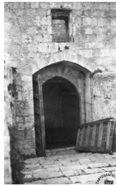
Fig. 4.1.25. Hojas de la puerta de acceso al patio de armas. 1930. (ICC. RF. 48612)
