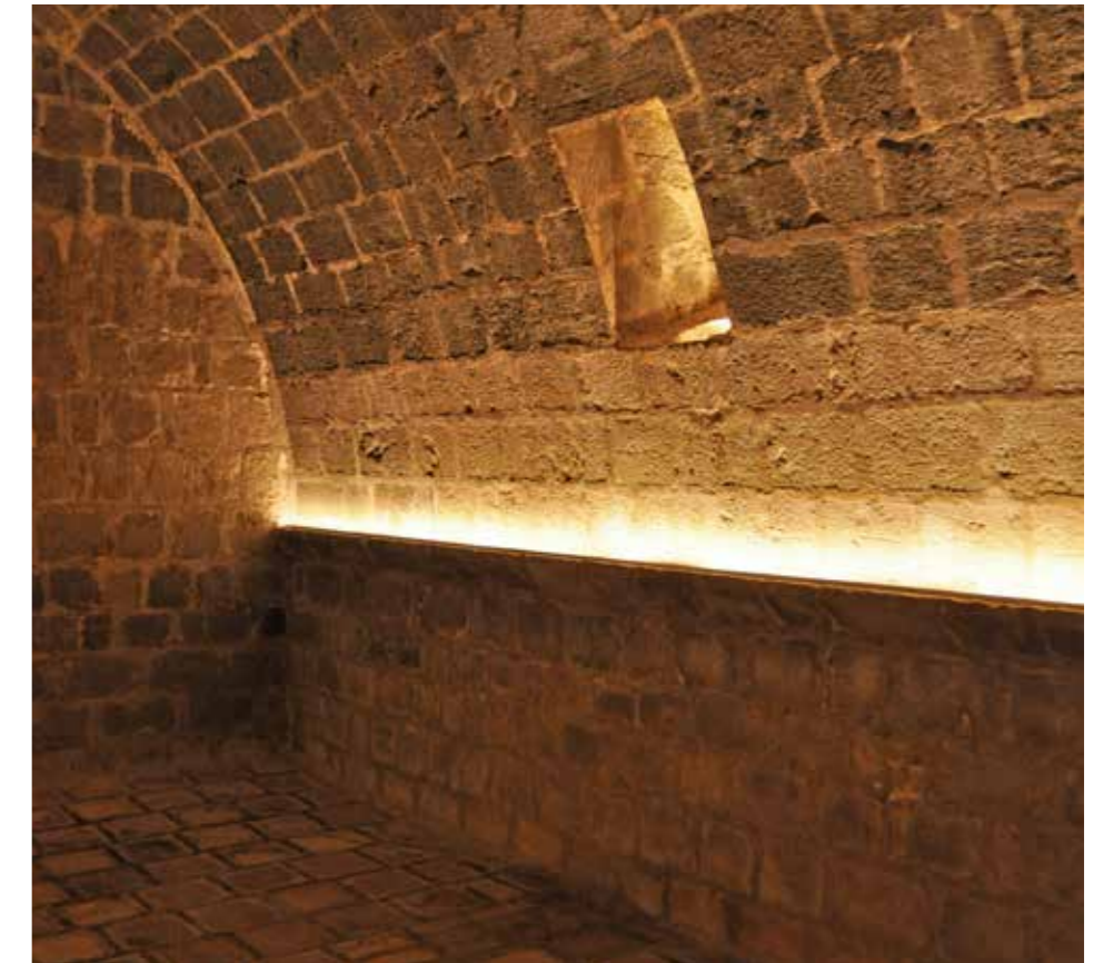
Fig. 4.1.39. El aljibe. Hueco tragaluz en la bóveda atravesando el muro derecho. (MJB 2015).
