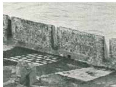
Fig. 5.14. Detalle de la foto de la batería de Santa Ana en el libro de Febrer Ibáñez (Febrer 1924, 36), en la que descubrimos que había cinco plataformas de artillería. Después en las obras comprobamos que solo quedaba una sexta, que no aparece en la foto, que descubrimos al levantar el pavimento.
