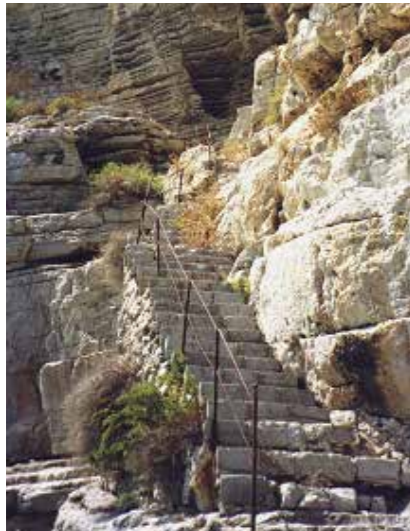
Tramo inferior de la escalera antes de las obras. (MJB 2000).
