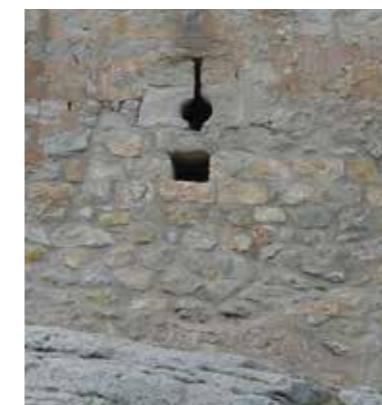
Fig. 3.11. Tronera de palo y orbe, bajo el baluarte del Príncipe. (MJB 2001).
