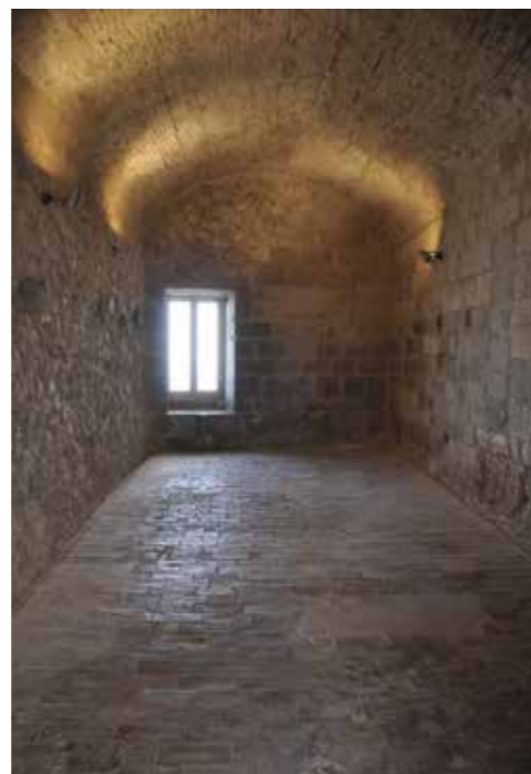
Fig. 4.1.81. Interior de la sala después de la restauración. Vista hacia la ventana. Pavimento, muro de mampostería y bóveda de ladrillo del siglo XIX. (MJB 2015).
