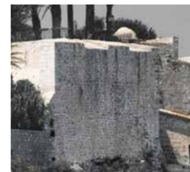
Fig. 4.4.68. Parapetos y troneras de la batería baja del Maset. (MJB 2010).
