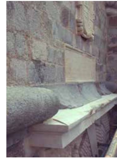
Fig. 4.2.64. Vista de la albardilla, cordón, moldura en caveto invertido, cartela y escudo, recién restaurados. (Balaguer 2012).
