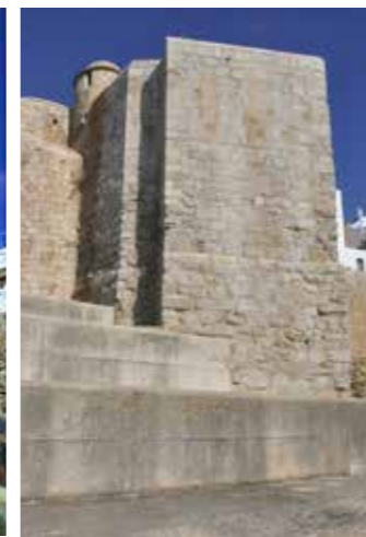
2010. Después de las obras. (MJB 2010).
