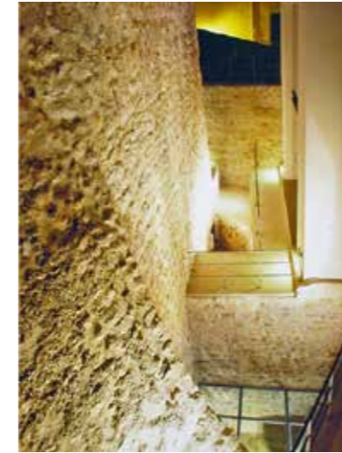
Fig. 4.3.16. Foto de muro del manantial y zonas de la caja de la fuente y manantiales tras ser descubiertos e iluminados en la restauración de 1999. (MJB 1999).
