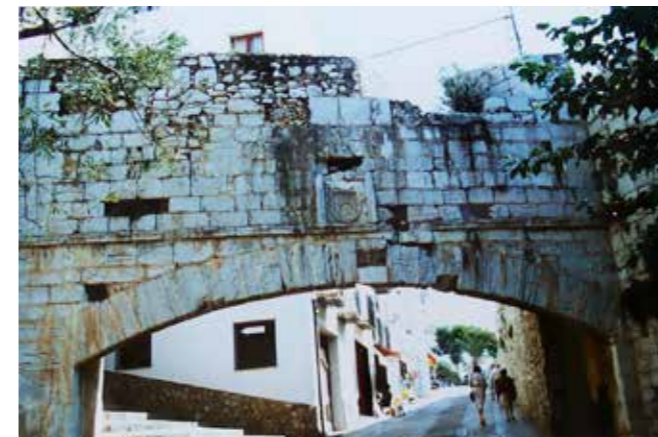
1990. Antes de las obras. Fotos del proyecto. (C. Bento).
