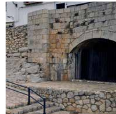
Fig. 4.2.22. Arco de acceso al túnel T4. (MJB 2013)
