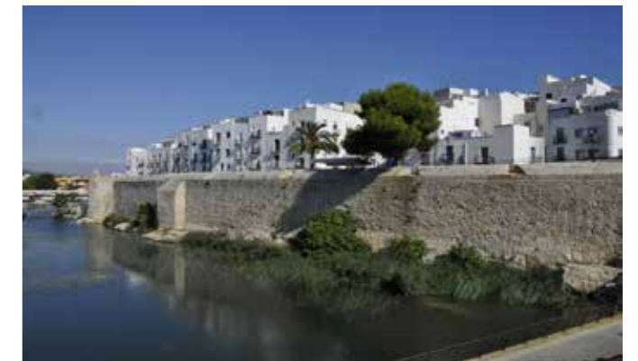
2010. Después de las obras. (MJB 2010).
