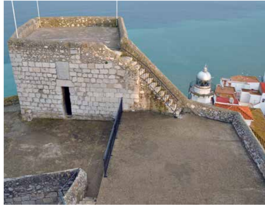
Fig. 4.1.115. Vista del estudio junto a la terraza que se halla sobre la estancia denominada biblioteca y la escalera que sube a la terraza superior (MJB 2013).
