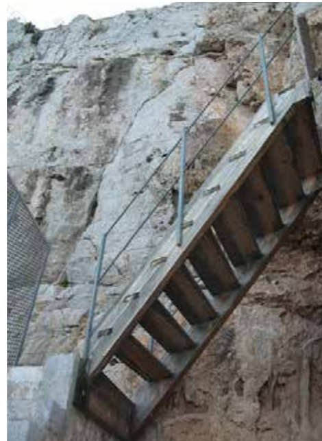
Tramo superior de la escalera después de las obras. (MJB 2008).
