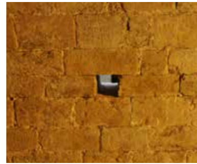
Fig. 4.1.42. Huevo en la parte superior de la bóveda que comunica con la "cámara mayor". (MJB 2015).
