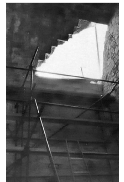
Reparación de la bóveda del salón gótico, desde el interior. (V. Caballero 1970).
