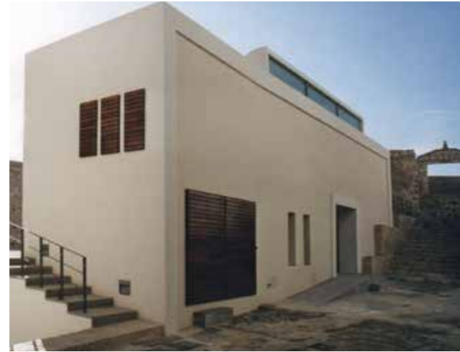
Vista del edificio desde la calle después de las obras. (MJB 1999).
