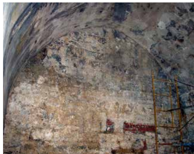
Vista interior del Almacén de Pólvora proceso de las obras. (MJB 2000).
