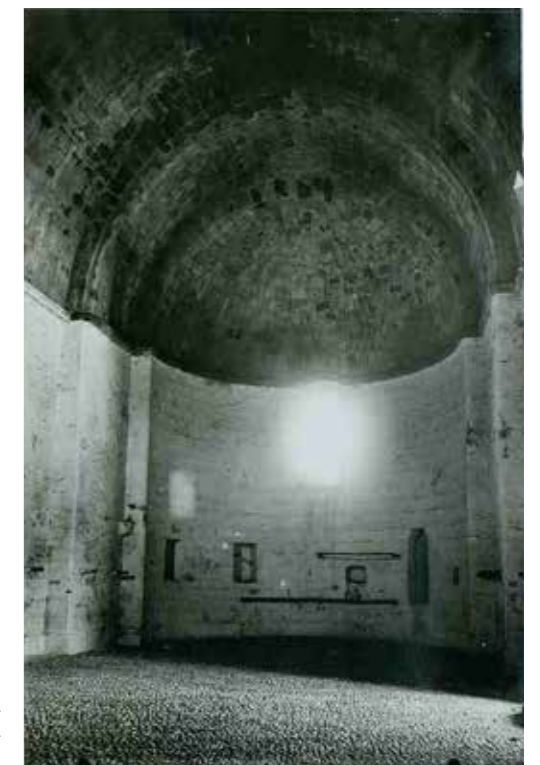
Fig. 4.1.153. Fotografía de la iglesia anterior a 1917. Puede verse el pavimento de enmorrillado. (Publicada en el Catálogo de Tramoyeres).
