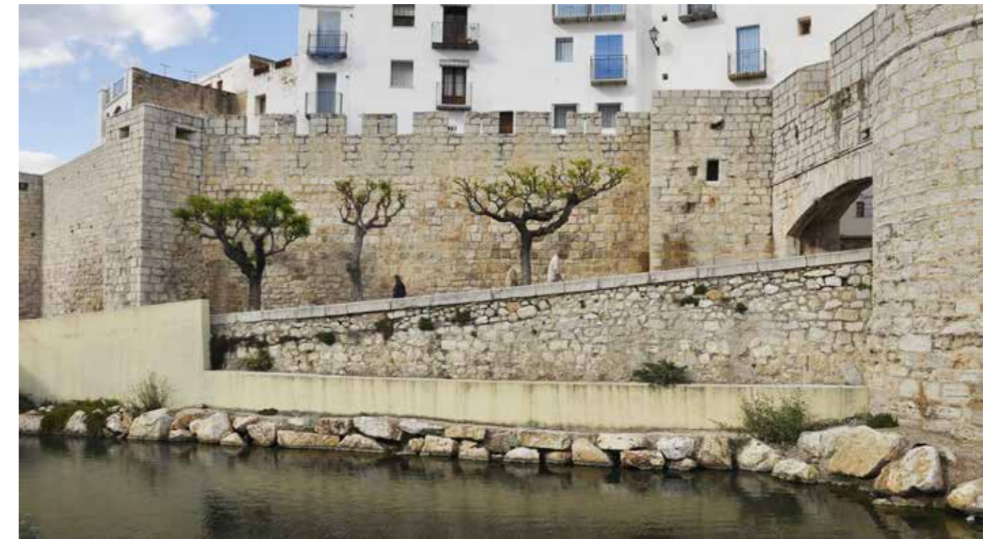
Fig. 4.3.31. Vista de las torres T2 y T3 y el tramo almenado con saeteras. A la derecha la torre del cuerpo de guardia con la ventana para la vigilancia de la entrada. (MJB 2017).
