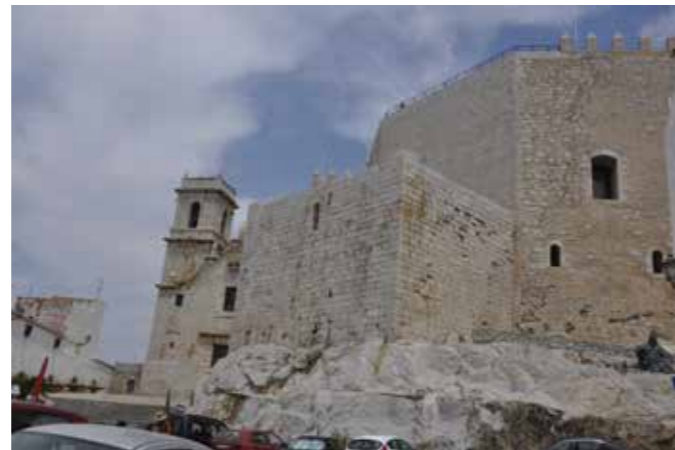
Paramentos exteriores con manchas de humedad. Estado actual (MJB 2010)
