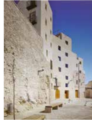
Después de las obras. (MJB1998).
