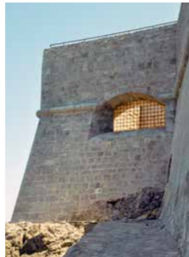
Fig. 4.2.120. Casamata mayor en el ángulo de la tijera, con tronera abierta en el muro. (MJB 2010).
