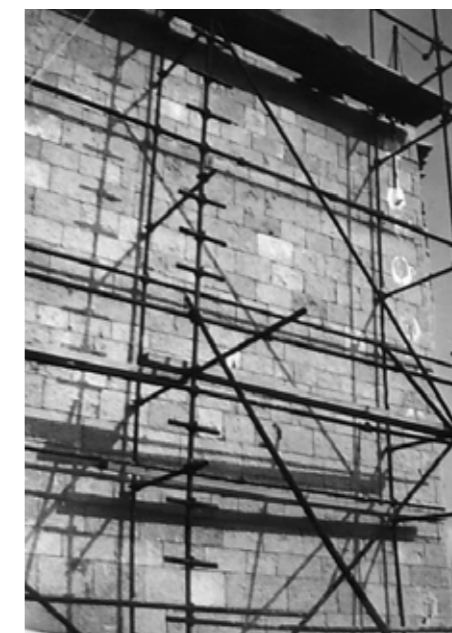
Vista de los andamios en los paramentos exteriores. (V. Caballero 1970).
