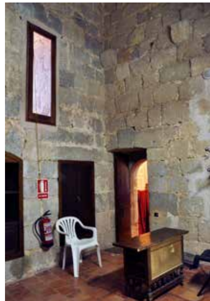
Fig. 4.1.116. Cuarto de las campanas. Puerta de acceso al salón gótico y ventana a la C/ Castillo. Este sería el único acceso a este cuarto antes de que se abriese la comunicación con la biblioteca (MJB 2015).
