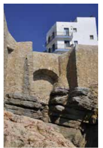
2010. Después de las obras. (MJB 2010).
