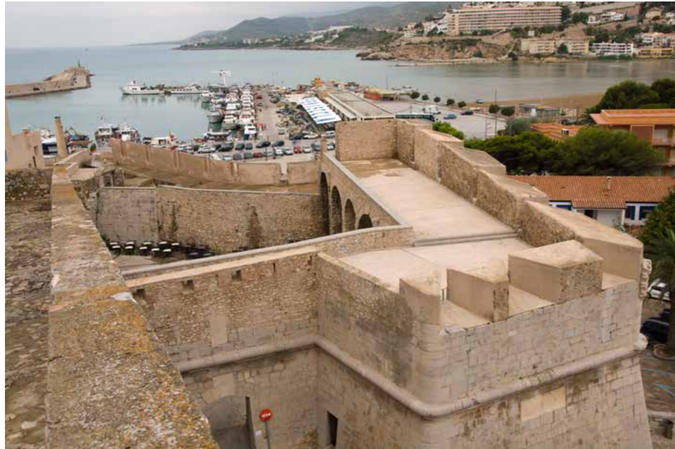
Fig. 4.2.84. Vista actual del baluarte de Santa María. Al fondo la batería de Santa Ana. (MJB 2009).
