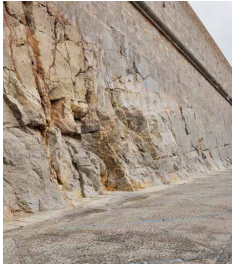
Fig. 4.2.99. Lienzo de muralla sobre la base rocosa tallada en talud. (MJB 2012).
