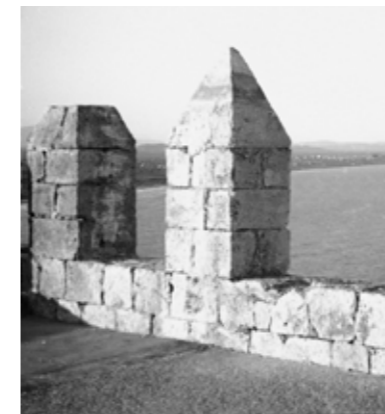
Fig. 4.1.196. Dos de las cinco almenas conservadas en la esquina norte de la azotea. 1930. (ICGC. RF.49731).
