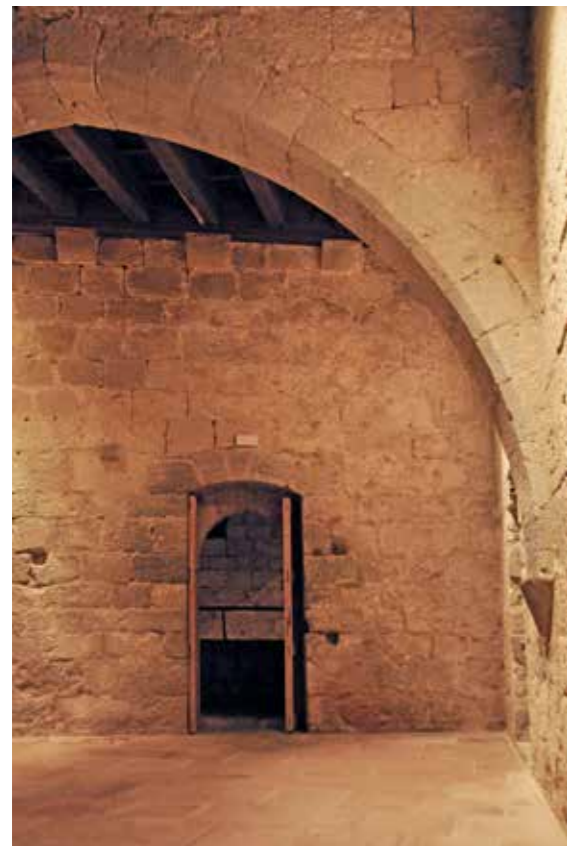
Fig. 4.1.85. Vista hacia la entrada. (MJB 2015).
