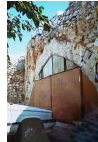
1990. Antes de las obras. Fotos del proyecto. (C. Bento).
