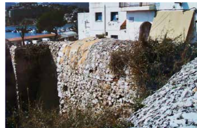
1990. Antes de las obras. Fotos del proyecto. (C. Bento).
