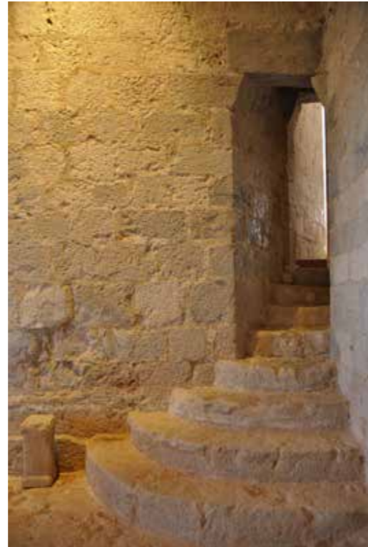
Fig. 4.1.93. Escalera de acceso original a la cámara mayor una vez descubierta. (MJB 2015).
