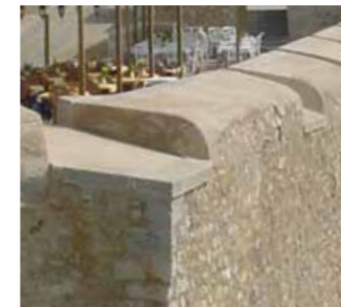
Fig. 4.4.66. Parapeto abocelado de fábrica con troneras y remates de cantería en klos bordes. Batería de la Reina. (MJB 2012).
