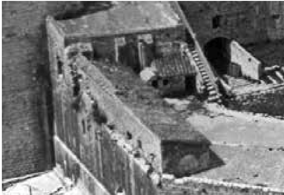
Fig. 4.1.208. Vista aérea del castillo (detalle). Se pueden observar los muros de sillería que continuaban hacia arriba, demolidos a mediados del siglo XX. Foto aprox.1920. (IPCE. NID 4671)
