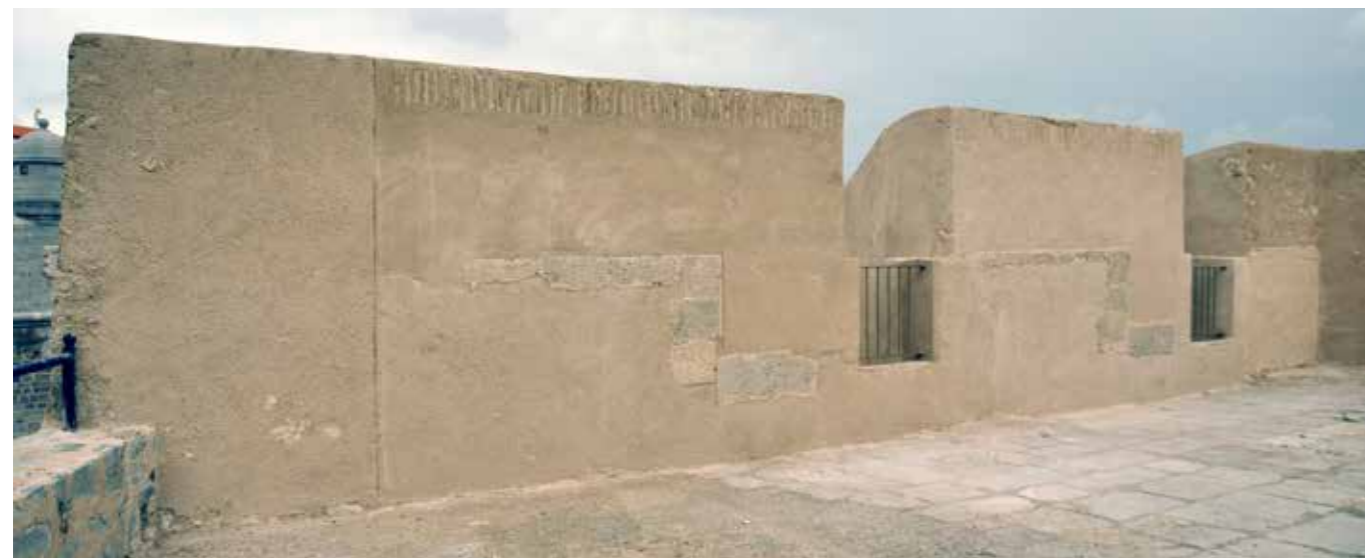
Fig. 4.2.41. Fotografía donde se ven las huellas del parapeto de cantería original del baluarte Real, localizados en las obras recientes y que se ha dejado a la vista. Los merlones de mampostería y ladrillo son de diversas fases. (Balaguer 2013).
