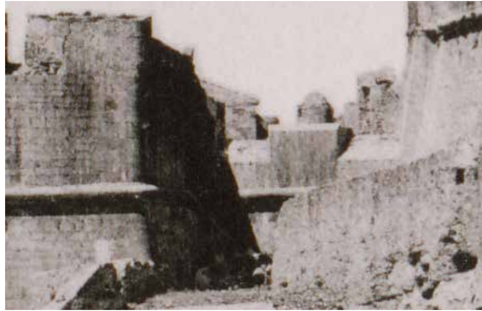
Fig. 4.2.45. Vista de la casamata sur en una fotografía entre 1912 y 1928. (L. Roisin).
