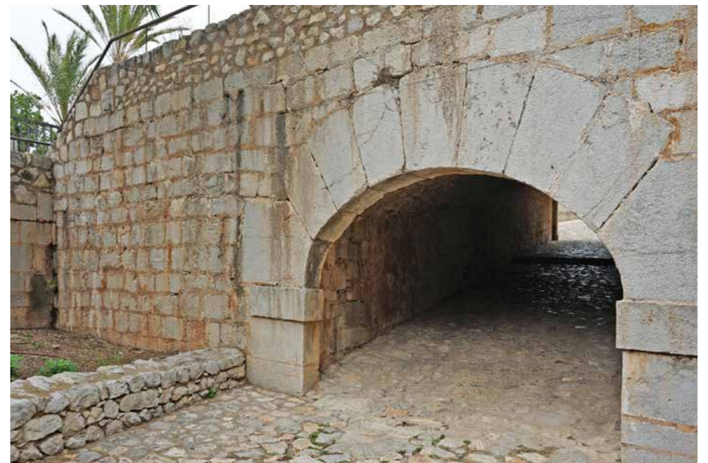
Fig. 4.2.29. Túnel T2 y arco que se abre a la plaza baja o casamata de la batería de Santiago C4. Actualmente la casamata está recrecida y ajardinada. (Balaguer 2016).
