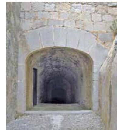
Fig. 4.2.15. Túnel T4 de la salida al exterior de la muralla por la cortina del Olvido. A la izquierda puerta de acceso al interior, al polvorín del siglo XVIII. (MJB 2012).
