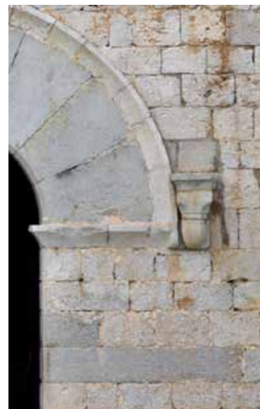
Fig. 4.1.176. Distintas tonalidades de piedra caliza en la puerta de la iglesia. (MJB 2016).
