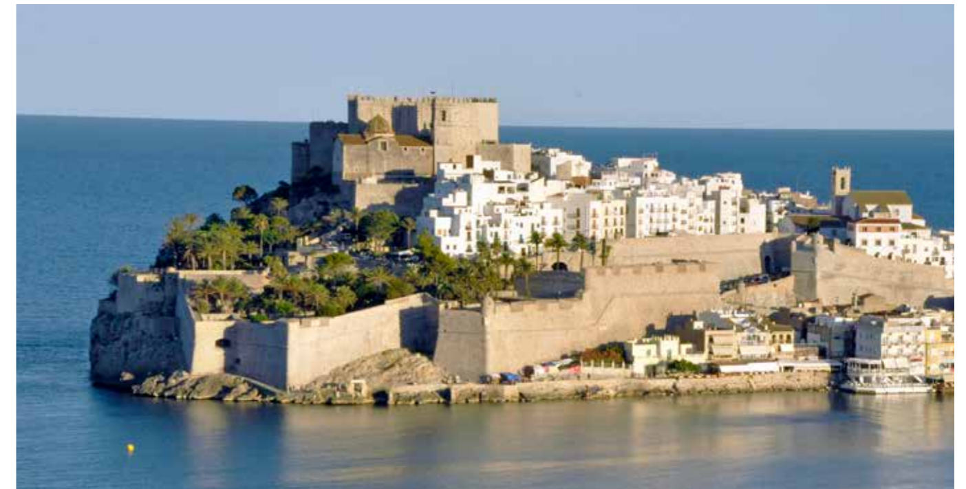
Fig. 4.2.109. Peñíscola, vista general de la muralla proyectada por Gonzaga. (MJB 2013)
