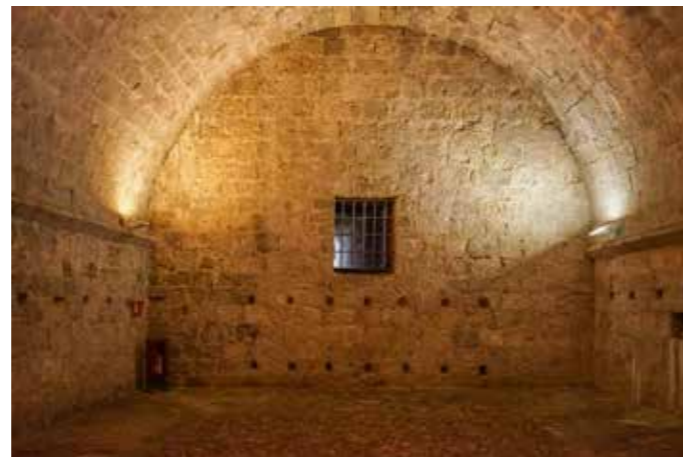
Fig. 4.1.170. Vista hacia el este. Un hueco rectangular atraviesa los muros exteriores que se van ensanchando por la inclinación del paño exterior. El hueco tiene una profundidad media de 5,50m. (MJB 2017).
