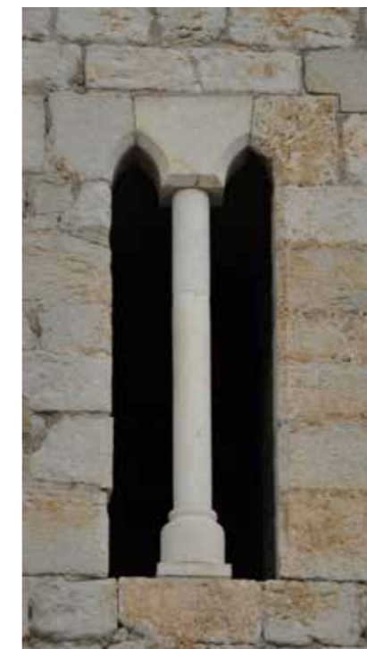
Fig. 4.1.105. Ventana del muro sur con la columnilla parteluz reconstruida en el siglo XX. (MJB 2015).
