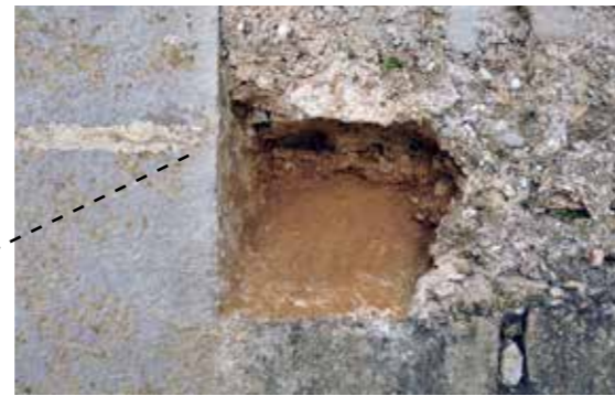
Figura 4.2.31. Cata en la casamata donde descubrimos el parapeto abocelado de la tronera. (Balaguer 2013).
