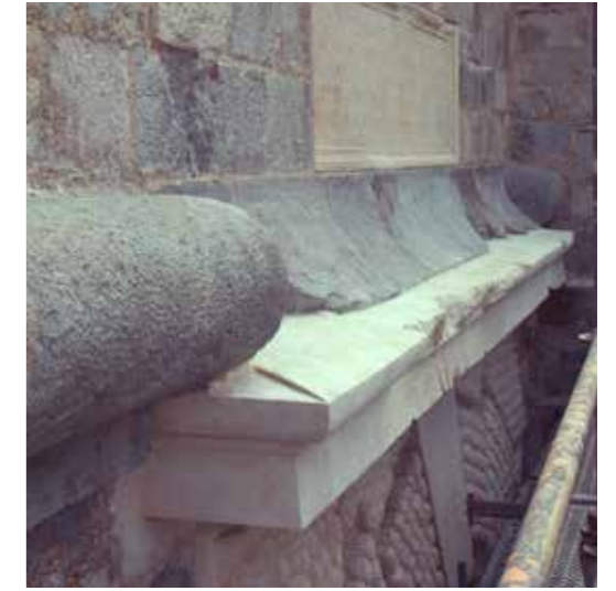
Albardilla remate de la Portada - obra con la realización de armado de varilla /después con reintegración de faltante y marcado de la fecha en zona superiores que se ve desde la plaza de enfrente (MJB 2010/2012)
