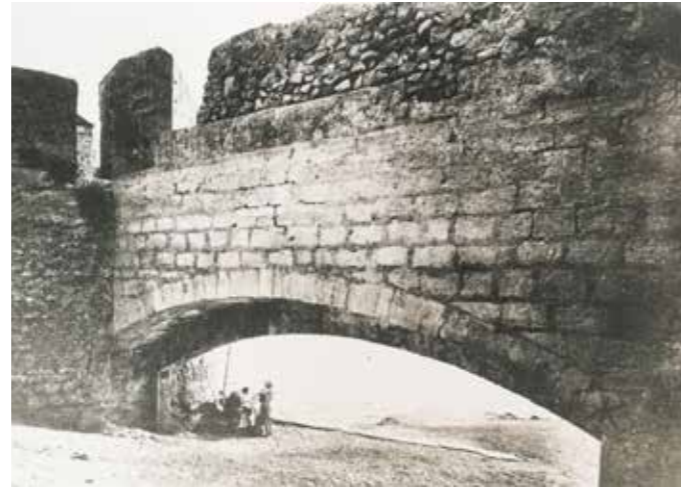
Fig. 4.3.43. Foto del portal en la década de 1930.
