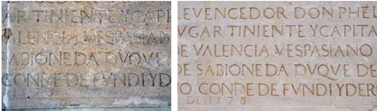
Detalle de la cartela antes (MJB 2009) y después de la restauración (MJB 2013)
