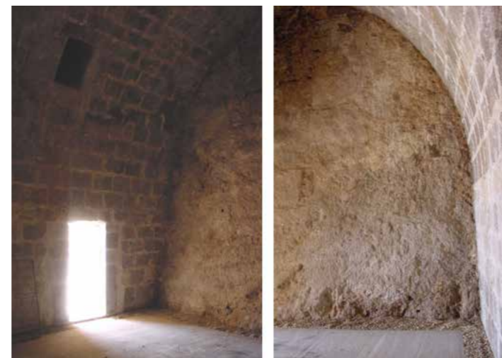
Vista interior del Almacén de Pólvora después de las obras. (MJB 2002).
