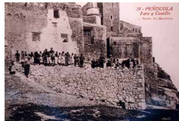
Fig. 4.4.30. Muro de mampostería que cierra el baluarte Nuevo con la calle Farons hacia 1930. (L. Roisin).
