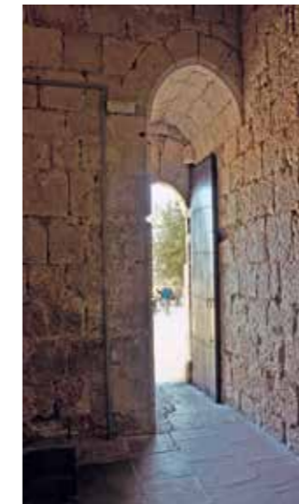
Fig. 4.145. Acceso a la sala anexa. (MJB 2012).
