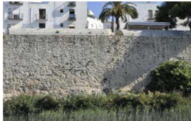
2010. Después de las obras. (MJB 2010).
