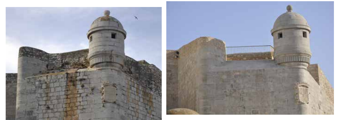
Garita de Felipe II y Balcón de Pilatos. Vistas comparativas antes (MJB 2010) y después de la obra (MJB 2012)
