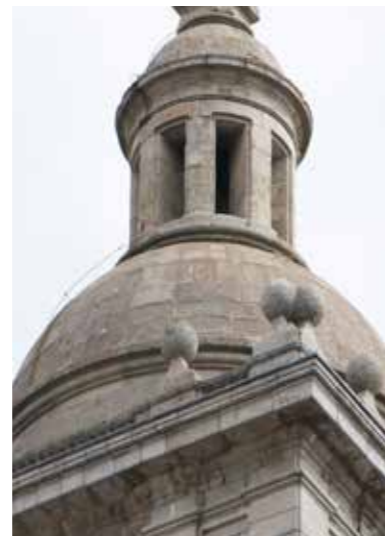
Fig. 4.2.75. Detalle de cúpulas. El Escorial. (MJB 2014).
