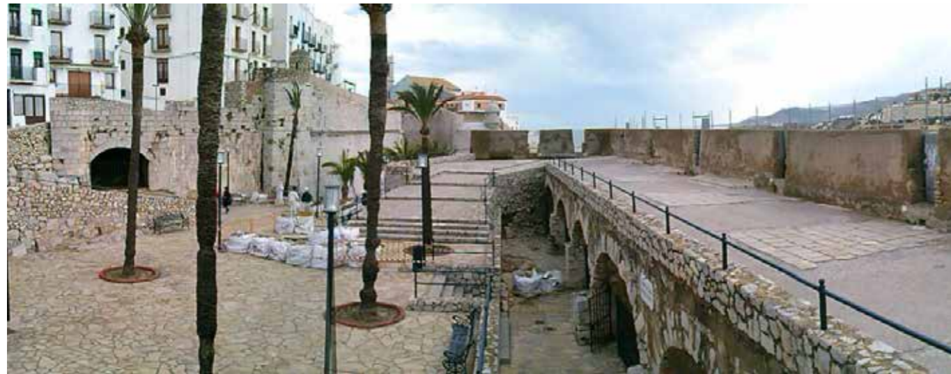
Fig. 4.2.24. Bateria del Calvario. Fase de obras y catas arqueológicas en 2013. A la derecha la estructura de contrafuertes sobre la que se comstruyó la escuela. Al fondo a la izquierda arco de acceso a uno de los túneles que se proyectó para dar acceso a la casamata baja. (2013 MJB).
