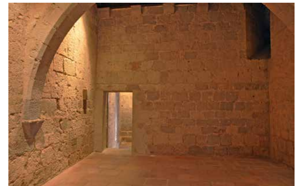
Fig. 4.1.91. Vista hacia la cámara mayor, con el hueco moderno de comunicación y el tragaluz en la esquina. (MJB 2015).
