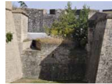
Fig. 4.2.42. Casamata de la ciudadela de Pamplona con merlón central y dos troneras laterales con derrame exterior. (MJB 2012).
