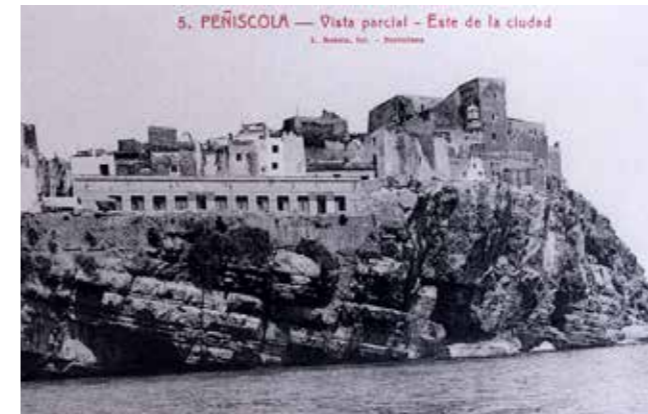
Vista del baluarte del Príncipe y edificio Les Costures. H.1930. (L. Roisin).
