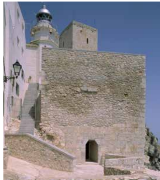
Fig. 4.4.43. Vista del Almacén de Pólvora después de la restauración. (MJB 2002).
