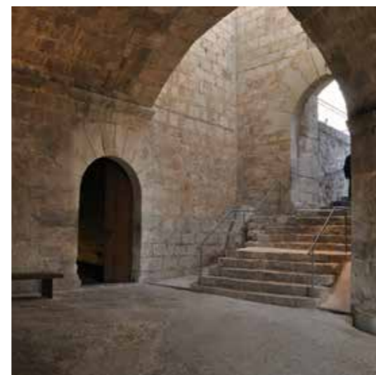
Fig. 4.1.19 Zaguán y escalera dejando a la vista vestigios anteriores. (MJB 2015).
