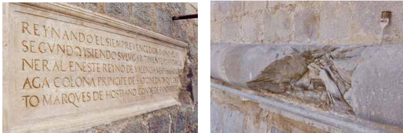
Fig. 4.2.36. Vistas desde el andamio de la cartela del baluarte Real restaurada y un impacto en el cordón antes de ser restaurado. (MJB 2013).
