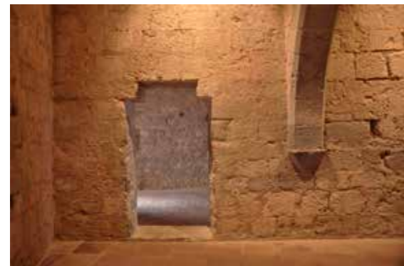
Fig. 4.1.86. Vista frontal del hueco de comunicación con la estancia 1. (MJB 2015).
