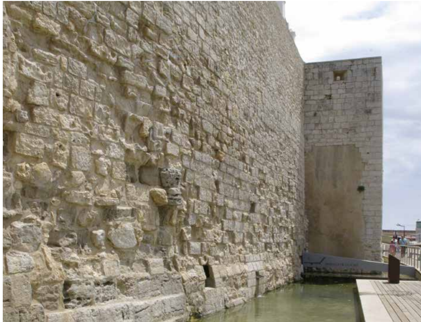
Fig. 4.3.35. Fotografía de lienzo de la muralla de la Fuente más antiguo, que protege el manantial, y torre T1 en la que se localizó un resto de tapial en su núcleo interior. En la base del lienzo hay una balsa artificial que se alimenta con los excedentes del manantial de la Font de Dins, que está al otro lado del muro. El agua sale a través de huecos antiguos que perforan la base el muro, uno de ellos se ve a la izquierda en la foto. Se observa el desgaste de los sillares, ya que antes de la construcción del puerto se encontraban expuestos a la acción de las olas. Se distinguen algunas reparaciones efectuadas al consolidar el muro durante el siglo XX. (MJB 2011).
