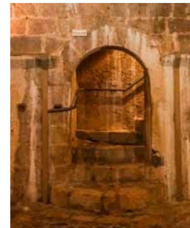
Fig. 4.1.172. Arranque de la escalera, con el primer peldaño curvo y descansillo partido. (MJB 2017).
