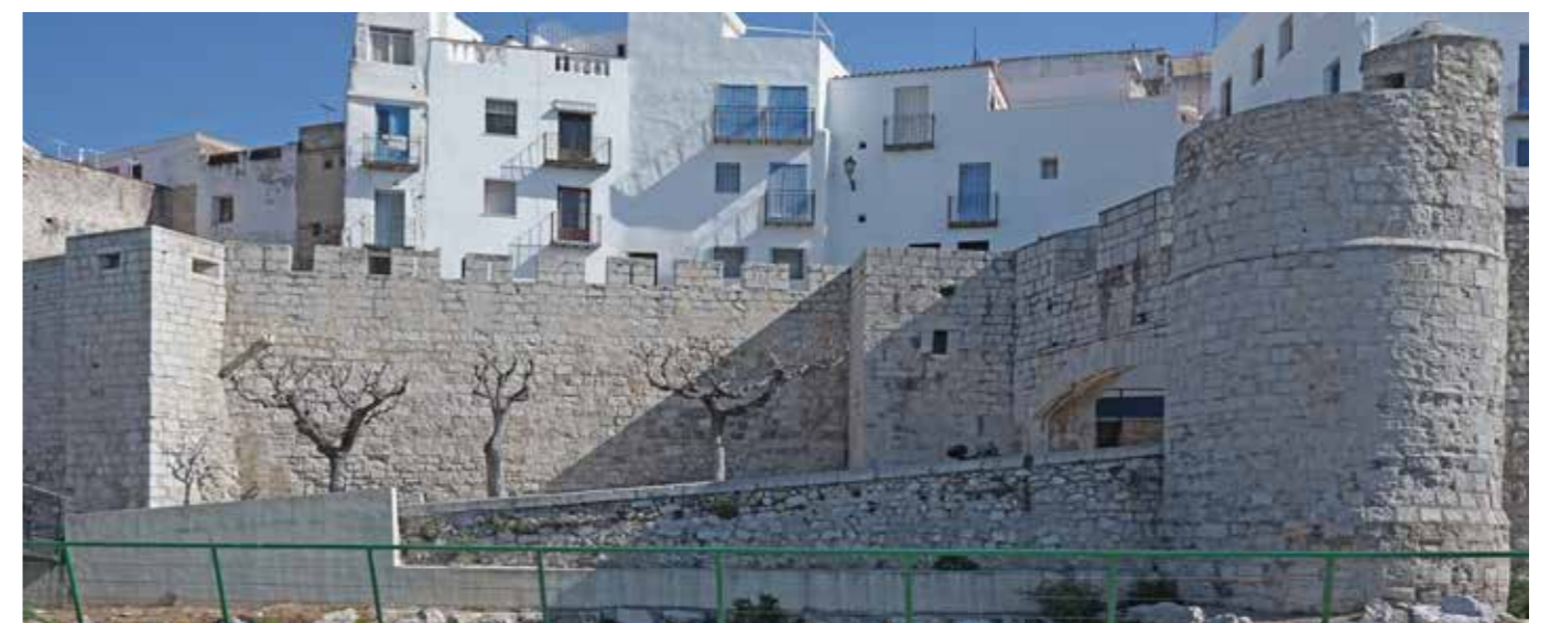
Fig. 4.3.38. Fotografía del tramo de la muralla de la Fuente que enlaza con el portal de Sant Pere. (MJB 2017).
