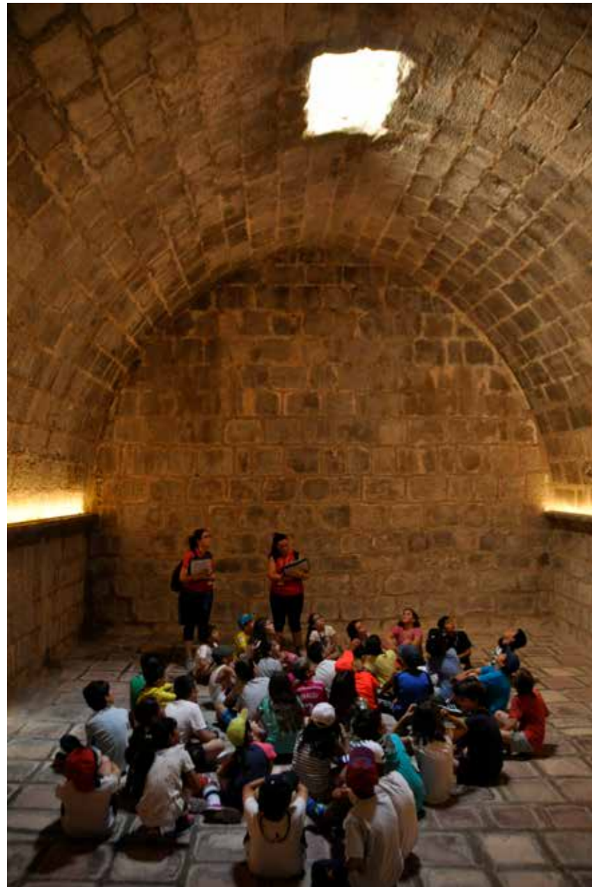
Fig. 4.34. El aljibe con el hueco en la bóveda para su uso como cisterna, se puede observar el corte irregular de las piedras de la bóveda, que demuestra que no se hizo en la obra original. (MJB 2015).
