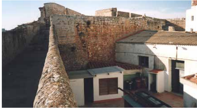
Construcciones sobre muralla y manantial antes de las obras. (MJB 1997).
