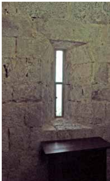
Fig. 4.1.155. Ventana de la sacristía. (MJB 2013).
