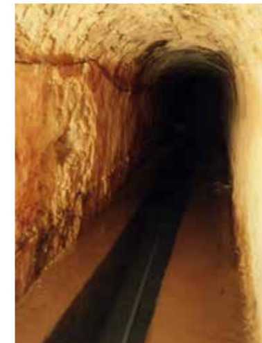
Fig. 4.3.9. Vista del conducto abovedado, que comunica el manantial con la fuente de la Petxina. (MJB 1996).
