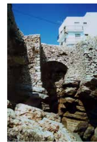
1990. Antes de las obras. Fotos del proyecto. (C. Bento).
