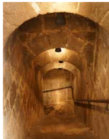
Fig. 4.1.182. Escalera con bóvedas escalonadas de bajada a la bodega mayor. (MJB 2017).
