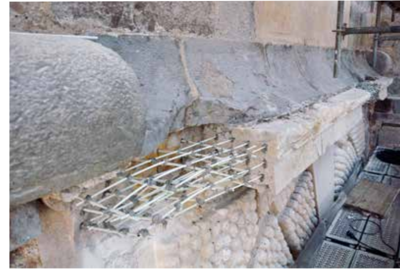
Albardilla remate de la Portada - obra con la realización de armado de varilla /después con reintegración de faltante y marcado de la fecha en zona superiores que se ve desde la plaza de enfrente (MJB 2010/2012)
