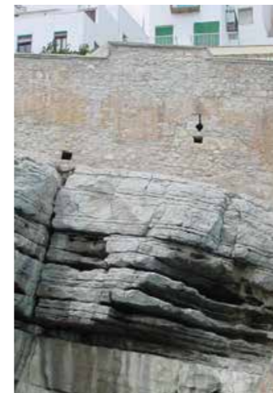
Fig. 4.4.24. Muralla con la tronera de palo y orbe descubierta en el muro sobre el acantilado en la zona del Museo del Mar. (MJB 2001).
