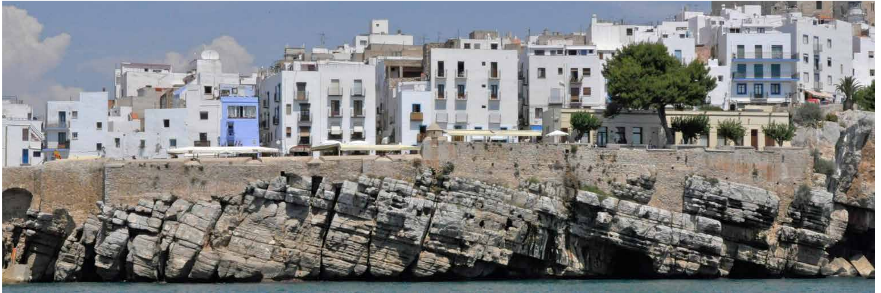
Fig. 4.4.8. Vista general de la batería de la Reina y el baluarte del Príncipe. Detrás de éste, el edificio de Les Costures, antiguo cuartel. A la izquierda merlones reconstruidos con alambor curvo a partir de piezas localizadas en la restauración del año 2000, dirigida por la autora. A la derecha merlones reconstruidos anteriormente en 1993 de forma distinta. Originalmente debían ser también como los de la batería de la Reina. En la parte central la garita sobre uno de los antiguos merlones. (MJB 2010)
