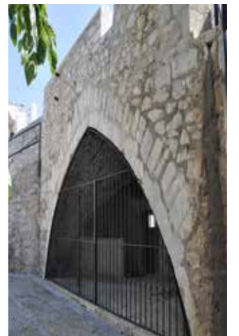
2010. Después de las obras. (MJB 2010).
