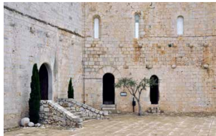
Fig. 4.1.68. Patio de armas. Escalera nueva para acceso al salón gótico. (MJB 2012).
