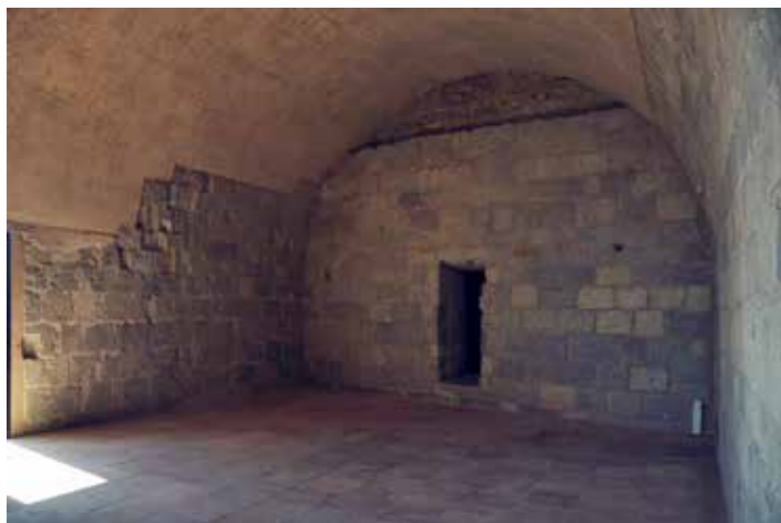
Fig. 4.1.108. Muro lateral izquierdo con arranque de la bóveda de sillería, y única puerta de acceso original a la cámara mayor. A la derecha ventana sobre la puerta principal. Bóveda de ladrillo construida a mediados del siglo XX, recientemente restaurada con revoco de cal. (MJB 2015).
