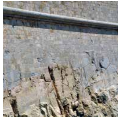
Fig. 5.20. Detalle de paramento de roca de dos variedades de color, labrado en la rampa de Felipe II. (MJB 2012).
