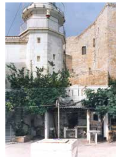
Fig. 4.4.44. Vistas desde la terraza superior del Almacén de Pólvora después y antes de la restauración. (MJB 2002-2000).
