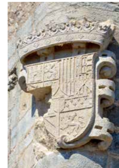
Figura 4.2.37. Vista del escudo de la esquina sur del baluarte Real tras la restauración. Se consolidó el impacto que había producido la fractura del mismo. (MJB 2013).
