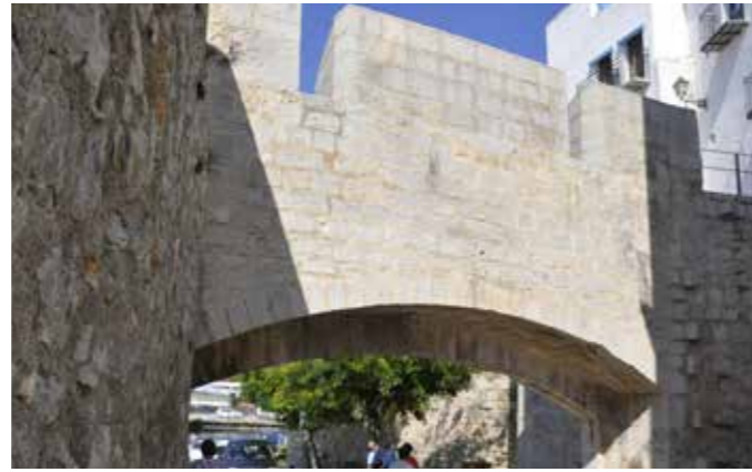
2010. Después de las obras. (MJB 2010).
