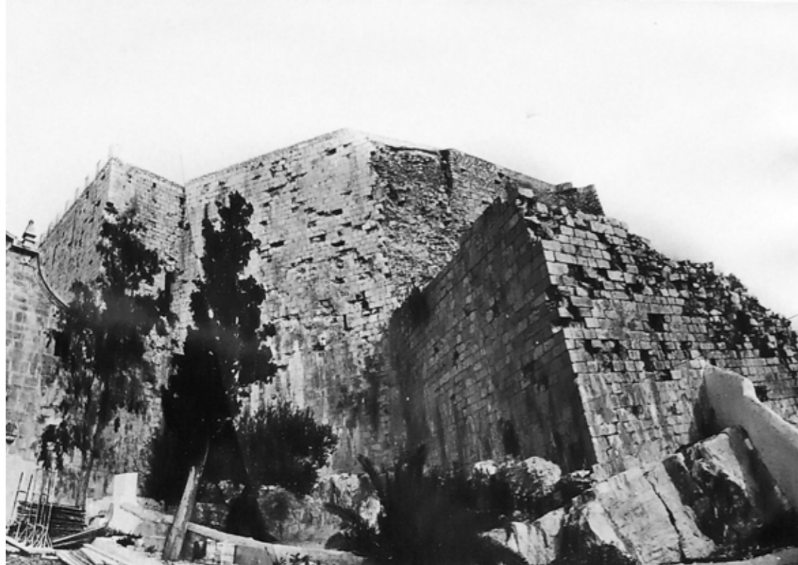
Ámbito de actuación del proyecto. Vista desde la plaza de la Ermitana. Fotos proyecto. (V. Caballero 1970).
