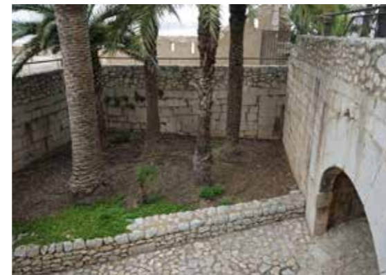
Fig. 4.2.32. La casamata C4 desde el interior. A la derecha, arco del túnel T2. (Balaguer 2013).
