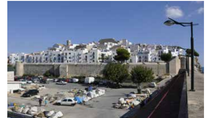
2010. Después de las obras. (MJB 2010).
