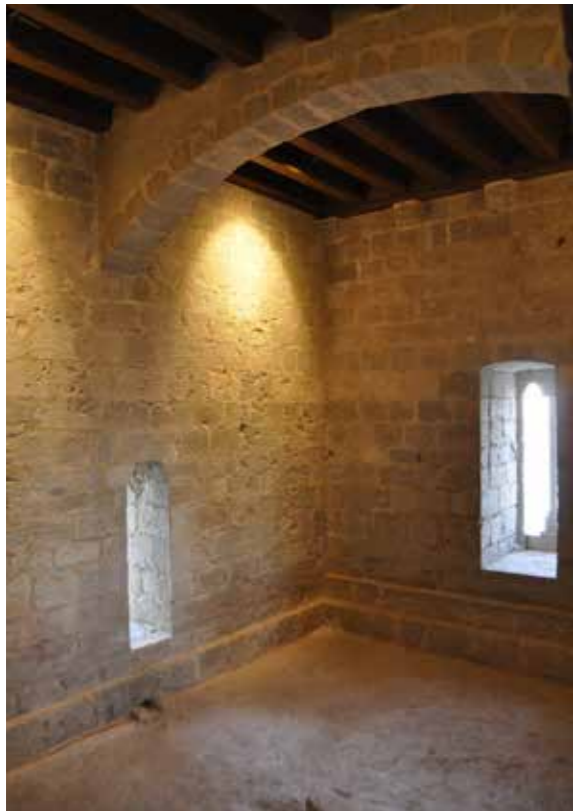
Fig. 4.1.94. Vista desde el acceso original. A la derecha, ventana en el muro este. A la izquierda, hueco de acceso a la letrina y debajo, pieza de desagüe a la que acometen canalizaciones de yeso. El resalte de piedra más bajo sería el nivel del entablado de madera que debió tener la cámara. (MJB 2015).
