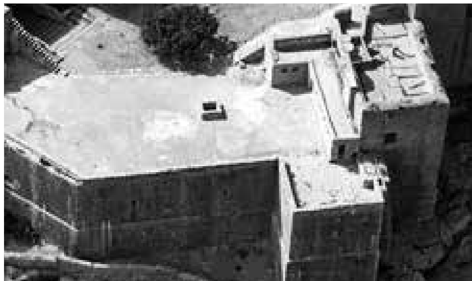
Fig. 4.1.210. Vista aérea del castillo (detalle). Se pueden observar las obras de adaptación para albergue del SEU, el volumen adosado a la cocina mayor y depósitos de agua en la cubierta. Foto aprox.1940. (IPCE. NID. 2174)
