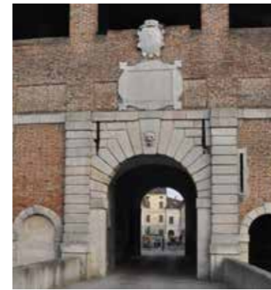
Fig. 4.2.107. Sabbioneta. Puerta de entrada. (MJB 2014).
