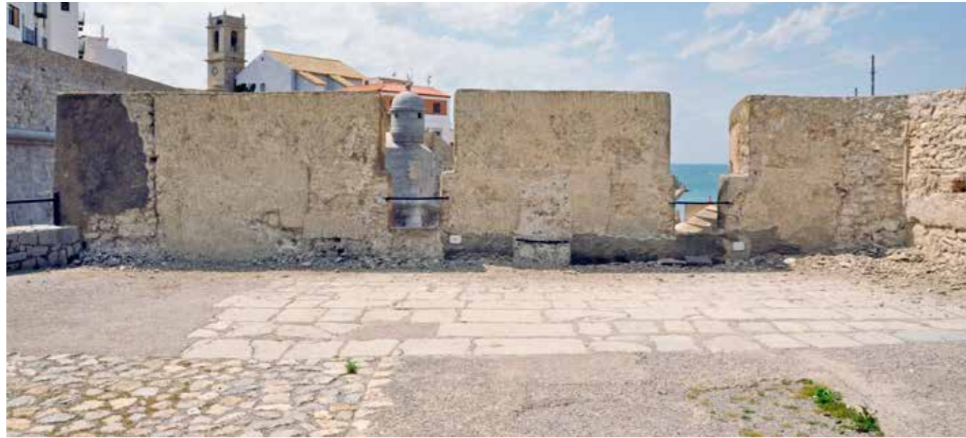
Fig. 4.2.39. Vista de los merlones de la batería del Calvario, al ir eliminando los revestimientos del siglo XX (más oscuros a la izquierda) y descubrir el parapeto de cantería original. (MJB 2013).
