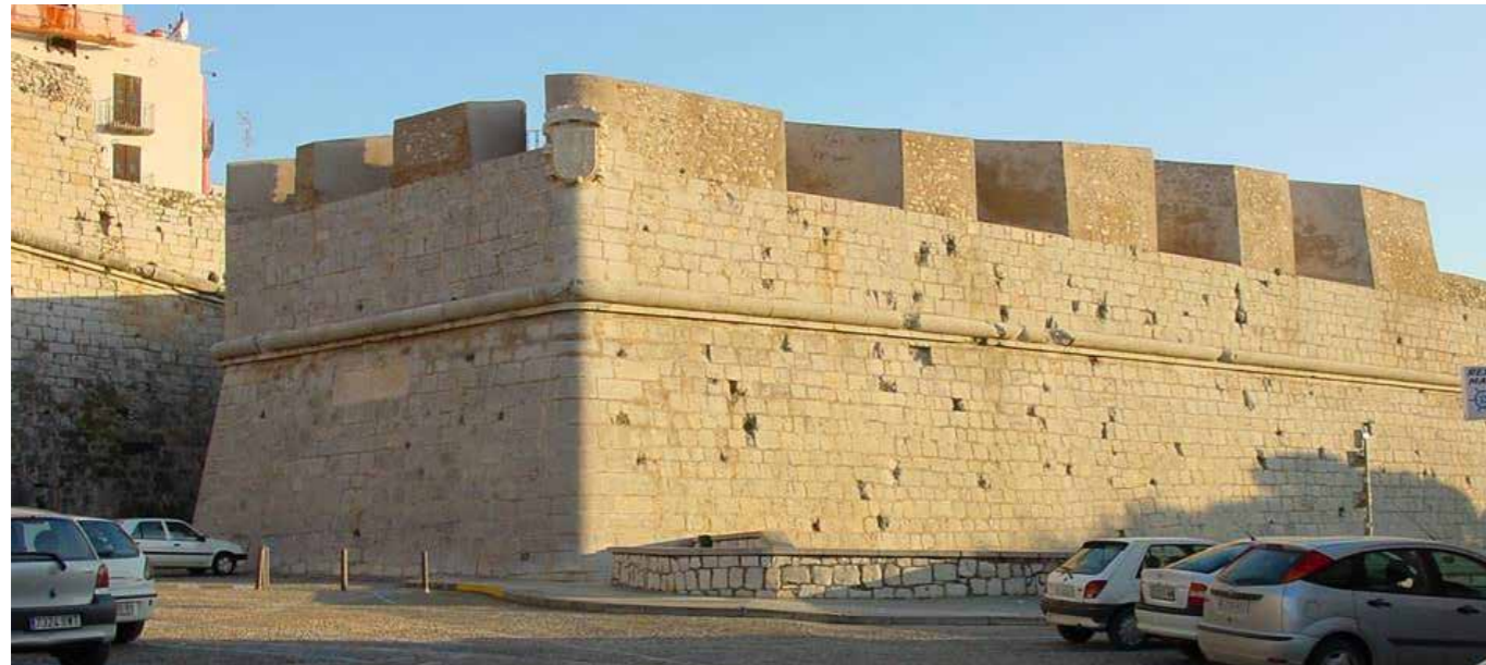
Fig. 4.2.89. Vista actual del baluarte de Santa María. En la esquina el escudo de Felipe II y en el flanco la cartela conmemorativa. Arriba los merlones elevándose hacia el sur. (MJB 1998).
