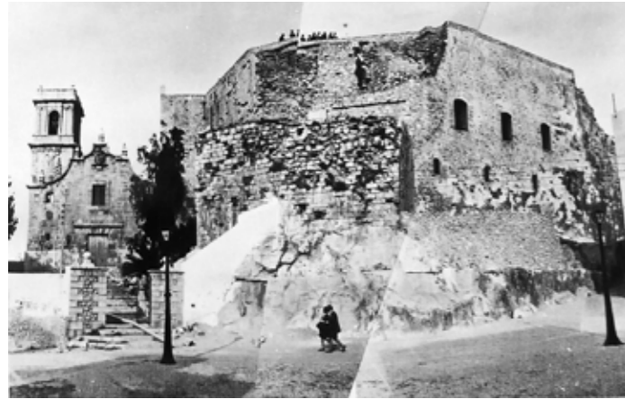
Fig. 4.1.60. Estado de la torre antes de la restauración de Caballero Ungría. 1970. (Foto de proyecto).
