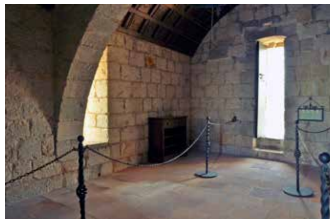
Fig. 4.1.121. Estudio. Vista hacia la entrada y la ventana sur. Se puede ver la bóveda con artesonado de madera, construida en el siglo XX. (MJB 2014).
