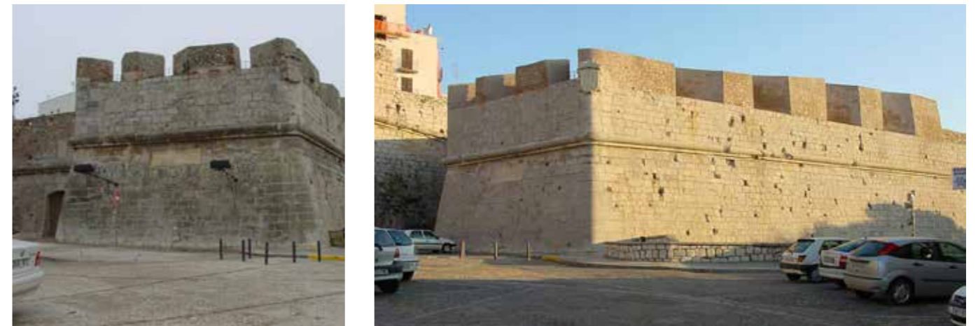
Vista del baluarte de Santa María antes y después de las obras. (MJB 2000) (MJB 2002).
