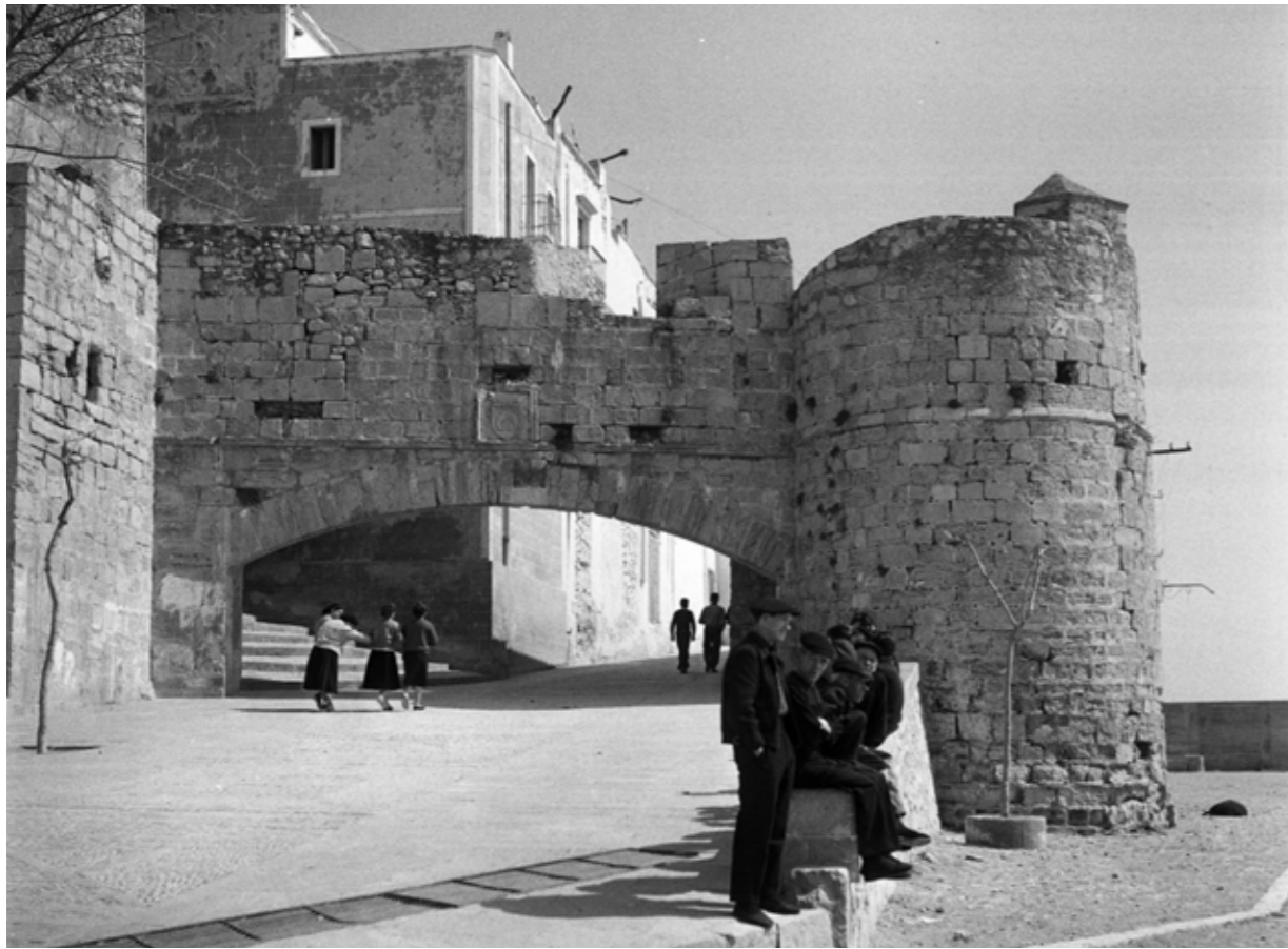
Fig. 4.3.39. Foto del portal de Sant Pere a mediados del siglo XX. cuando se esta realizando la plataforma portuaria.
