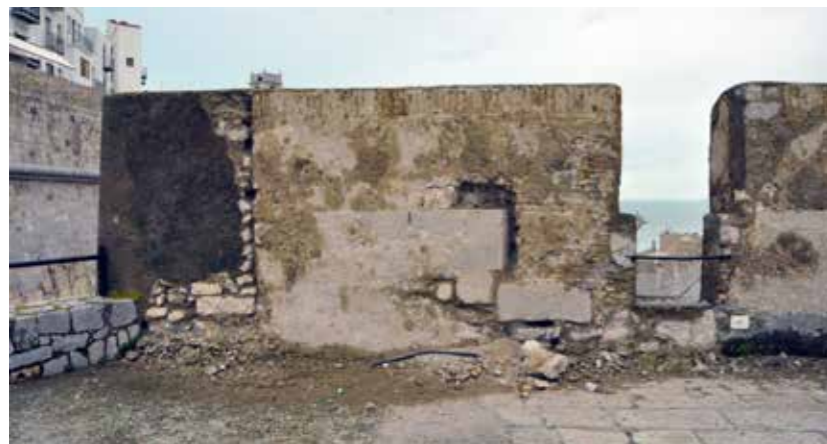
Fig. 4.2.39. Vista de los merlones de la batería del Calvario, al ir eliminando los revestimientos del siglo XX (más oscuros a la izquierda) y descubrir el parapeto de cantería original. (MJB 2013).
