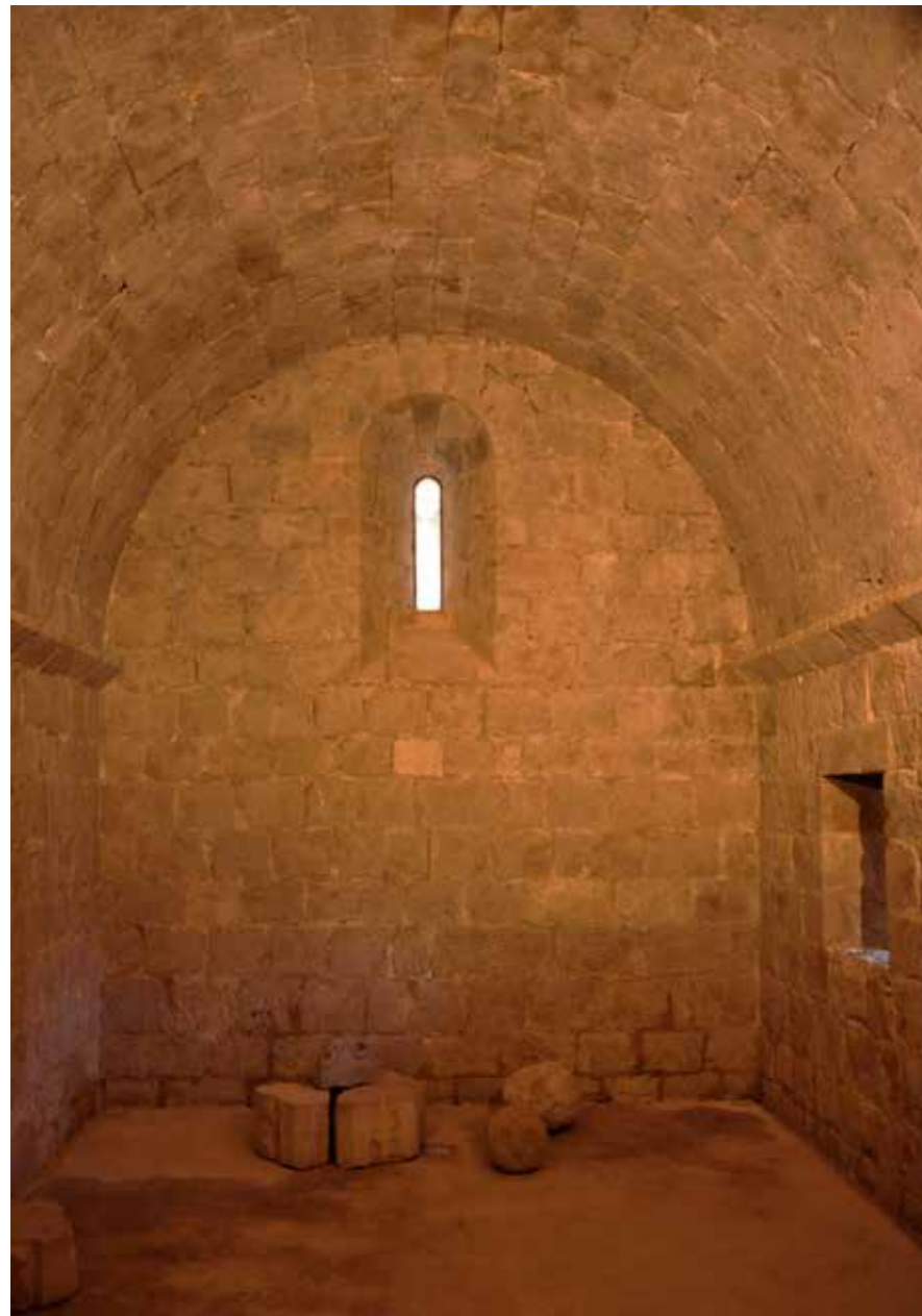
Fig. 4.1.40. Vista general de la sala tras la restauración. (MJB 2015).
