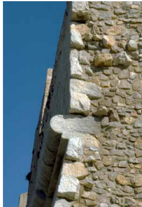
Fig. 4.2.100. Vista del cordón tipo 1, y piezas de sillería exterior en el baluarte de Santa María. (Balaguer 2012).
