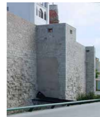
Fig. 3.10. Muralla de la fuente. (MJB 2015).
