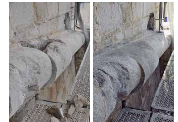
Pieza de cordón Antes /después de la restauración (MJB)
