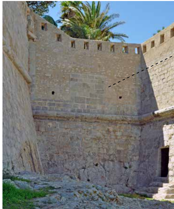
Fig. 4.2.30. Vista de la casamata norte desde el exterior después de la restauración. Se puede ver el parapeto recrecido. Se señala la cata realizada. Abajo, puerta del Socorro. (MJB 2013).
