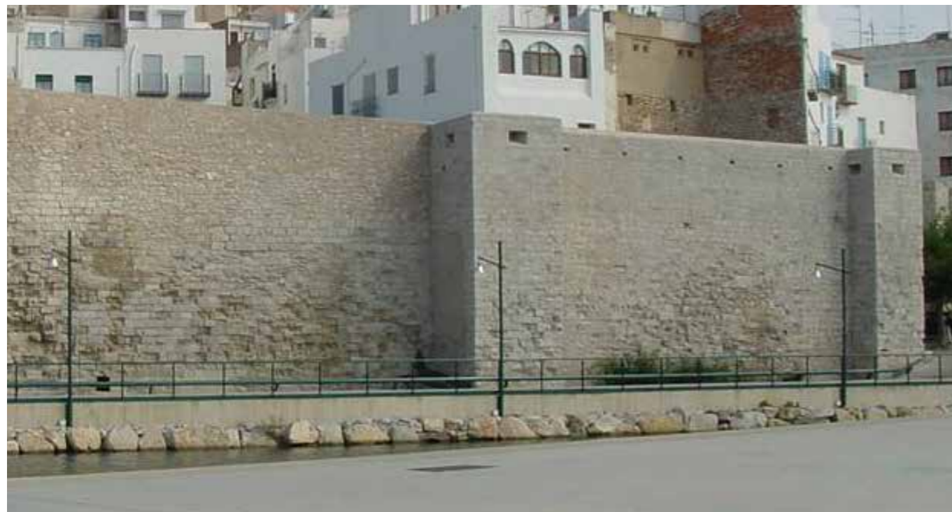
Fig. 4.3.29. Vista de las torres T1 y T2 con el tramo con parapeto macizo sin almenas, donde se pueden ver las aspilleras. En la parte baja de la torre T1 se aprecian los restos de un muro de tapial. (MJB 2000).
