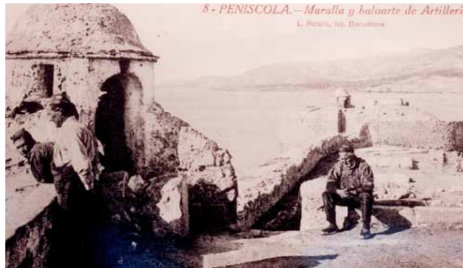
Fig. 4.4.11. Vista de la batería de la Reina desde el baluarte del Príncipe hacia 1930. (L. Roisin).
