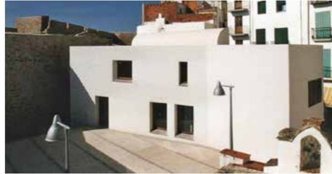
Casa del Agua, muro del manantial y patio después de las obras. (MJB 1999).
