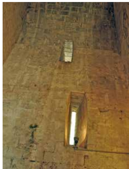
Fig. 4.1.140. Huecos al exterior de la sala anexa. (MJB 2012).
