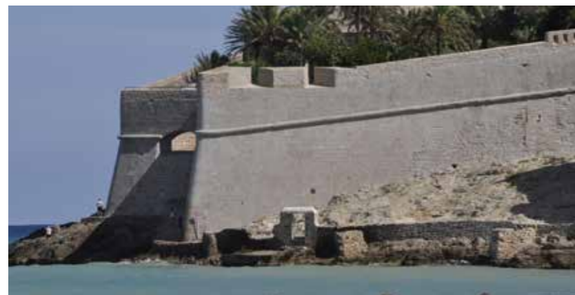
Estado previo a la intervención en la Zona 2 (MJB 2010), y después de las obras (MJB 2012)..
