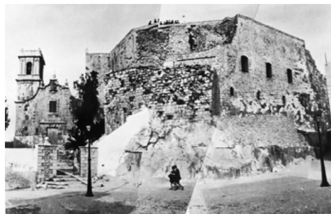
Fig. 4.1.211. Estado de la torre suroeste y esquina del salón gótico antes de la restauración de Caballero Ungría. 1970. Foto de proyecto.
