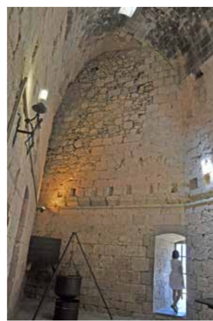
Fig. 4.1.138. Salida a terraza sobre torre suroeste. Se puede ver la reparación del muro y bóveda. (MJB 2012).
