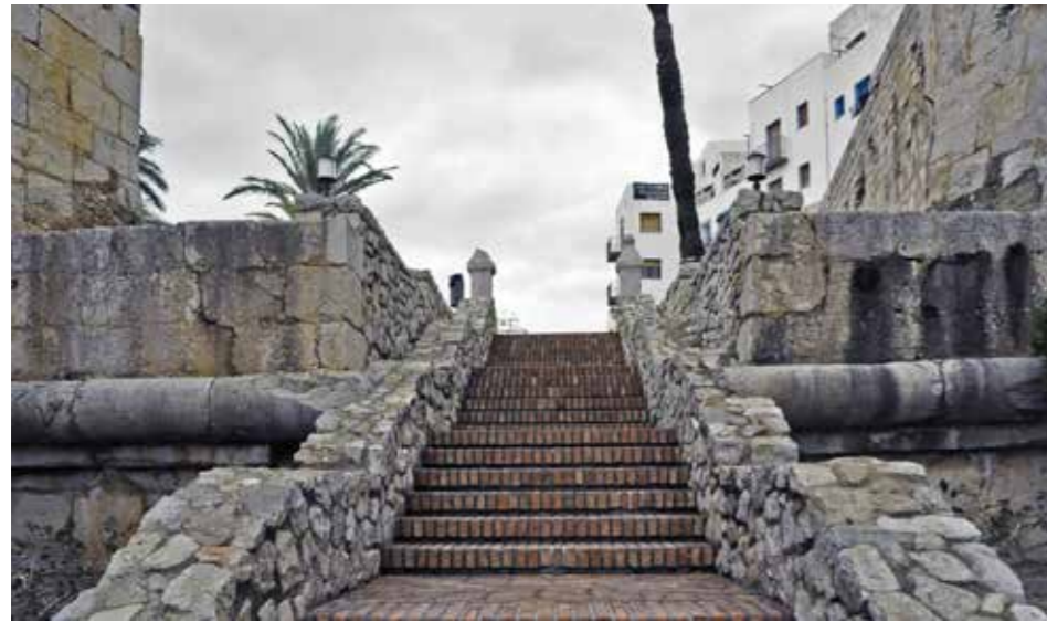
Fig. 4.2.46. Escalera seccionando la casamata. El merlón y las troneras han desaparecido. (Balaguer 2013).
