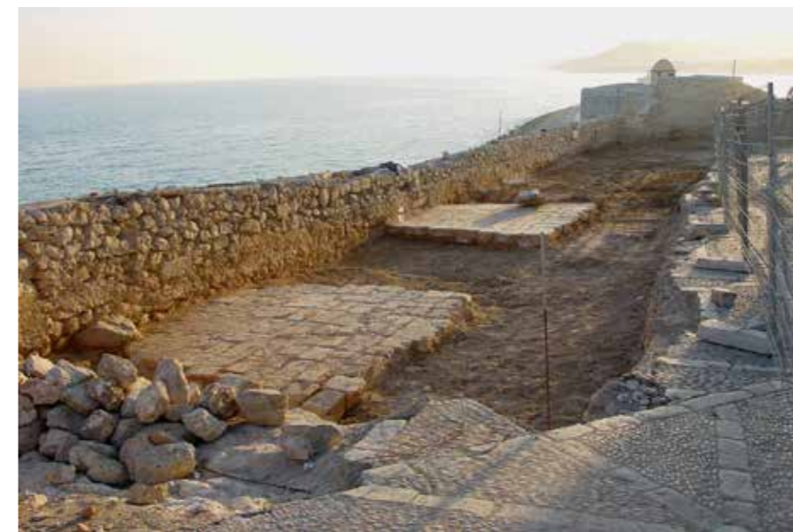
Batería de la Reina en la fase de obras, al levantar el pavimento de la calle y localizar las plataformas de artillería. (MJB 2002).
