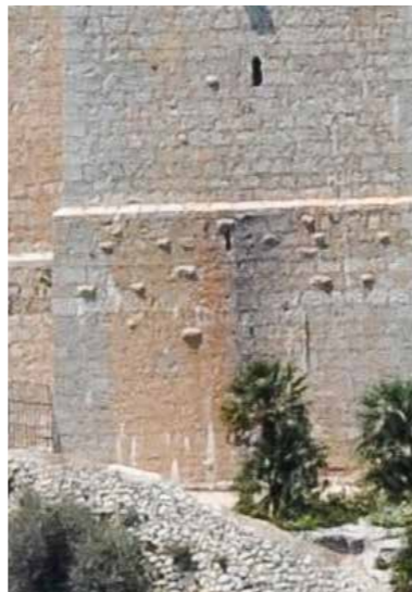
Fig. 4.1.187. Piezas de sillería con almohadillado desgastado, distribuidas aleatoriamente en la fachada al mar. (MJB 2012).
