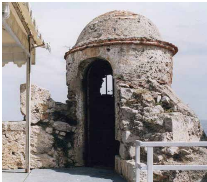
Garita del baluarte del Príncipe antes de las obras. (MJB 2002)
