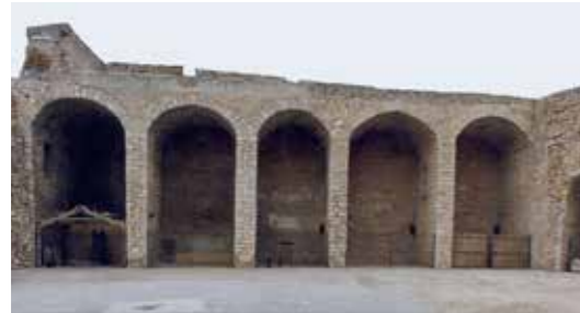
Antes de las obras. (MJB 1996).
