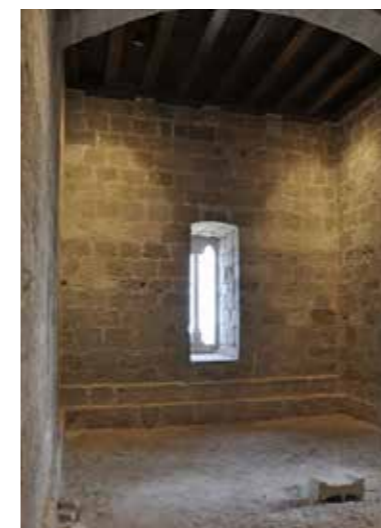
Fig. 5.7. La cámara mayor. (MJB 2015).
