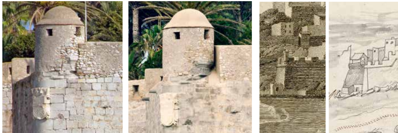
Fig. 4.2.35. Vistas comparativas de la garita del extremo norte antes (2012) y después (MJB 2013) de la restauración, en la que se descubre la base de la garita original. A la derecha un detalles de los planos de Suchet, 1812 y Tena 1813 en los que se puede ver la garita.
