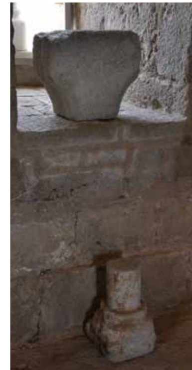
Fig. 4.1.103. Piezas originales del parteluz colocadas junto a la ventana del muro sur. (MJB 2015).
