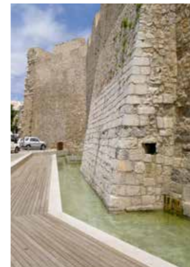
Fig. 4.3.23. Vista de los muros exteriores de la batería de Santa Ana. En primer plano el contrafuerte con base de sillaría que protege la zona del manantial de la Font de Dins. (MJB 2011).
