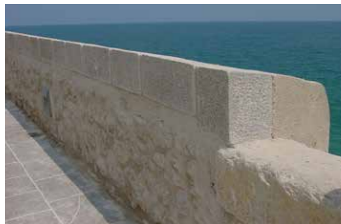
4.4.17. Detalle de parapeto reconstruido integrando la pieza de albardilla original y a la derecha, vista del conjunto tras la intervención. (MJB 2002).
