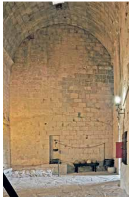
Fig. 4.1.137. Brocal de la cisterna y huellas de la bóveda en el muro. (MJB 2012).
