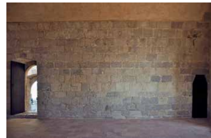
Fig. 4.1.112. Vista del muro con la puerta principal y la de comunicación con la cámara mayor. (MJB 2015).
