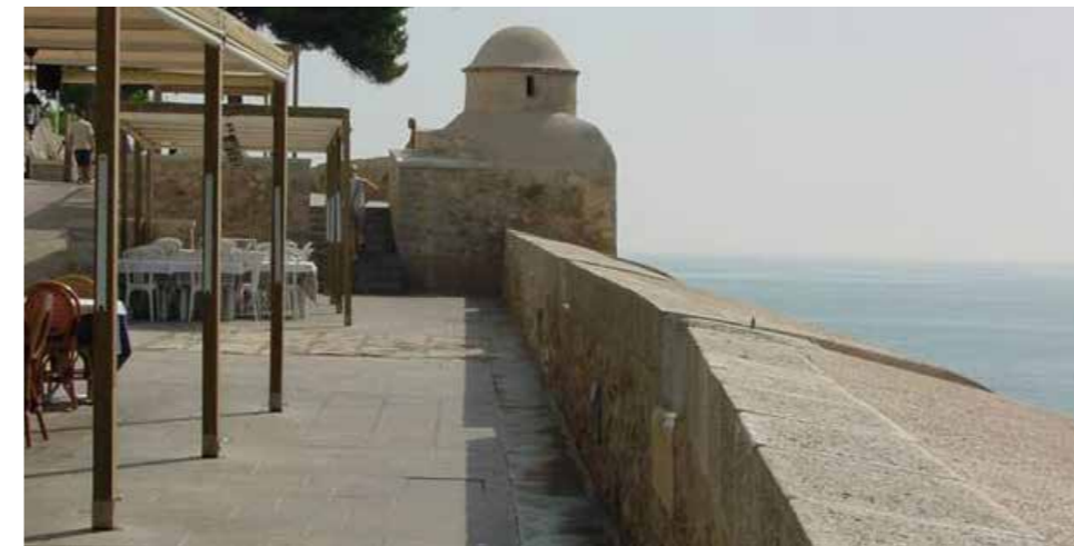
Vista de la batería de la Reina después de las obras, dejando una zona de paso junto al antepecho de la muralla. (MJB 2002).
