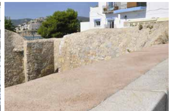
2010. Después de las obras. (MJB 2010).
