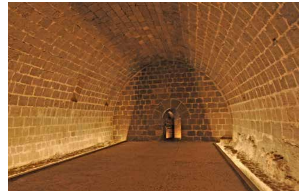
Fig. 5.8. Las caballerizas. A ambos lados se ha dejado en la restauración una ranura con el nivel original a la vista que permite ver la roca tallada (MJB 2015).
