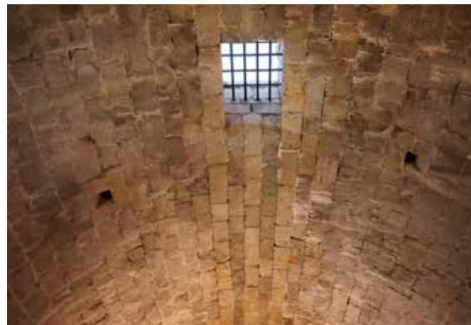
Fig. 4.1.169. Vista del hueco de la bóveda. Como el del aljibe, fue abierto posteriormente, ya que las piedras están cortadas según se puede ver en la foto. También se observan dos respiraderos laterales, cegados por el exterior. (MJB 2017).
