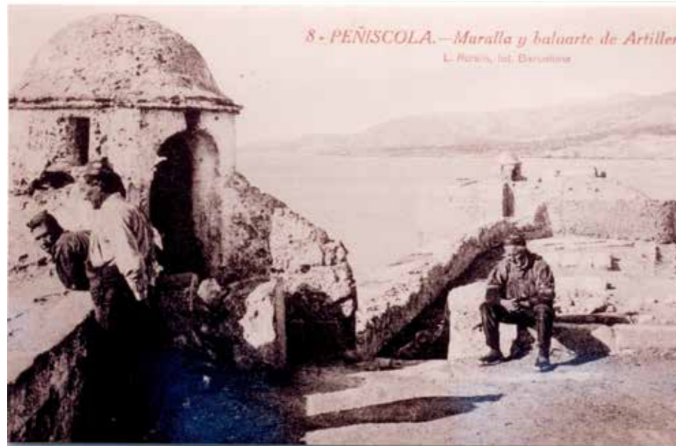
Fig. 1.18. Foto de la Batería de la Reina. L. Roisin. Aprox. 1930. Importante para detectar los cambios de la batería inferior que se rellenó para hacer la calle en rampa a mediados de siglo XX. Partiendo de esta imagen y del plano de 1730 establecimos las hipótesis de como fue la batería y en función de ello planificamos la obra de reurbanización, en la que levantamos los rellenos y localizamos las plataformas artilleras que se ven en esta foto, así como algunos restos del parapeto que se habían recrecido con muros y que pudimos recuperar.
