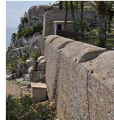
Fig. 4.4.59. Tramo de muralla entre las baterías baja y alta del Maset, con los dos niveles y los remates con sección curva y troneras. (MJB 2012).
