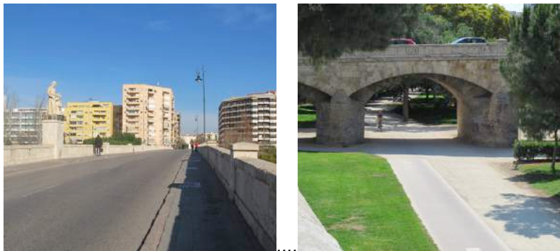
Vista superior e inferior del puente.
