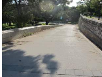
Vista inferior rampa
