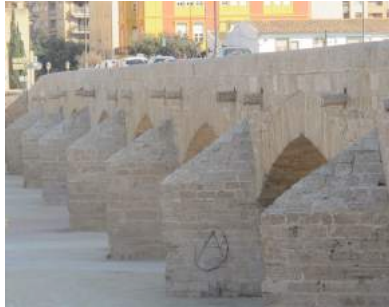
Vista del puente aguas arriba.
