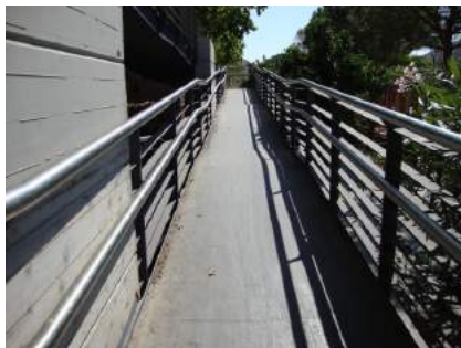
Vista tramo 2 de bajada
