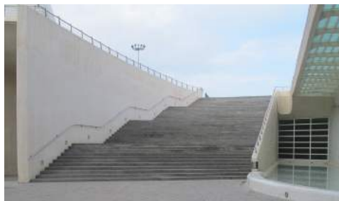
Tramos de la escalera A
