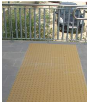
Pavimento señalizador al inicio de la rampa
