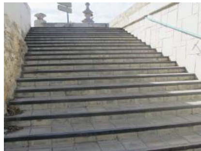
Vista mamperlán metálico
