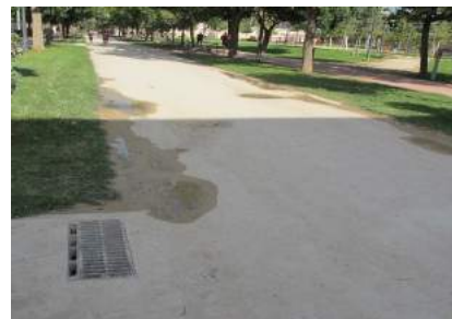
Encharcamiento de agua de riego.
