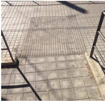
Pavimento táctil señalizador en el embarque y desembarque
