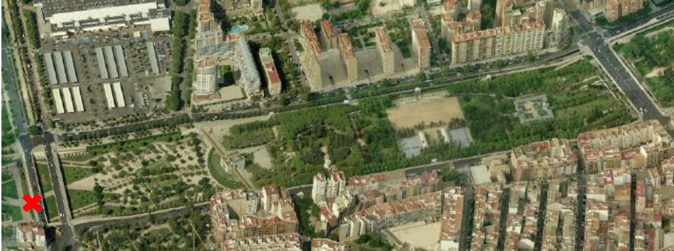
Tramo 1-2 acotado por los puentes de 9 de Octubre y de Campanar Captura Bing Maps
