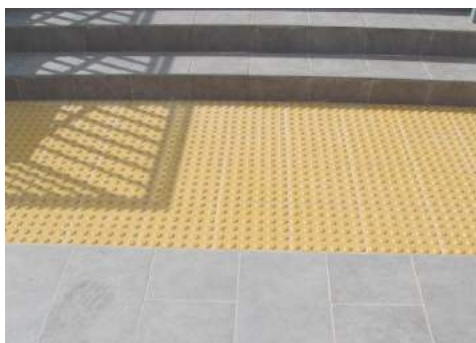
Pavimento señalizador
