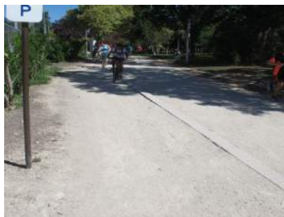
Baldosín delimitador carril bici en tramo 8
