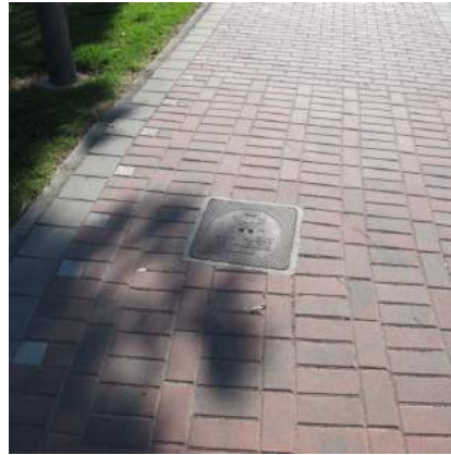
Presencia de registro de instalaciones
