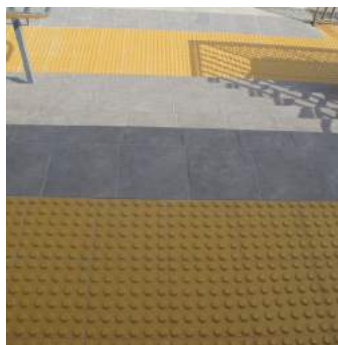
Pavimento señalizador en el embarque y desembarque
