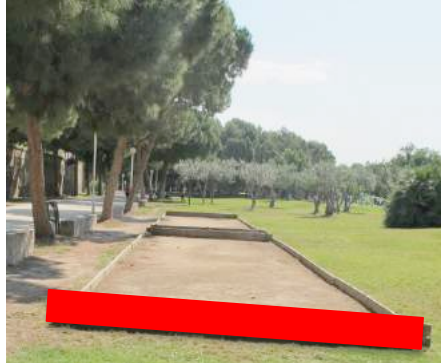
Eliminación de tablonces de madera para acceder a cota 0,00 metros
