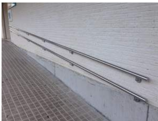
Pasamanos a doble altura de sección circular
