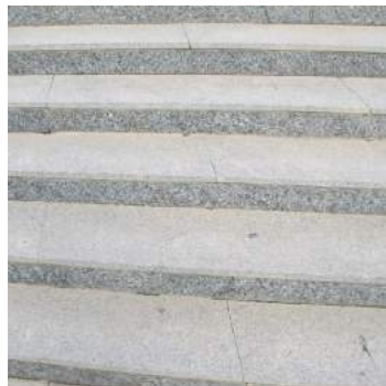
Revestimiento de granito del escalón
