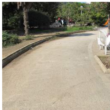
Pavimento de hormigón rayado en la zona central
