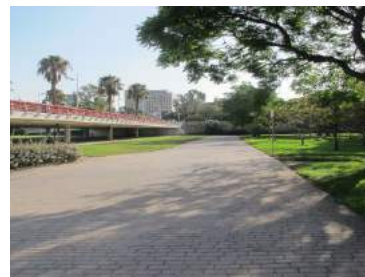
2 Pavimento de hormigón impreso
