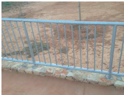
Apertura máxima entre elementos verticales de 10 cm
