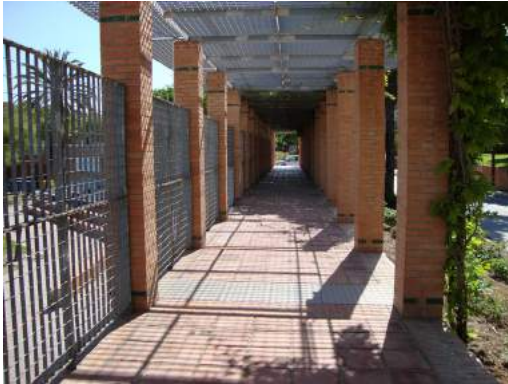
Pasillo acceso a gradas
