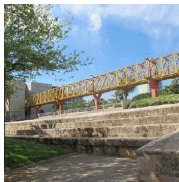
Vistas de la pasarela
