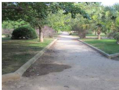
Banda peatonal encintada con bordillo
