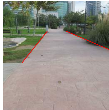
Colocación de bordillo perimetral
