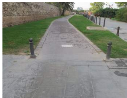
Carril bici con señalización horizontal
