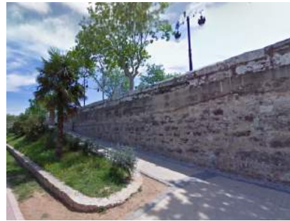
19 Vista de rampa desde cota inferior
