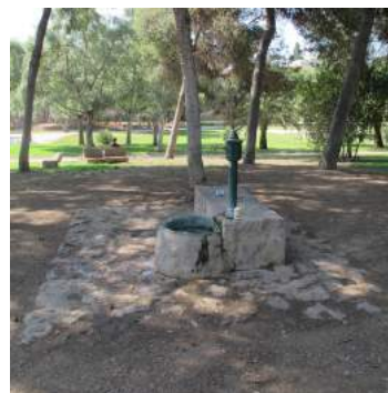
Fuente de agua potable
