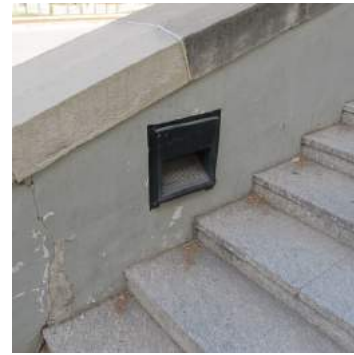
Instalación de alumbrado
