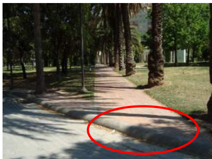
Vista general IT09 inicio
