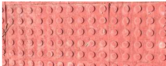
pavimento diferenciado en textura y color
