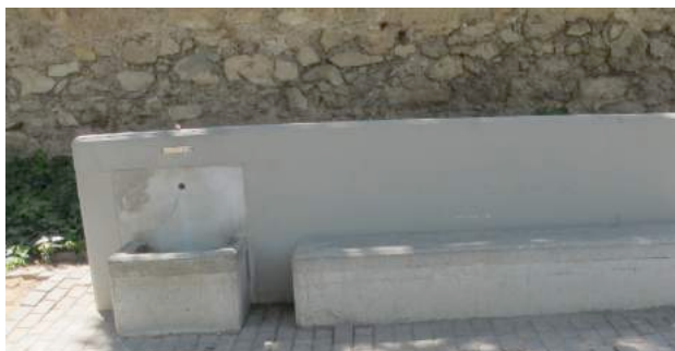
Fuente tipo 4 de hormigón visto
