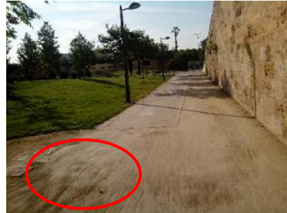
Erosión del terreno por el paso de los ciclos
