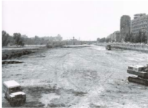
Trabajos en el cauce del Río Turia 43
