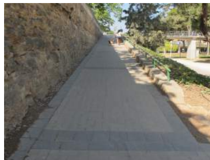
9 Vista de rampa desde cota inferior
