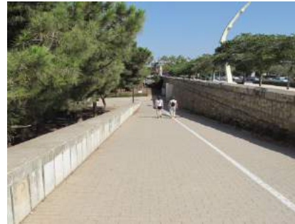
Vista rampa desde nivel superior
