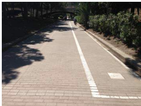
Plataforma mixta con señalización horizontal
