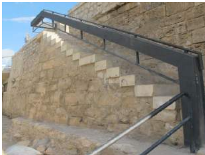
Tramo escalera superior.
