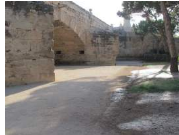
4 Arena morterenga compactada
