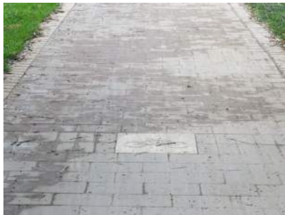
Baldosín y señalización de carril bici en tramo 7
