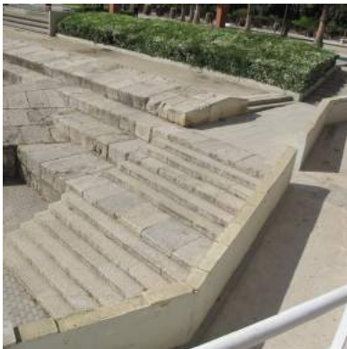
vista de toda la escalera
