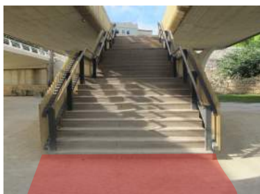
Falta de pavimento táctil en el embarque
