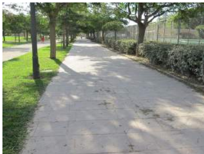
Vista itinerario peatonal zona campos de futbol II
