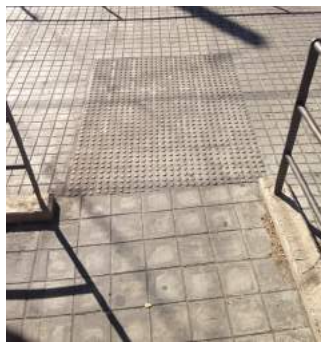
Embarque y desembarque de rampa con franja de pavimento táctil señalizador
