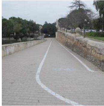
Rampa próxima al puente del Mar
