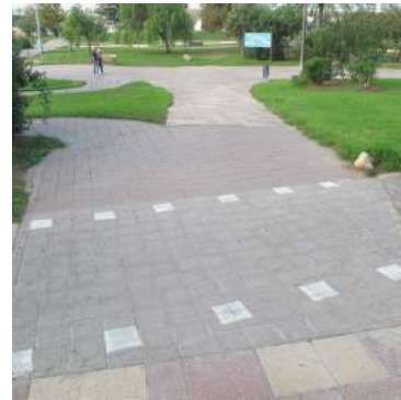
Vista superior de la rampa.
