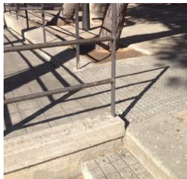
Embarque y desembarque de rampa con franja de pavimento táctil señalizador
