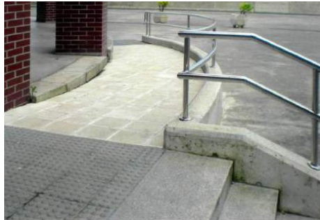
Franja de pavimento señalizador al desembarque de la escalera 32
