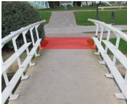
Diferenciación de pavimento al inicio y fin de la pasarela
