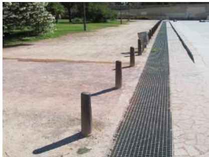
Bolardos de protección de rejilla dentro del carril
