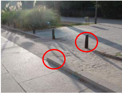
Vista de obstáculos y elementos que pueden provocar caídas y tropiezos
