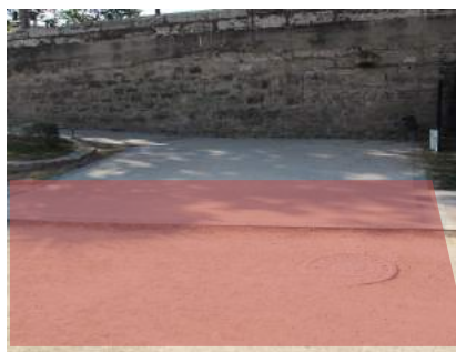
47 Falta pavimento señalizador o advertencia
