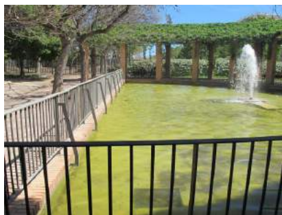
Estanque estructura caravista
