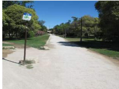
Pavimento de arena morterenga
