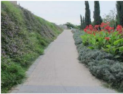
Carece de barandilla en ambos lados tramo 2
