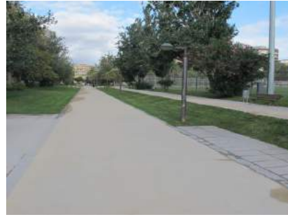
Solera rayada de hormigón
