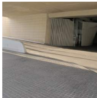
Acceso desde el cauce
