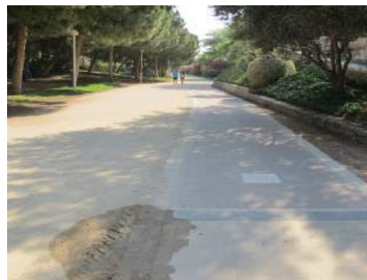
25 Carril bici con señalización horizontal
