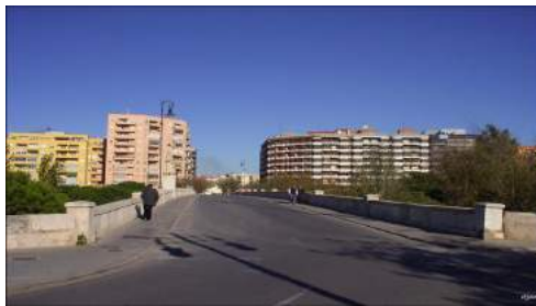
Vista puente de San José 1
