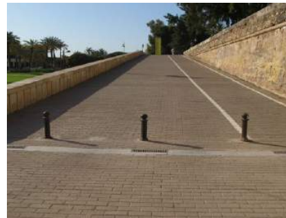
Vista rampa desde nivel inferior
