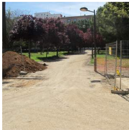
Obras en la intersección con el itinerario peatonal central
