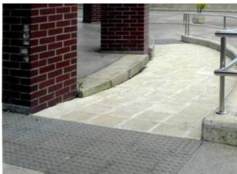
Franja de pavimento señalizador al desembarque de la rampa 46
