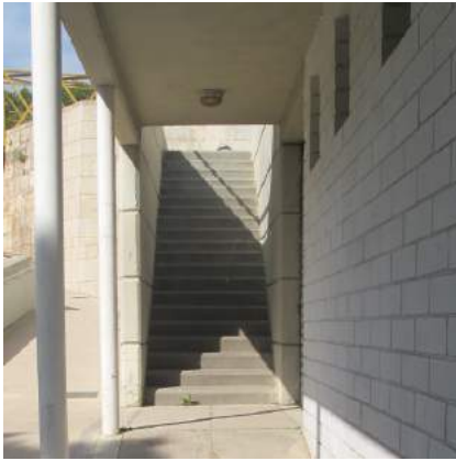
Iluminación tipo aplique colocada en el techo
