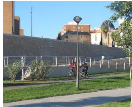
Escalera C y rampa G
