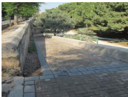
14 Vista de rampa desde cota superior
