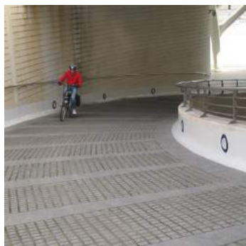
Rampa curva continua sin rellanos intermedios
