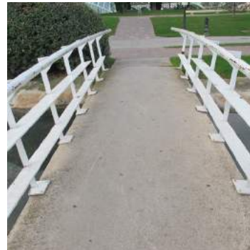
Pasarela de IT05
