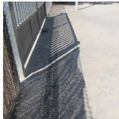
Puerta de acceso a instalaciones deportivas 2
