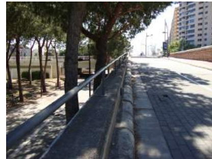
Protección lateral formada por pasamanos y pretil
