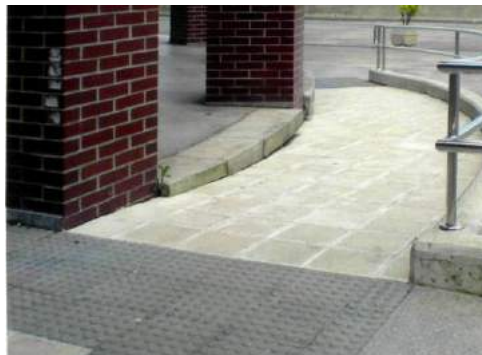
Franja de pavimento señalizador al desembarque de la rampa 44
