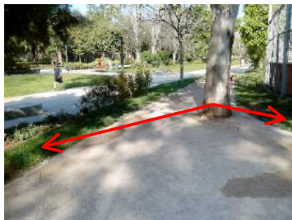
Estrangulamiento del itinerario peatonal
