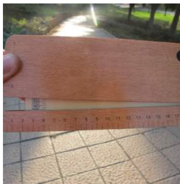
Pendiente de 5% de la rampa.
