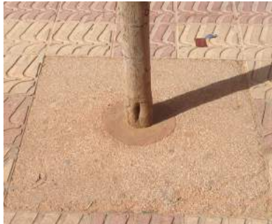
Material compacto en el alcorque 1
