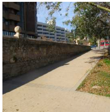
Rampa estado actual..
