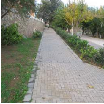
Vista inferior rampa
