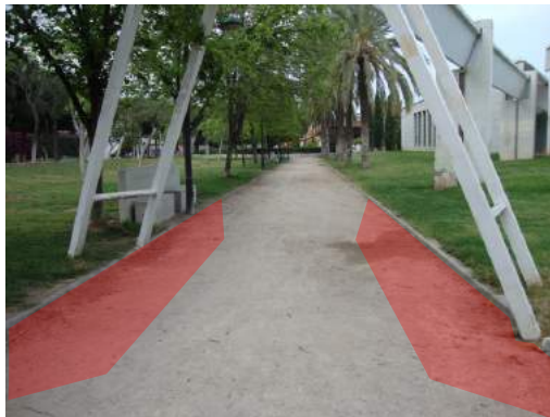
Estructura metálica invadiendo el itinerario peatonal
