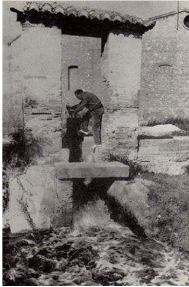
Acequia Rascaña derramador o aliviadero. 1960 8 .
