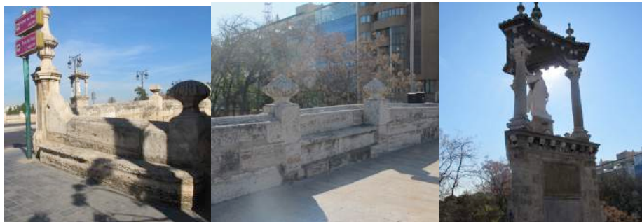
Entrada con banco y pináculo, banco interior lateral y casalicio del puente.
