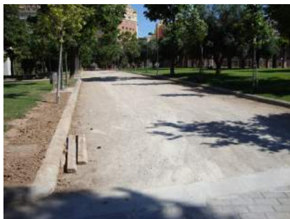
Vista general IT08 inicio
