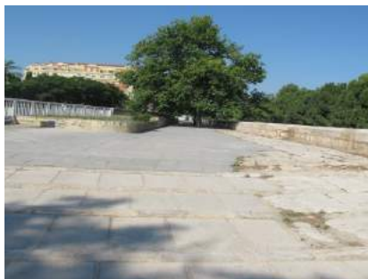
13 Vista de descansillo
