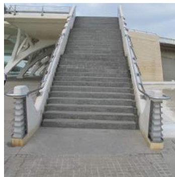
Tramos de la escalera 2
