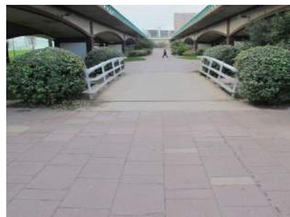
Itinerario transversal con baldosa hidráulica
