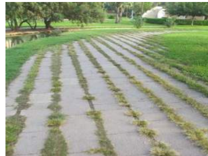
Cambio de pavimento a baldosa hidráulica
