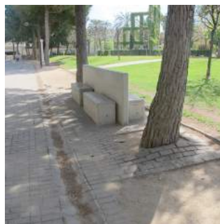
Banco de hormigón visto.
