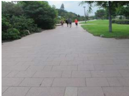
Itinerario peatonal de baldosa hidráulica
