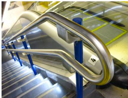
Detalle de prolongación de pasamanos doble. 110
