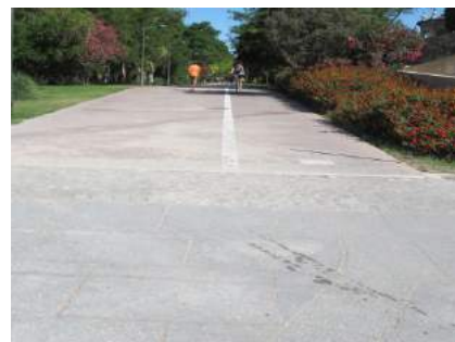
Perspectiva posterior del tramo final desde IT05 con badén
