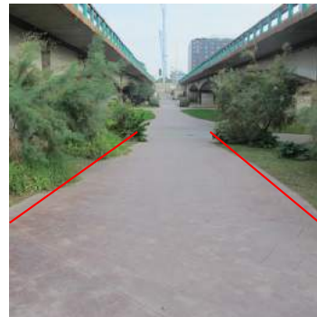
Colocación de bordillo perimetral
