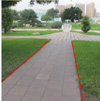
Colocación de bordillo perimetral
