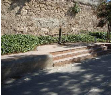
Escaleras para acceso a la fuente
