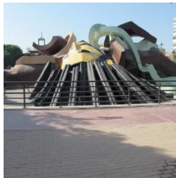
Barandilla ubicada en el acceso
