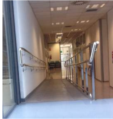
Pasamanos a doble altura de sección circular
