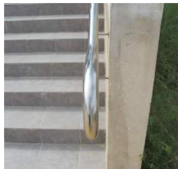
Separación a paramento vertical
