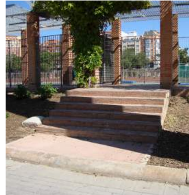
Escalera de acceso
