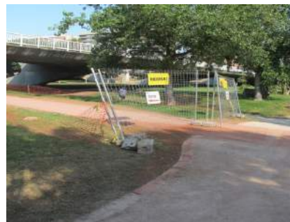
44 Vallado de acceso a zona de obras e información
