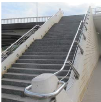
Tramos de la escalera 1
