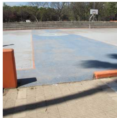
Acceso de la pista de baloncesto
