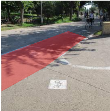
Colocación de pavimento táctil indicador en la intersección con el carril bici
