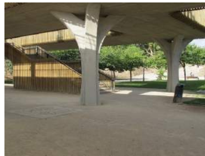
Falta de señalización para la ubicación de la escalera C
