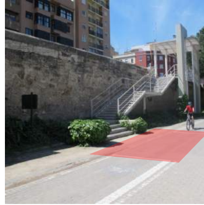
Falta de señalización vertical y horizontal por cruce de carril bici en el acceso al cauce por escalera 2
