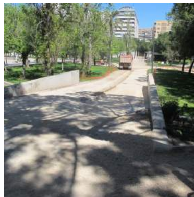
Rampa existente desde el Itinerario peatonal IL04
