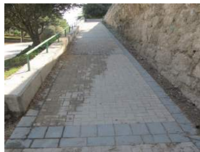
15 Vista de rampa desde cota inferior
