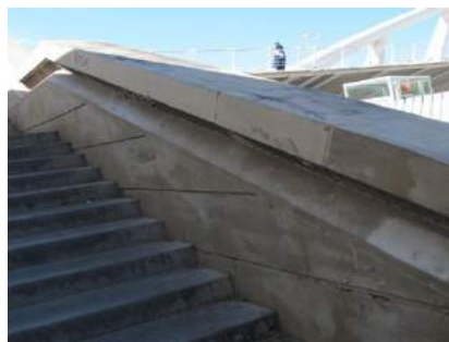
Instalación de alumbrado oculto
