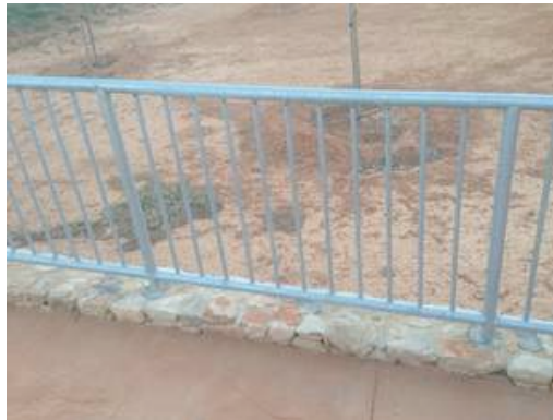
Apertura máxima entre elementos verticales de 10 cm
