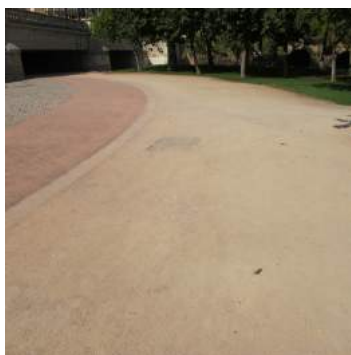
Presencia de trapas de instalaciones
