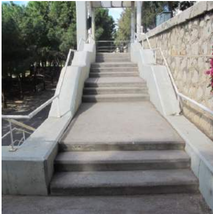
Escalera de tres tramos intermedios
