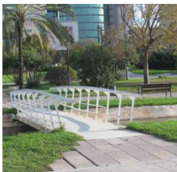
Pasarela con barandilla doble
