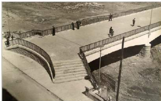
Escalinata de acceso a la pasarela de la Exposición 41 .
