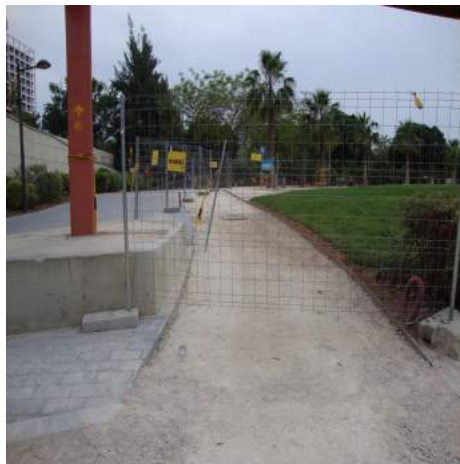
rampa de unión en obras del tramo 1-2
