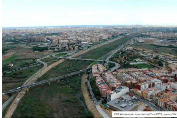
Vista aérea del Nuevo cauce del Río 25
