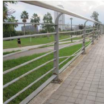
Falta de mantenimiento de los barrotes
