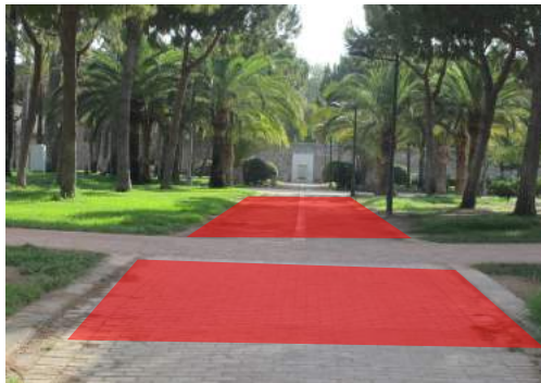
Colocación de pavimento de advertencia en el cruce con el carril running
