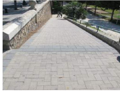
3 Vista de rampa desde cota superior
