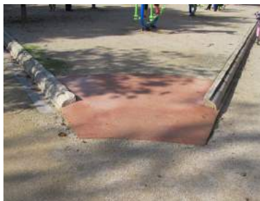
Acceso a las maquinas del circuito
