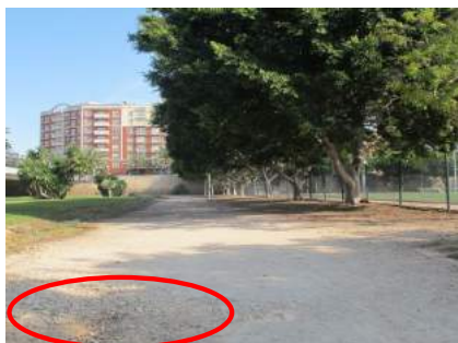
52 Pavimento disgregado.
