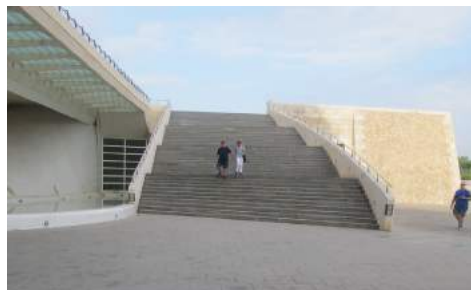
Tramos de la escalera A
