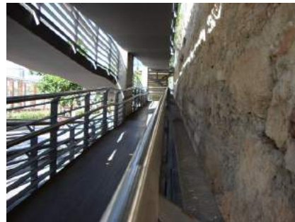
Detalle continuidad pasamanos
