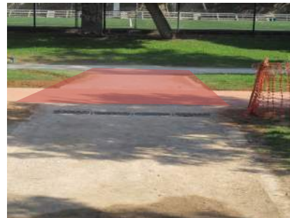
55 Cruce con itinerarios longitudinales.
