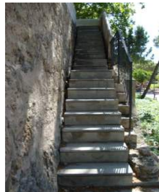
Primer tramo escalera
