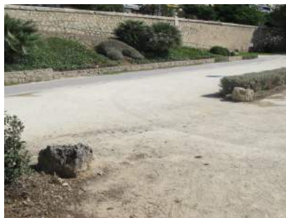
12 existencia de obstáculos en el acceso al edificio de mantenimiento.
