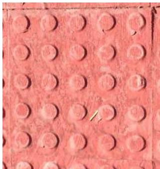
Pavimento táctil señalizador de botones de 20x20cm
