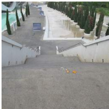
Vista escalera desde el vial de circulación1
