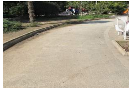
Pavimento de hormigón rayado.
