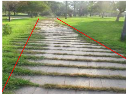
Colocación de bordillo perimetral
