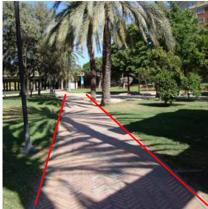
Colocación de bordillo para delimitación itinerario
