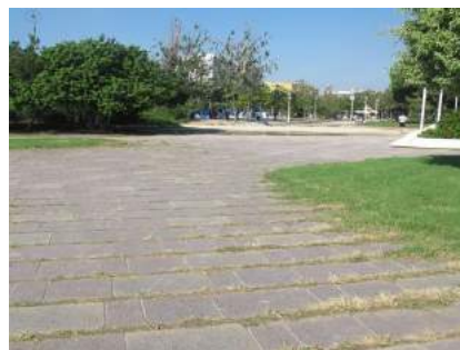
Baldosa hidráulica junta abierta longitudinal
