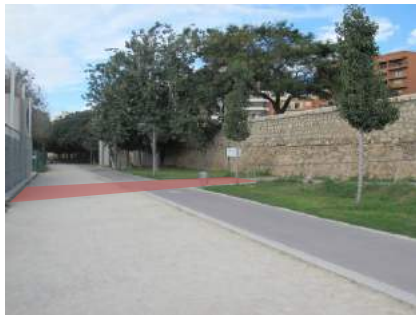
Falta de pavimento señalizador en el acceso al cauce
