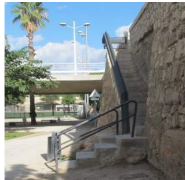
Desembarque de la escalera en el cauce.
