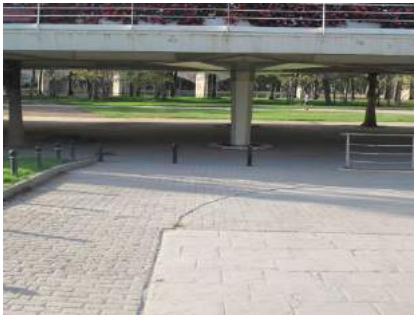
Transición a la rampa 9B que enlaza al tramo 10
