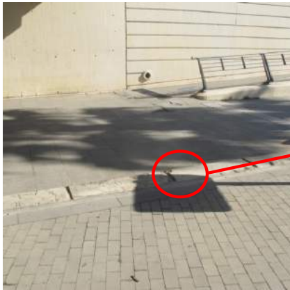
Bordillo de acceso al itinerario peatonal
