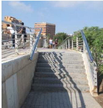
Único tramo de escalera C 1
