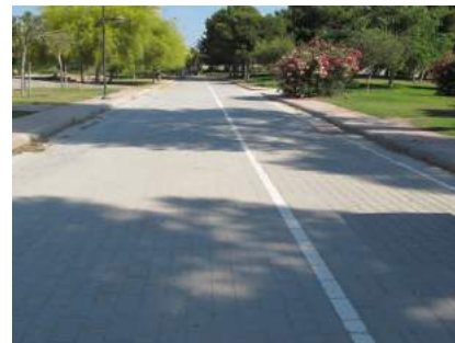
29 Demarcación de carril bici
