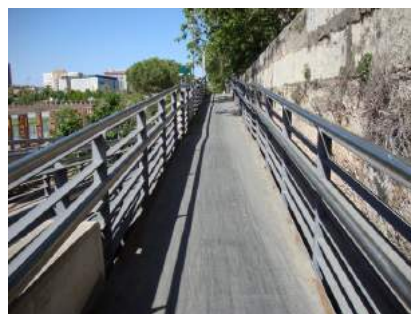
Vista tramo 1 de bajada
