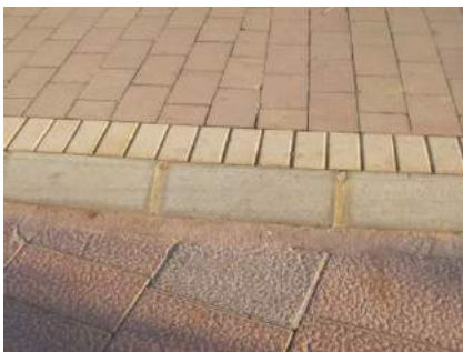
Bordillo delimitador entre itinerario peatonal y carril bici
