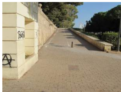
Vista rampa desde nivel inferior
