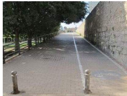
Vista rampa desde nivel inferior
