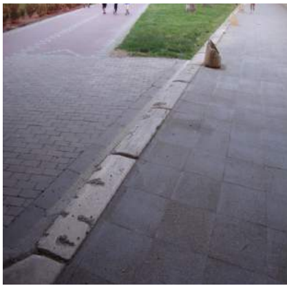
Bordillo de acceso al IL05
