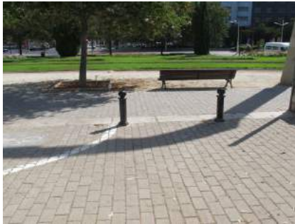
Estrechamiento por bolardos en rellano superior
