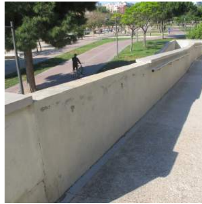
carencia de secciones de pasamanos y coronación muro
