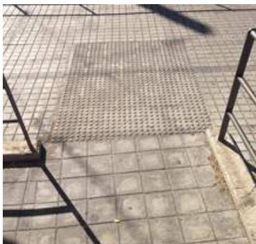
Pavimento táctil señalizador 59
