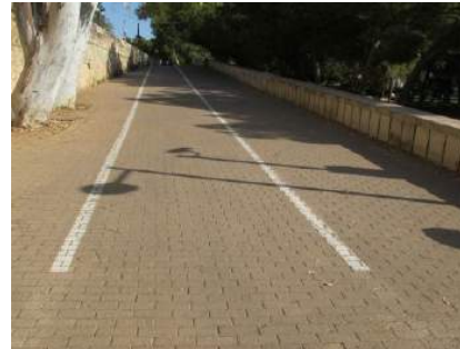
rampa desde nivel inferior
