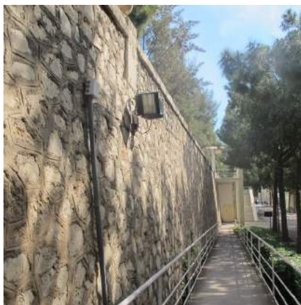
Luminaria tipo 3 proyector doble.
