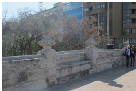
Banco del puente del Real
