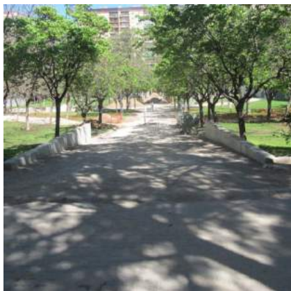
Rampa existente desde el Itinerario peatonal IL04
