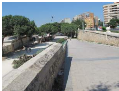
17 Vista de rampa desde cota superior
