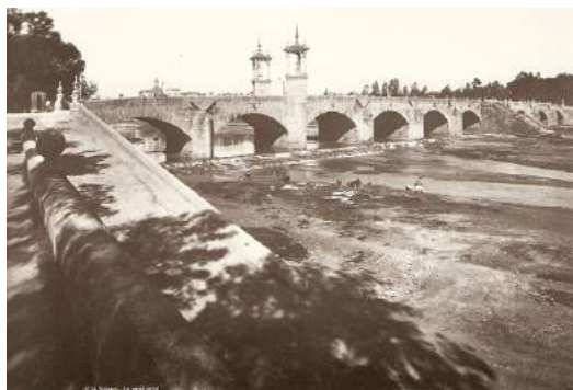
Rampa puente real 37
