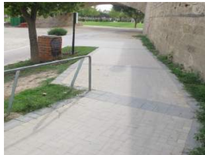
Falta de pasamanos en el desembarque al cauce
