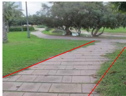
Colocación de bordillo perimetral
