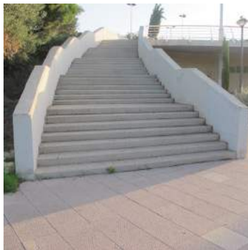
Tramos de la escalera A
