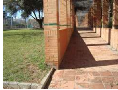
Vista de cerramiento que contiene la rampa
