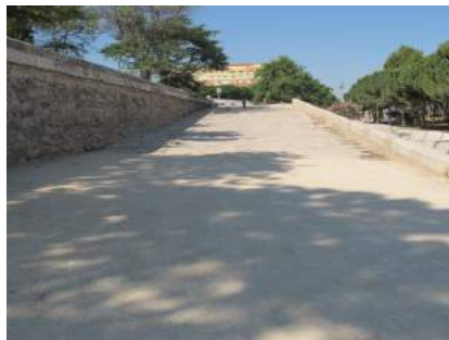
11 Vista de rampa desde cota inferior
