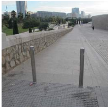
Bolardos en el embarque de la rampa
