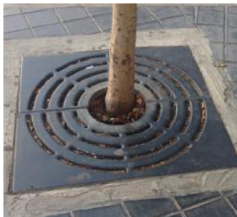
Alcorque protegido mediante rejilla.
