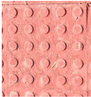
Pavimento táctil señalizador de botones de 20x20cm
