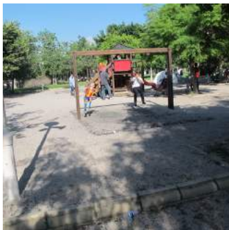
Desnivel entre pavimentos
