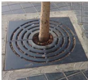
Cubre alcorque metálico
