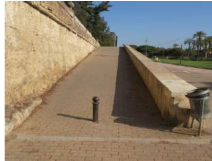
Vista rampa desde nivel inferior
