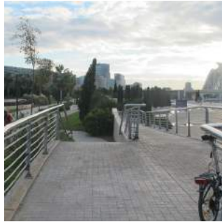
Conexión entre las rampas y la escalera
