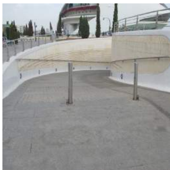
Vista superior rampa
