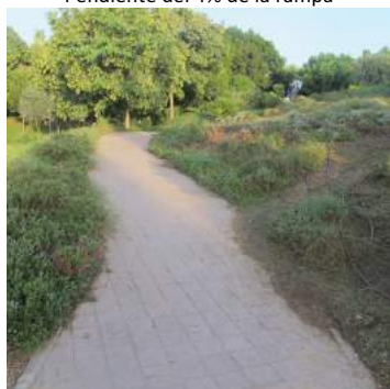
Vegetación en la rampa
