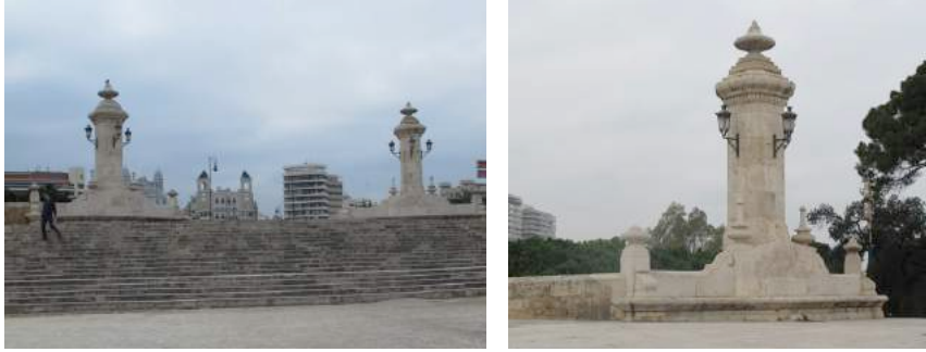
Escalinata de acceso al puente del Mar y banco de acceso al puente con gran pináculo.
