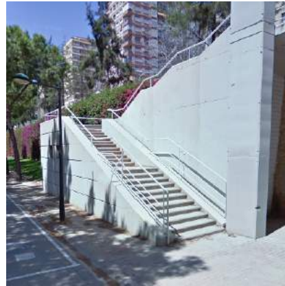
Escalera con dos tramos con rellano intermedio
