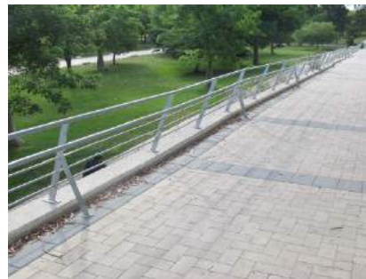
Detalle guardacuerpos lateral y anclajes
