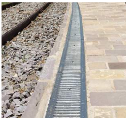
Canaleta con abertura de hueco de 1 cm 141
