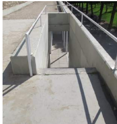
Falta de pavimento señalizador en el embarque
