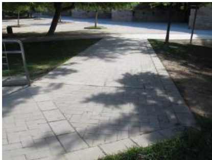
Arranque rampa y encuentro con itinerario
