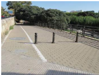
Estrechamiento por bolardos en rellano superior
