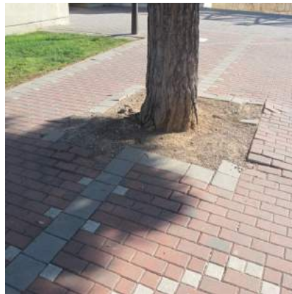
Alcorque levantado por la acción de las raíces
