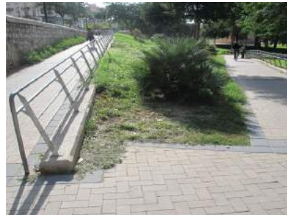
Falta de pasamanos inferior y superior 1
