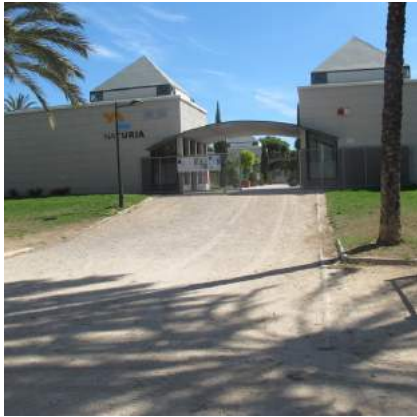
Rampa de tierras compactadas
