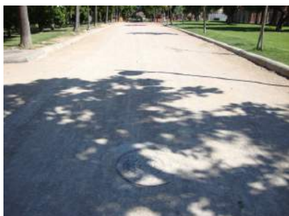
Registros de saneamiento en IT08
