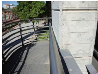
Vista separación lateral pasamos
