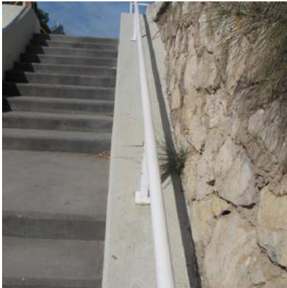
Pasamanos de sección circular colocado sobre un zócalo de hormigón
