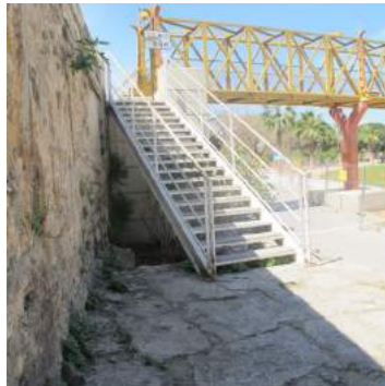
Escalera metálica con tabica abierta
