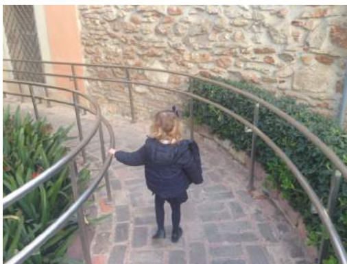
Pasamanos a doble altura de sección circular
