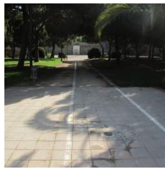
Cambio de pavimento el la intersección de itinerarios peatonales
