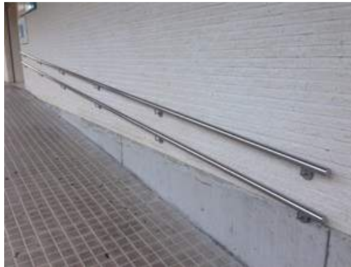
Pasamanos a doble altura de sección circular
