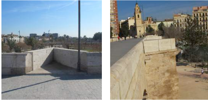
Miradores rehabilitados del puente de Serranos.
