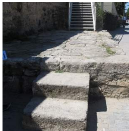
Escalera de tres peldaños de 0,92 cm
