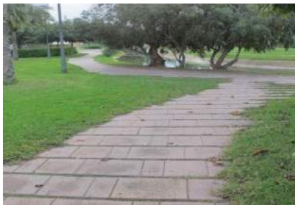
Inicio del pavimento de baldosa hidráulica
