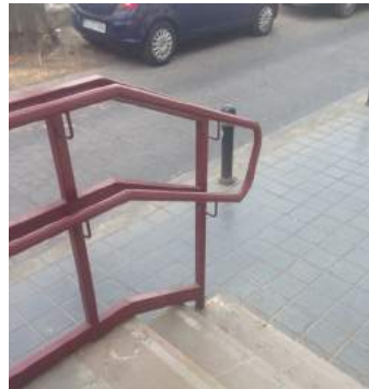
Pasamanos a doble altura y prolongación del mismo
