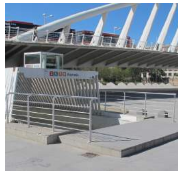
Boca de metro
