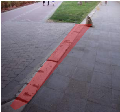
Bordillo existente en el acceso a la rampa
