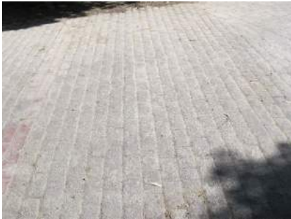
Pavimento hormigón impreso
