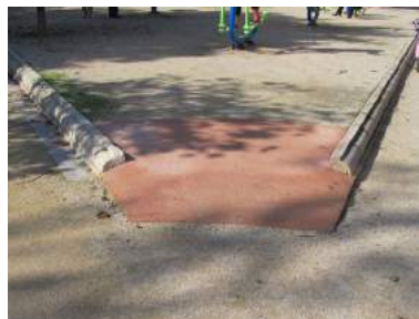
Acceso a las maquinas
