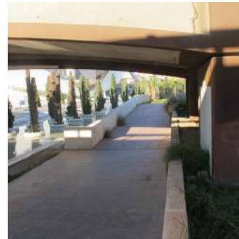
desnivel para acceder a La CAC
