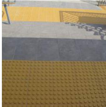
Pavimento señalizador en el embarque y desembarque
