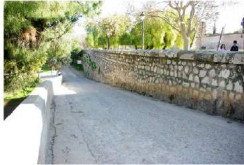
Rampa de bajada al cauce próximo al puente de San José.
