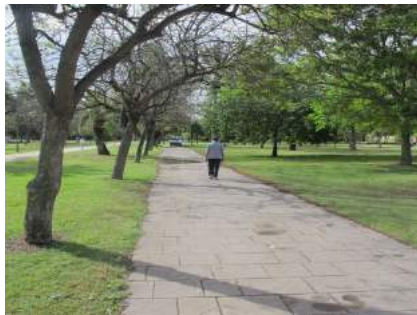
Hormigón impreso en tramo 7
