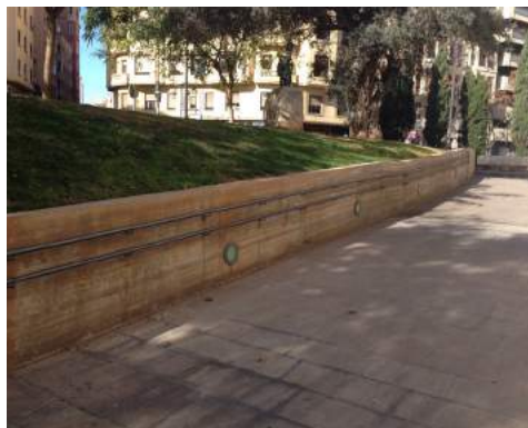
Pasamanos a doble altura de sección circular
