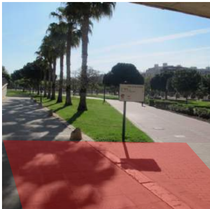
Falta de pavimento de señalización de advertencia al cruzar carril bici
