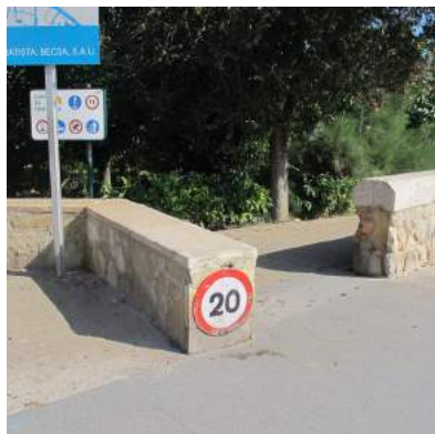
Cartel instalado detrás del antepecho de la rampa de acceso
