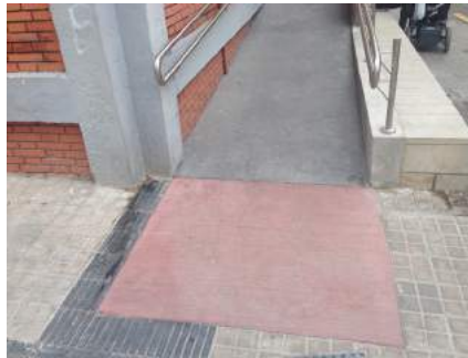
Pavimento señalizador de inicio y fin de rampa.
