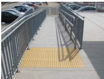
Pavimento señalizador
