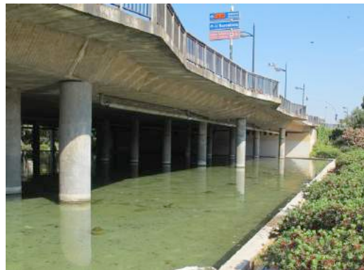
Vista inferior del puente.
