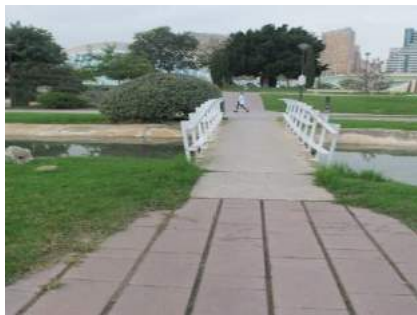
Itinerario transversal con baldosa hidráulica y junta abierta
