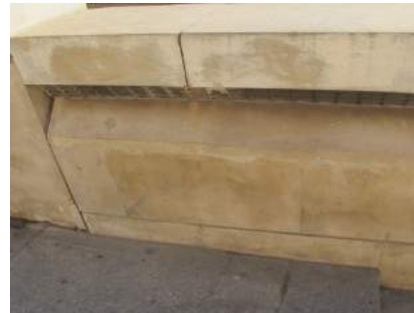
Sistema de alumbrado oculto
