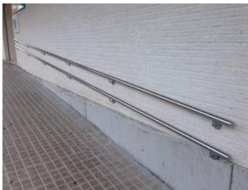
Pasamanos a doble altura de sección circular
