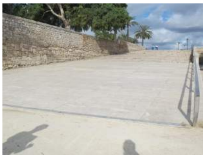
Vista de la rampa desde el cauce.
