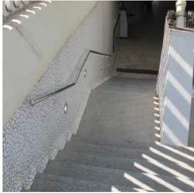
Estrangulamiento en el rellano
