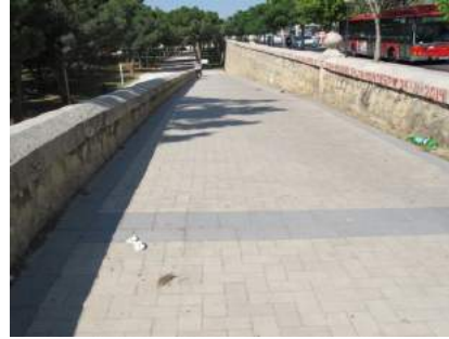
7 Vista de rampa desde cota superior
