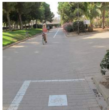
Falta de señalización y diferenciación de pavimento en el acceso
