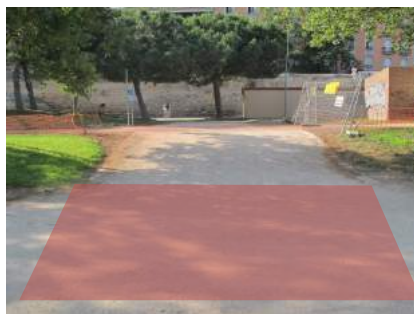
53 Falta de pavimento señalizador o advertencia
