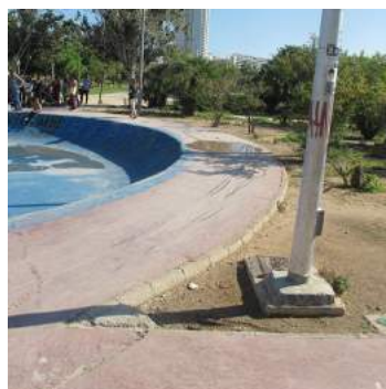
Pasillo lateral de la zona de monopatín
