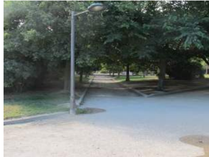
Ramaje que invade parte del itinerario
