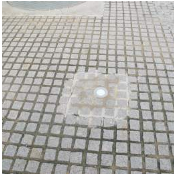
Reparación de la luminaria
