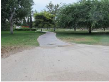
Pavimento baldosa hidráulica
