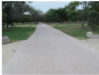
Pavimento de hormigón impreso
