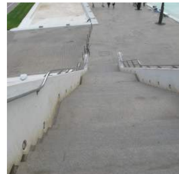
Vista escalera desde el vial de circulación 2
