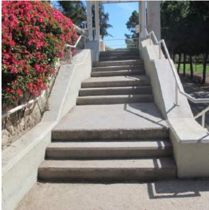
Escaleras de tres tramos intermedios
