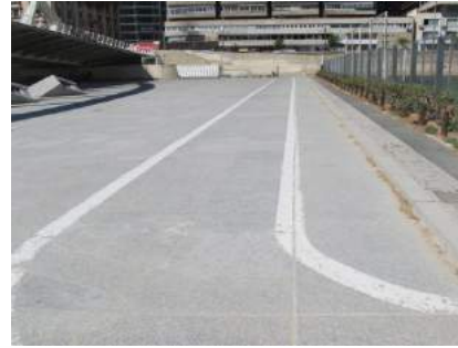
Señalización horizontal en el carril bici
