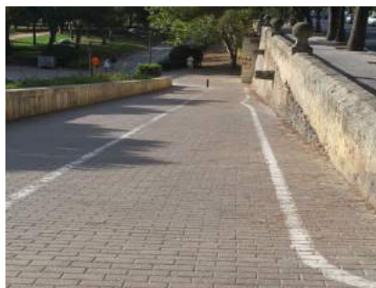
Vista rampa desde nivel superior
