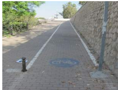
Vista rampa desde nivel inferior
