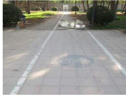
Carril bici con señalización horizontal
