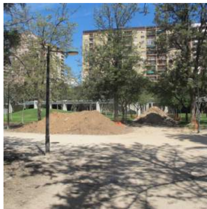
Obras en la intersección con el itinerario central
