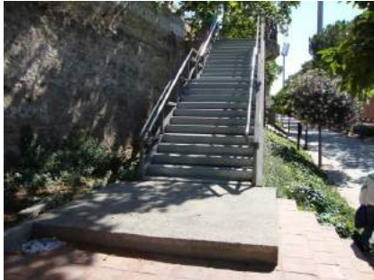
Escaleras de dos tramos con relleno intermedio
