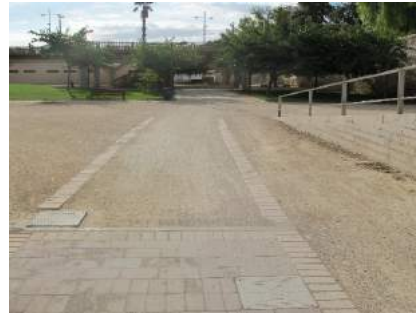
Cambio de pavimento del carril bici
