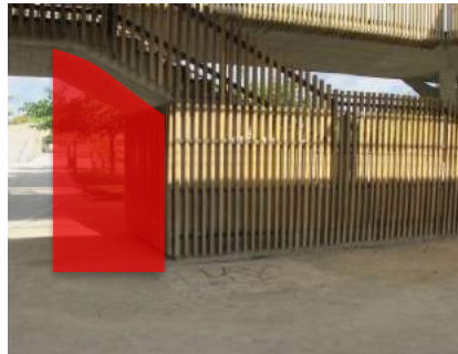
Protección bajo escalera.
