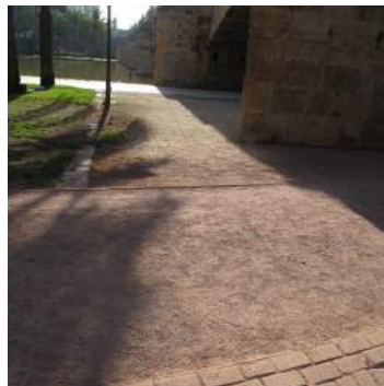
Intersección con el itinerario peatonal transversal IT02
