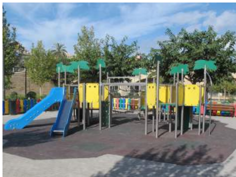
Pavimento de caucho continuo
