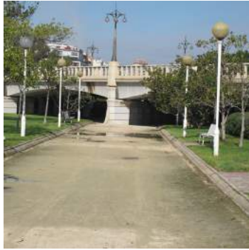
Luminaria colocada a tresbolillo
