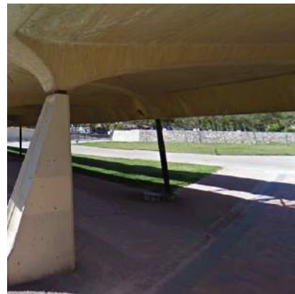
Rigola de recogida de agua en la intersección del itinerario peatonal
