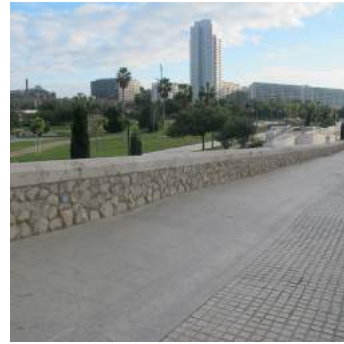
Antepecho de la rampa a 1,10 m
