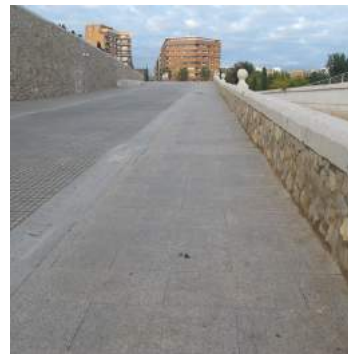
Vista inferior rampa
