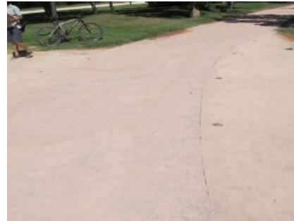
Delimitadores direccionales de carril en intersección con IT02
