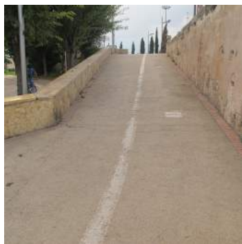
Vista inferior rampa
