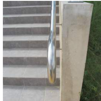
Separación a paramento vertical
