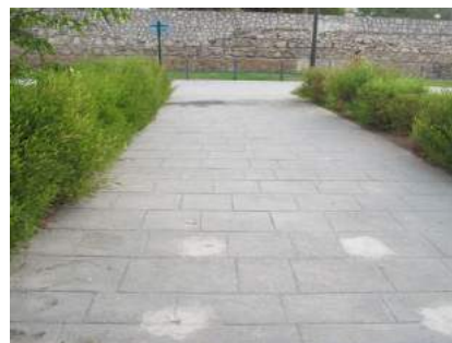
Pavimento de hormigón impreso
