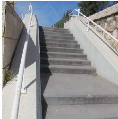
Meseta intermedia de 1,40 m de longitud
