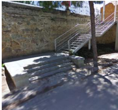
Vista escalera tramo 1 y tramo 2
