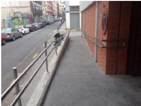
Pasamanos doble en ambos lados de la rampa
