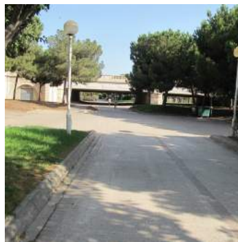
Luminarias distribuidas en zig zag
