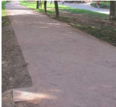
Illuminación en zigzag del carril running
