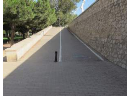
Rampa desde nivel inferior
