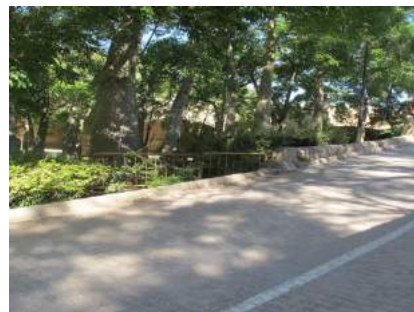
1 Vista pretil de protección lateral y bordillo
