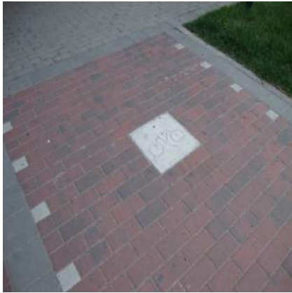
Señalización insertada en el pavimento
