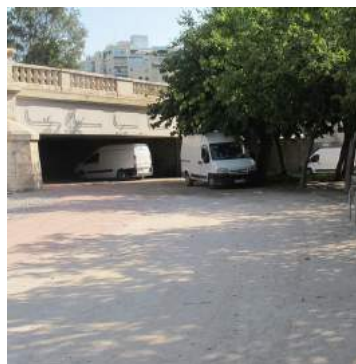
Presencia de vehículos en el Itinerario peatonal
