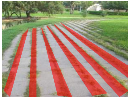
Relleno de las juntas del pavimento de baldosa hidráulica.
