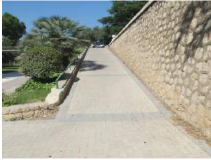
2 Vista de rampa desde cota inferior
