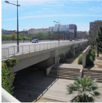
Vista del Puente de Campanar
