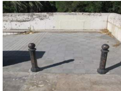
Estrechamiento acceso rampa
