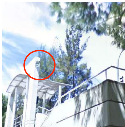
Iluminación tipo halógena existente
