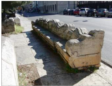
Banco de piedra de estructura barroca 27
