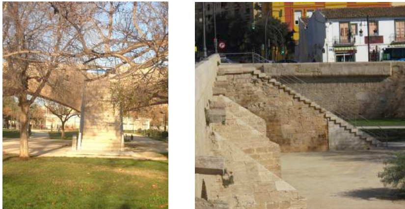
Escalinatas reconstruida en el año 2009.
