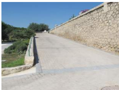
4 Vista de rampa desde cota inferior
