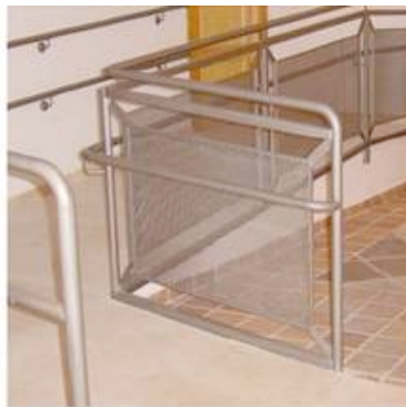
Malla microperforada para tapado de espacio libre. 154
