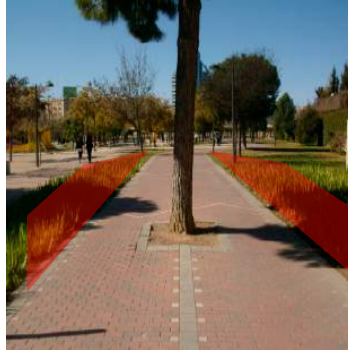
Ampliación de pavimento lateralmente
