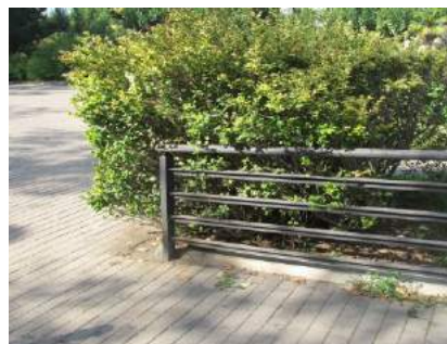
Terminacion proteccion lateral
