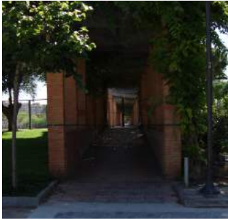
Acceso por rampa
