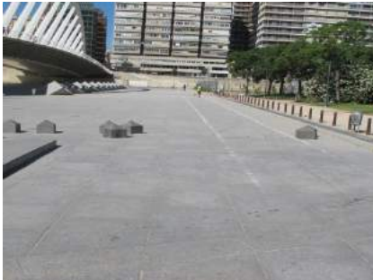
Pavimento de baldosas de granito
