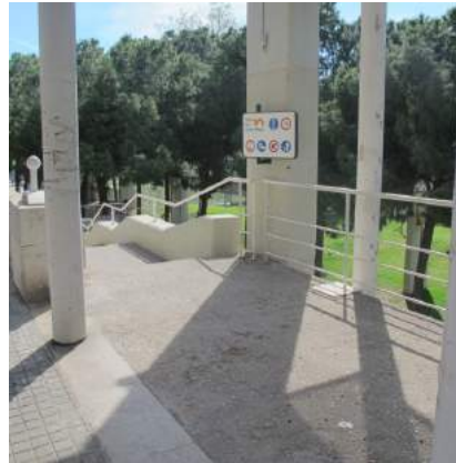
Falta de pavimento señalizador al embarque
