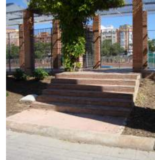
Acceso por escalera
