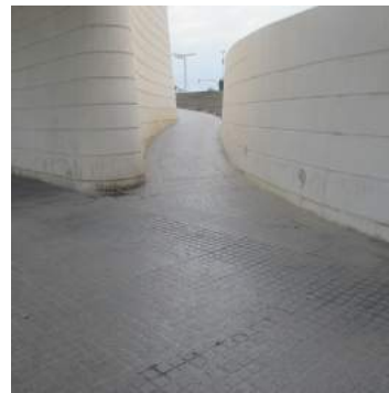
Vista inferior rampa
