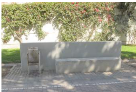
Banco de hormigón visto con mobiliario urbano
