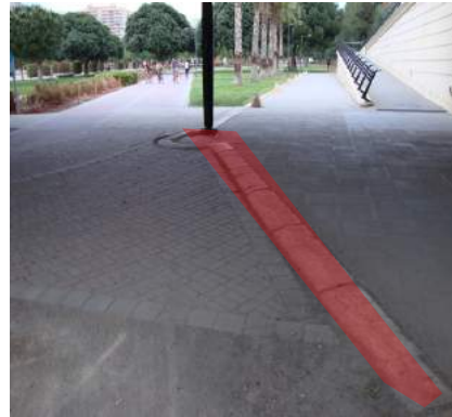
Bordillo existente en el acceso a la rampa 2
