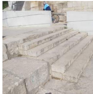
Hueco en el antepecho situado en la meseta intermedia
