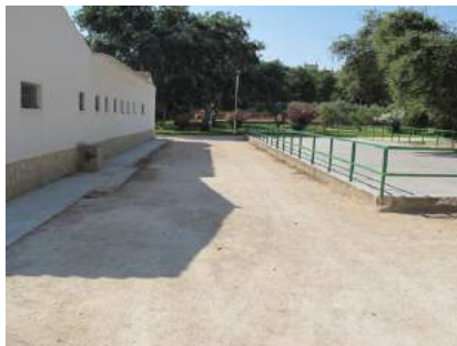
10 Acceso a edificio de mantenimiento y pista de patinaje
