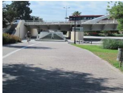
Hormigón impreso en tramo 8
