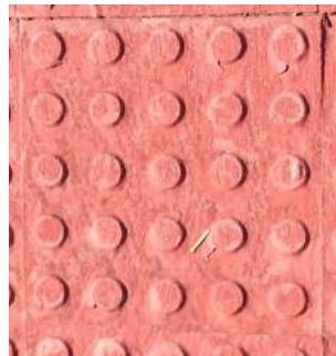
Pavimento táctil señalizador de botones de 20x20cm
