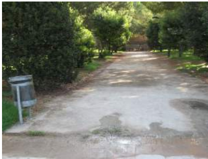
Itinerario transversal de arena compactada
