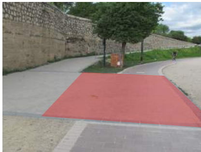
Falta de pavimento de advertencia en la intersección con el carril bici.
