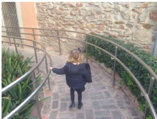
Pasamanos a doble altura de sección circular
