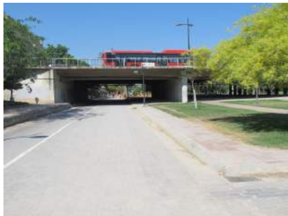
21 Tramo de enlace con tramo 3
