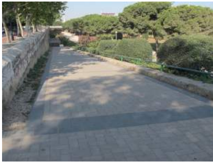
18 Vista de rampa desde cota superior
