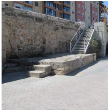
Vista escalera de dos tramos
