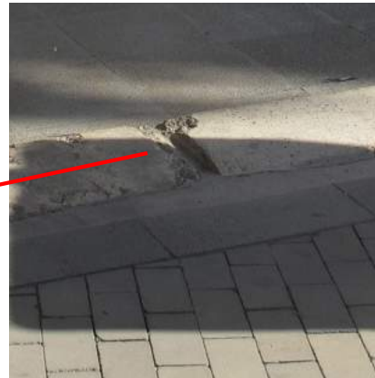
Detalle bordillo de acceso al itinerario peatonal
