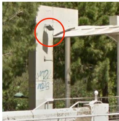
luminación tipo halógena
