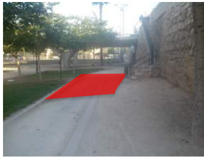
Falta de pavimento señalización de advertencia
