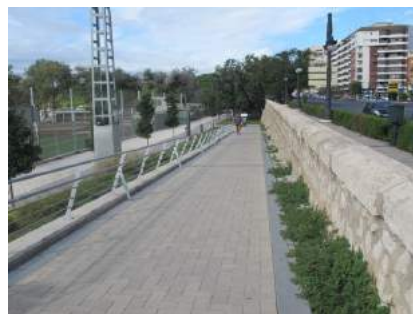
Vista rampa II
