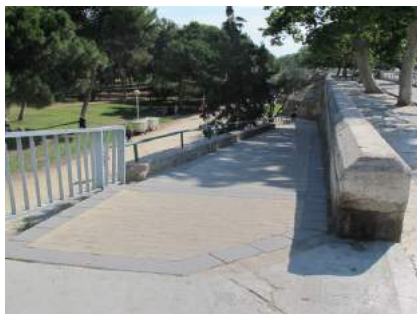
8 Vista de rampa desde cota superior
