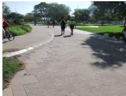
Bordillo delimitador en encuentro con itinerario peatonal
