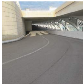
Vista superior rampa
