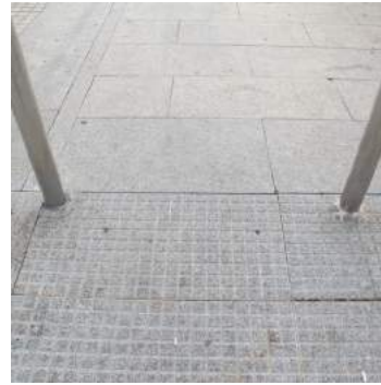
Pavimento señalizador realizado en granito
