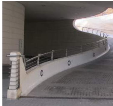
Iluminación en antepecho de la rampa H del tramo 12B-15
