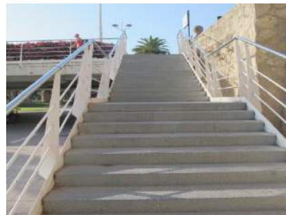
Vista frontal desde nivel inferior
