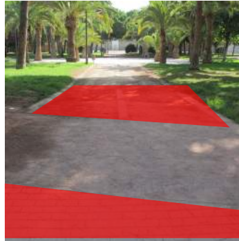
Colocación de pavimento de advertencia en el cruce con el carril running
