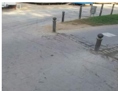
Finalización de itinerario junto rampa 9A
