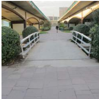
Pasarela de 3,30m para cruzar de un lado al otro del itinerario
