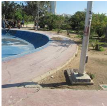
Pasillo lateral de la zona de monopatín
