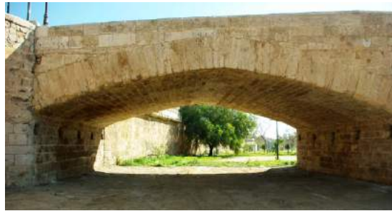
Arco apuntado de una rosca, ligeramente rebajado.
