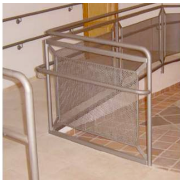
malla microperforada para tapado de espacio libre. 34
