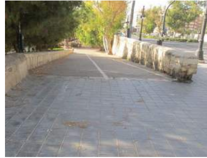
Vista rampa desde nivel superior
