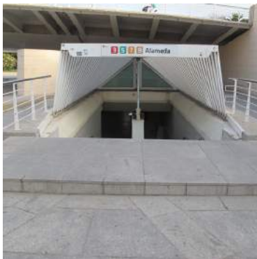
Acceso desde el cauce
