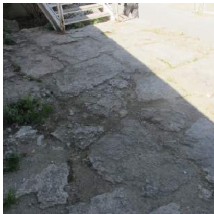
Pariente con resaltes y hundimientos
