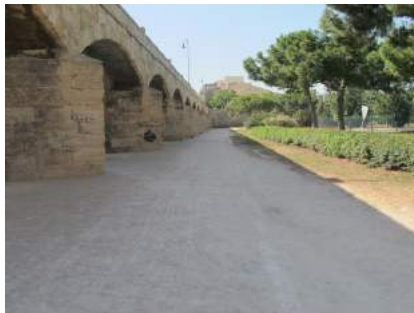
Itinerario transversal bajo el Puente de San Jose
