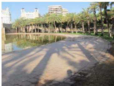
1 Pavimento baldosa hidráulica
