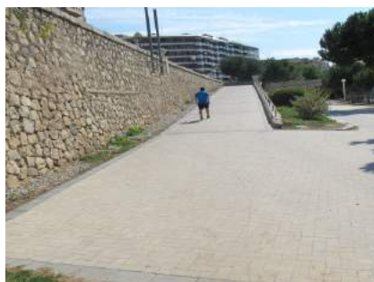
16 Vista de rampa desde cota inferior
