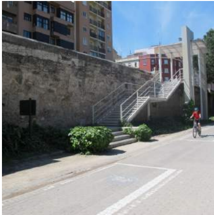
Vista escalera tramos 1 y 2
