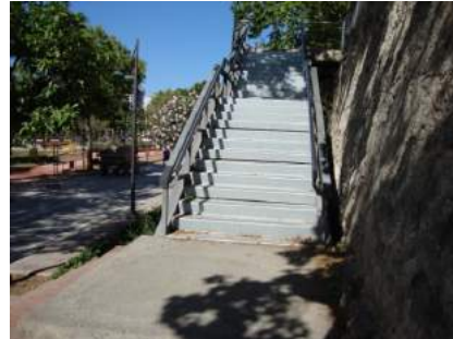
Escaleras de dos tramos con relleno intermedio
