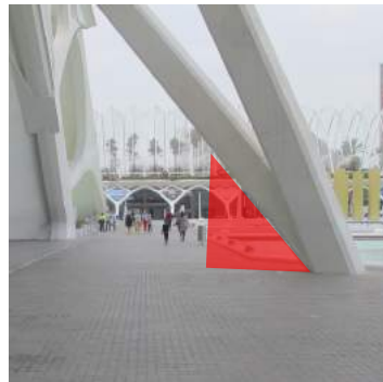
Delimitación de los pilares
