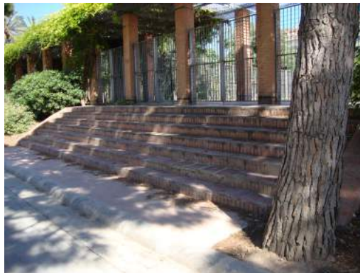
Escalera de acceso 2
