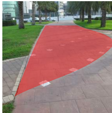
Colocación de pavimento de botones en intersección de itinerarios
