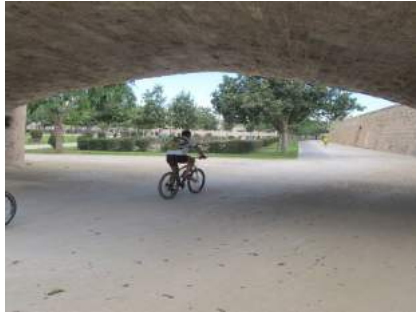
Enlace bajo puente de la Trinidad
