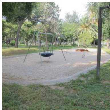
Bordillo perimetral de hormigón
