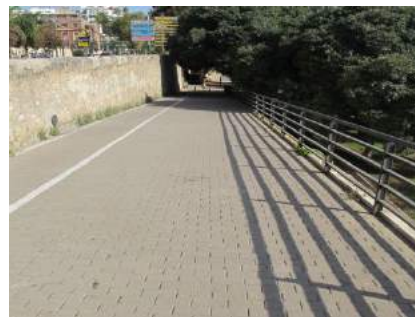
Vista desde tramo intermedio
