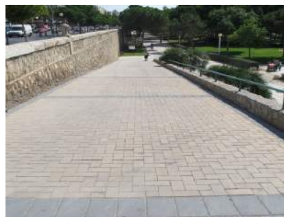
5 Vista de rampa desde cota superior
