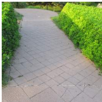
Acceso a la rampa
