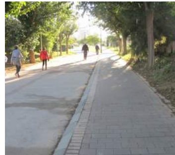
Carril bici delimitado con un bordillo
