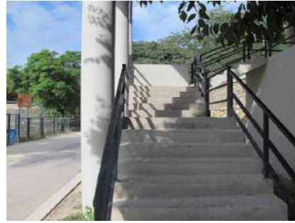
Vista inferior de la escalera
