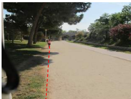
48 Falta de bordillo separador con zonas verdes
