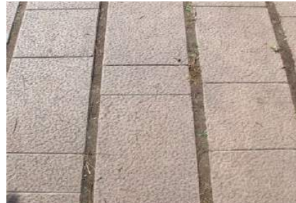
Baldosa hidráulica con junta de 5cm
