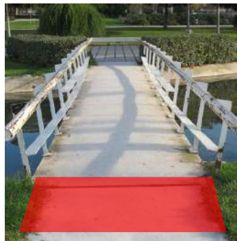
Diferenciación de pavimento al inicio y fin de la pasarela
