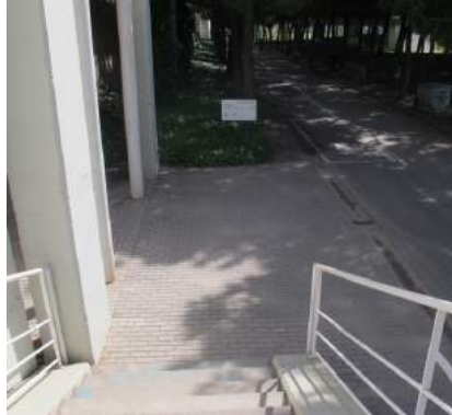
Falta de pavimento señalizador en el desembarque
