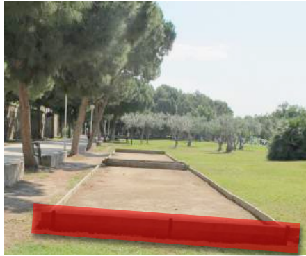
Eliminación de tabloncillos de madera para acceder a cota 0,00 metros
