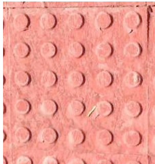
Pavimento táctil señalizador de botones de 20x20cm
