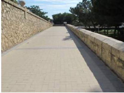
6 Vista de rampa desde cota inferior
