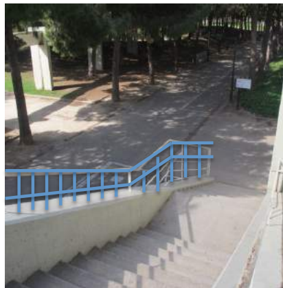
Colocación de montantes verticales cada 10 cm
