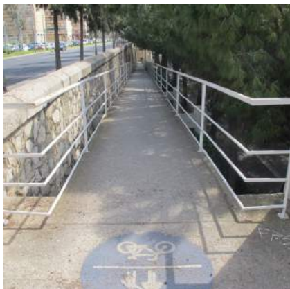
Falta de pavimento señalizador al inicio de la rampa
