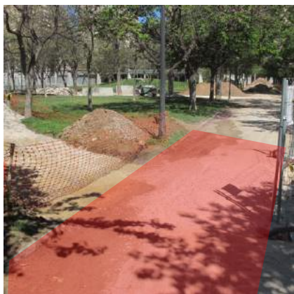
Obras en el itinerario peatonal IT03
