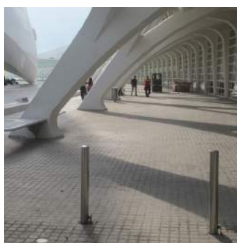
Bolardos en el Itinerario peatonal 1
