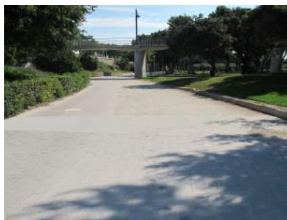
2 Fin tramo enlace y cambio pavimento
