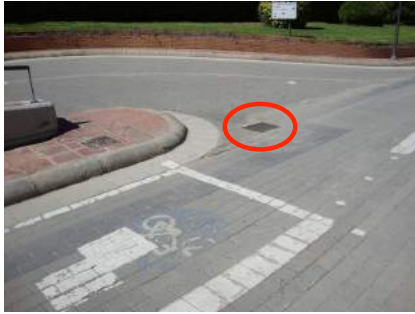
Rejilla en encuentro acceso-itinerario
