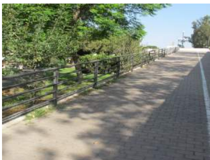
Vista proteccion lateral
