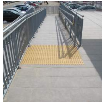
Pavimento señalizador al desembarque 2
