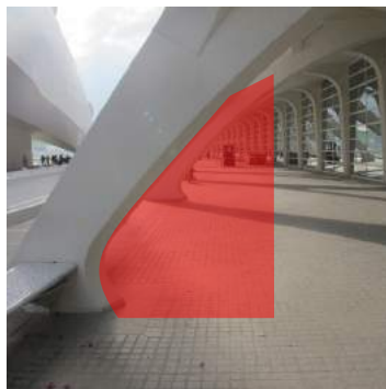
Delimitación de los pilares
