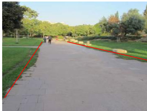
Colocación de bordillo perimetral
