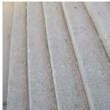
Acabo del escalón con hormigón raspado
