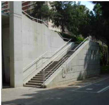
Escalera de dos tramos con rellano intermedio
