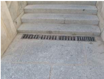
Canaleta de recogida de aguas
