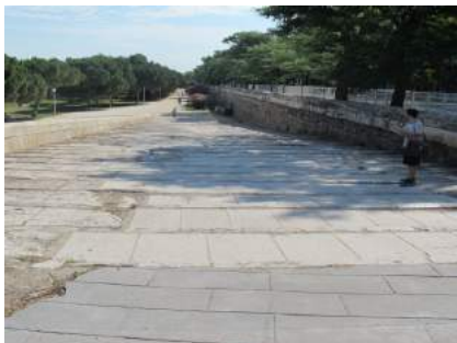
10 Vista de rampa desde cota superior
