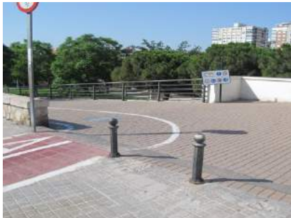
Estrechamiento por bolardos en rellano superior
