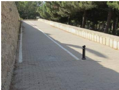
Vista rampa desde nivel inferior
