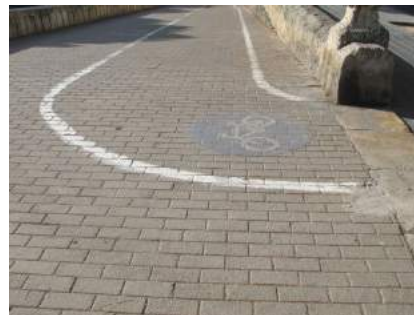
Señalización carril bici en nivel superior
