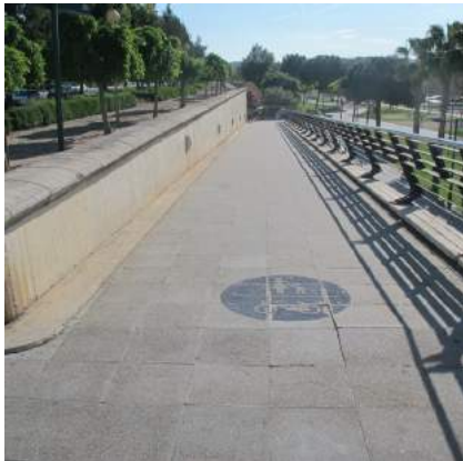
Acceso rampa compartida con carril bici y carencia de pavimento señalizador al inicio
