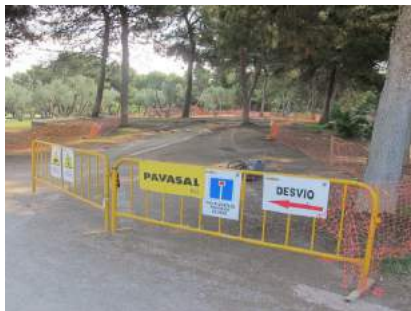
20 Vallado de zona de obras con señalización de desvíos provisionales
