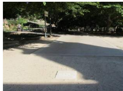
Carril bici con señalización horizontal
