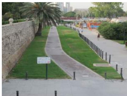
Pavimento baldosa hidráulica
