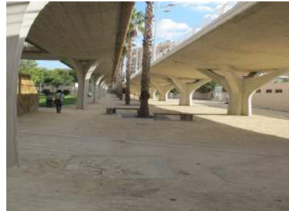
Antiguas cimentaciones ubicadas en el itinerario peatonal
