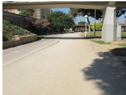
22-23 Vista general del itinerario al paso bajo pasarela
