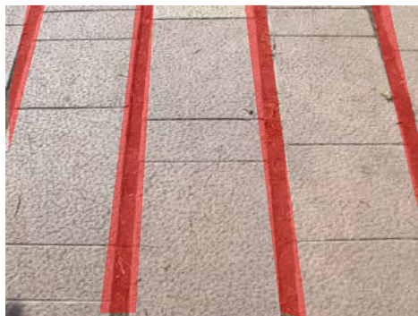
Relleno de las juntas de pavimento de baldosa de hormigón prefabricado.
