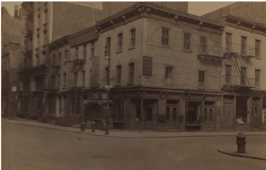
Figura 5.4.2: Vista de las calle Lispenard Street en el barrio de Tribeca mostrando los edificios residenciales convertidos en edificios comerciales con escaparates en planta baja (1928). Fuente: Irma and Paul Milstein Division of United States History, Local History and Genealogy, The New York Public Library. Manhattan: Lispenard Street - Church Street
