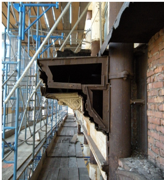
Figura 5.2.9: Fotografía en sección de una fachada de fundición. Las ménsulas ancladas a las columnas de fundición soportan la cornisa de fundición. Fotografía: Marie Ennis (2010)
