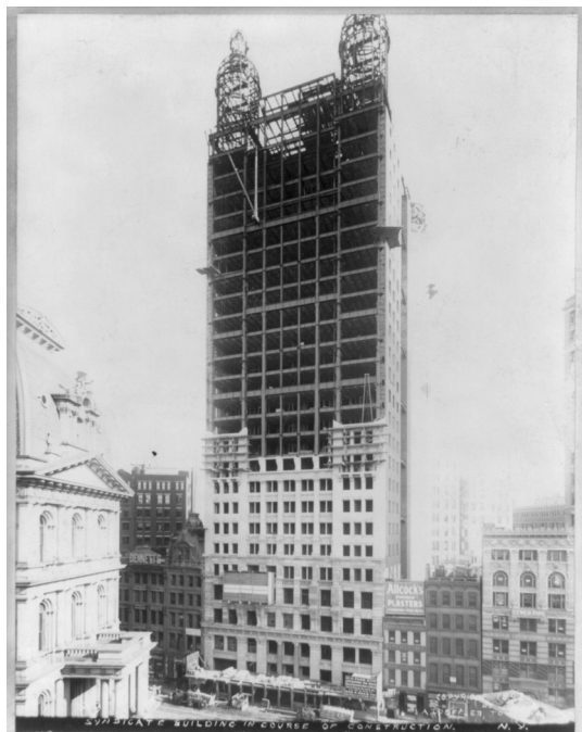
Figura 2.2.4: Edificio 15 Park Row Building en construcción en 1898 mostrando su esqueleto de acero, Manhattan. Fuente: Library of Congress. Prints & Photographs Division, LC-USZ62-41748.
