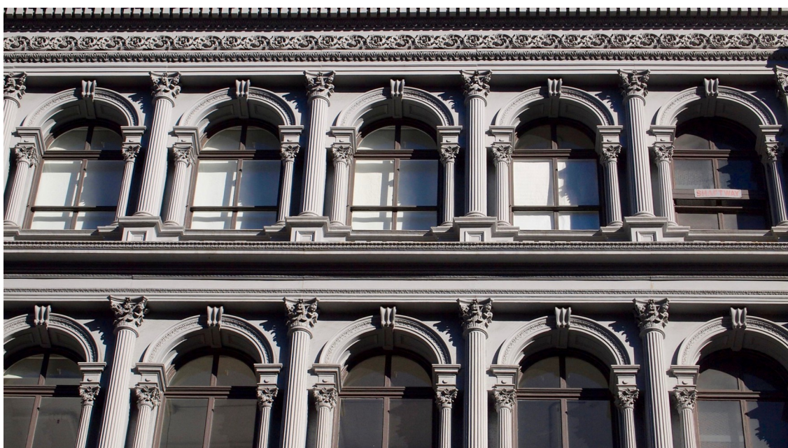
Figura 5.2.6: Haughwout Building (1857). Fotografía de los detalles ornamentales que se podían conseguir en un edificio de fundición. Fotografía del autor (2015)
