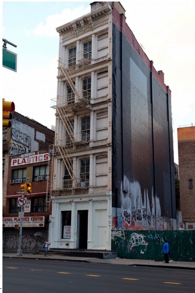
Figura 5.2.5: Edificio de fundición situado en Canal Street en la ciudad de Nueva York construido en 1868. Fotografía del autor.
