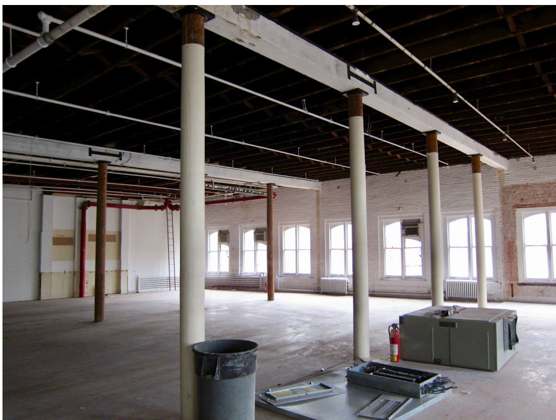
Figura 5.2.10: Fotografía interior de un típico edificio de fundición. Edificio situado en Greene Street, Nueva York. Fotografía del autor (2015).
