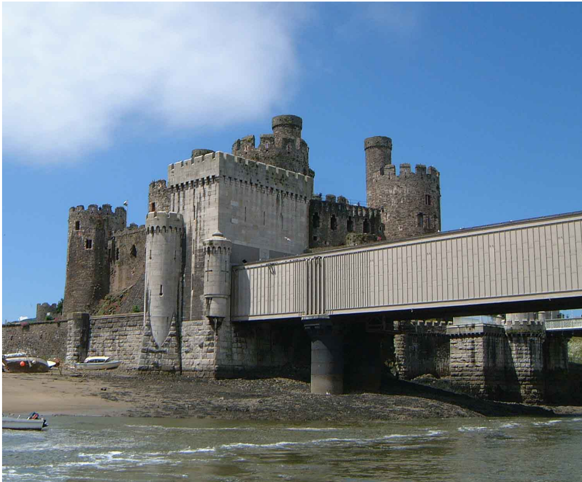
Figura 4.2.2: The Conwy railway bridge. Puente the Conwy construido entre 1846 y 1849. William Fairbairn fue contratado como asesor de la estructura y ejecución del puente. Fuente: Mick kNapton at English Wikipedia
