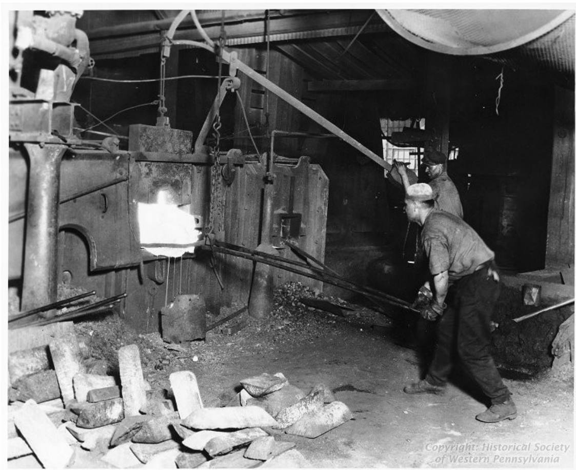
Figura 3.9.11: Extracción de la bola de hierro para ser martilleado y posteriormente laminado para realizar el hierro forjado. Fuente: Historical Society of Western Pennsylvania
