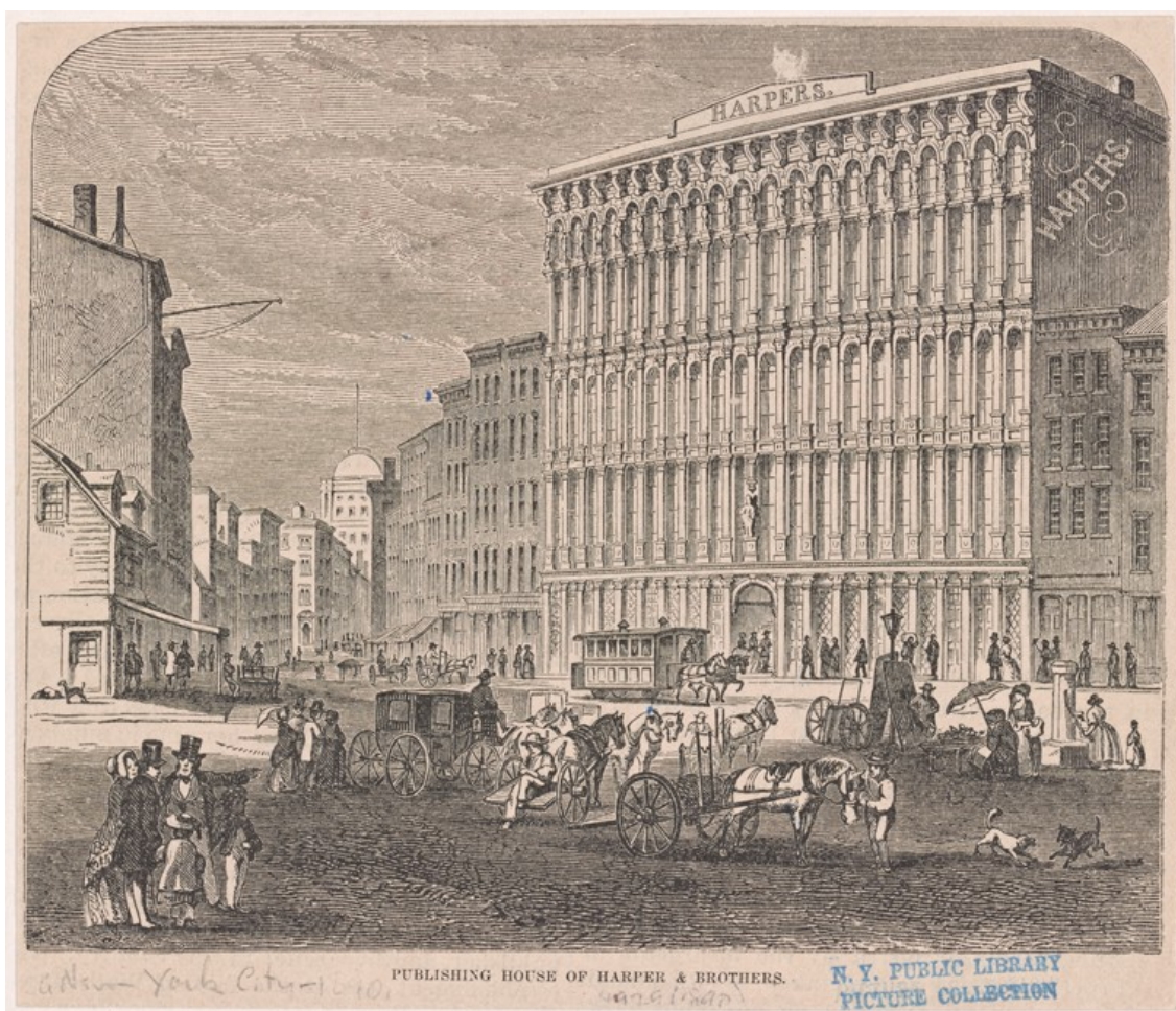
Figura 3.9.7: Edificio de la imprenta Harpers & Brothers construido en 1854 y diseñado por James Bogardus con una estructura completa de hierro. Fuente: New York Public Library
