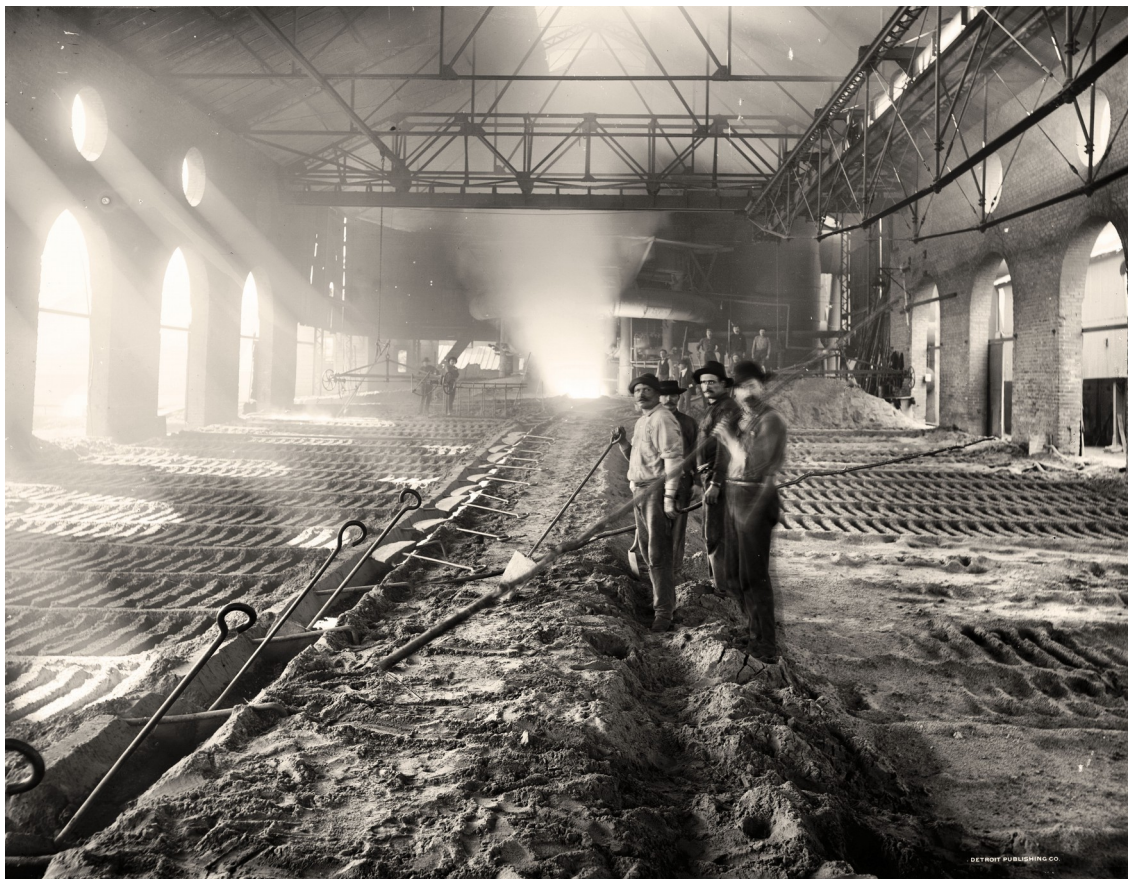
Figura 3.9.12: Trabajadores de los altos hornos preparando la arena para verter el hierro fundido y formar los moldes. Chicago, 1890. Fuente: Detroit Publishing Company.
