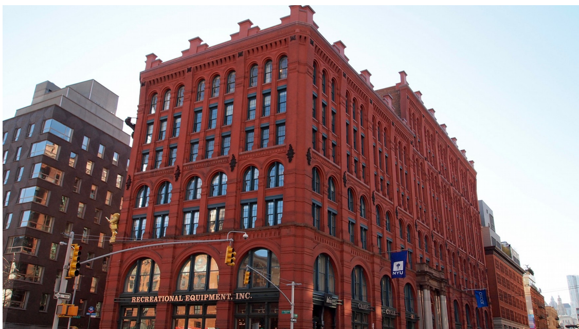
Figura 5.2.7: Puck Building (1886) situado en 295-307 Lafayette Street. Es un ejemplo de Richardsonian Romanesque. Fotografía del autor (2015).
