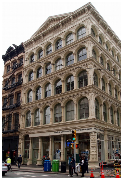
Figura 2.2.3: Edificio típico con fachada de fundición construido alrededor de 1860 en Nueva York. Fotografía del autor.
