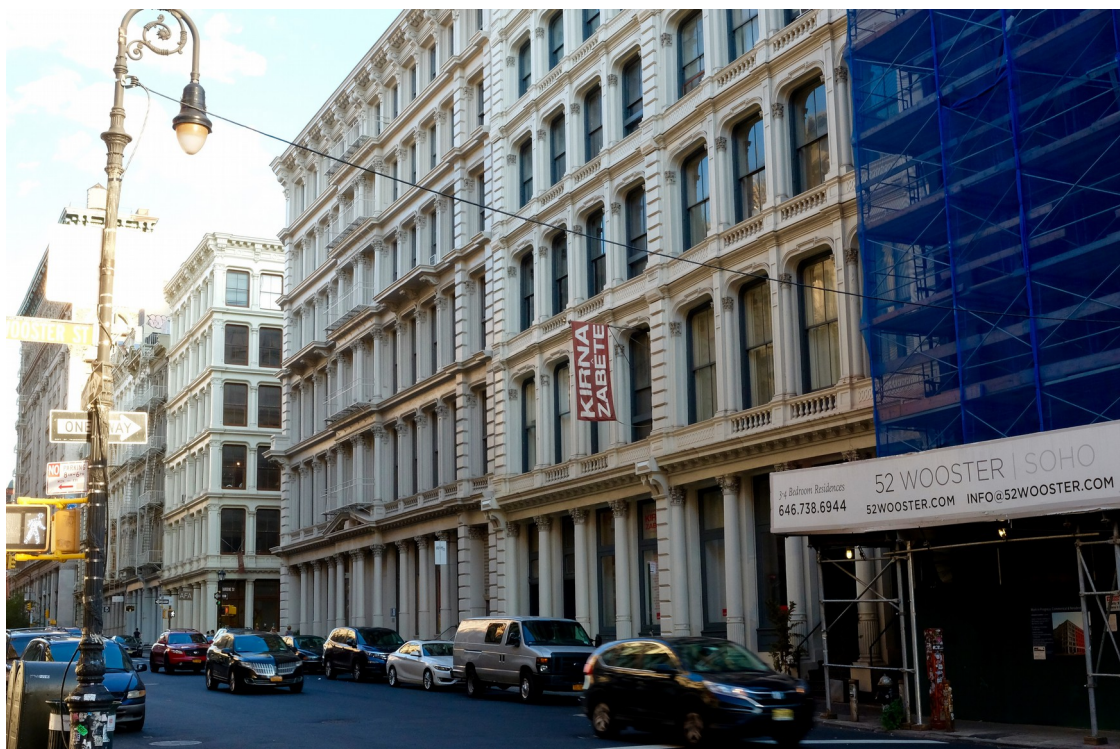
Figura 5.1: Edificios con fachadas de fundición en la calle Wooster Street en el barrio del SoHo, Nueva York. Fotografía del autor (2016).
