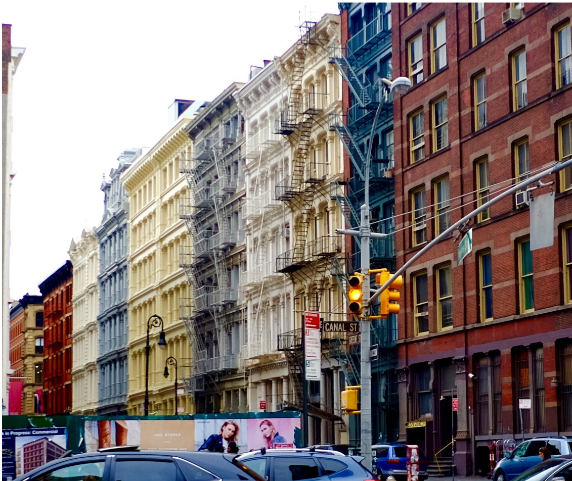
Figura 5.3.3: Vista de la Calle Greene Street con los característicos edificios de fundición. Fotografía del autor (2016)
