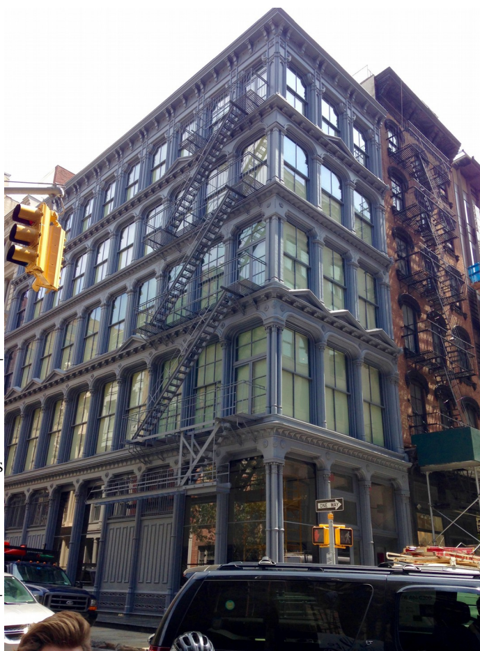
Figura 5.2.2: Edificio con fachada de fundición situado en Mercer Street, Nueva York. Fotografía del autor (2016)
