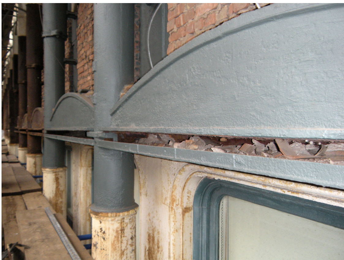
Figura 5.2.3: Edificio con fachadas de fundición en restauración situado en Broadway, Nueva York. Nótese las columnas y las vigas de fundición. Fuente: Marie Ennis (2010)
