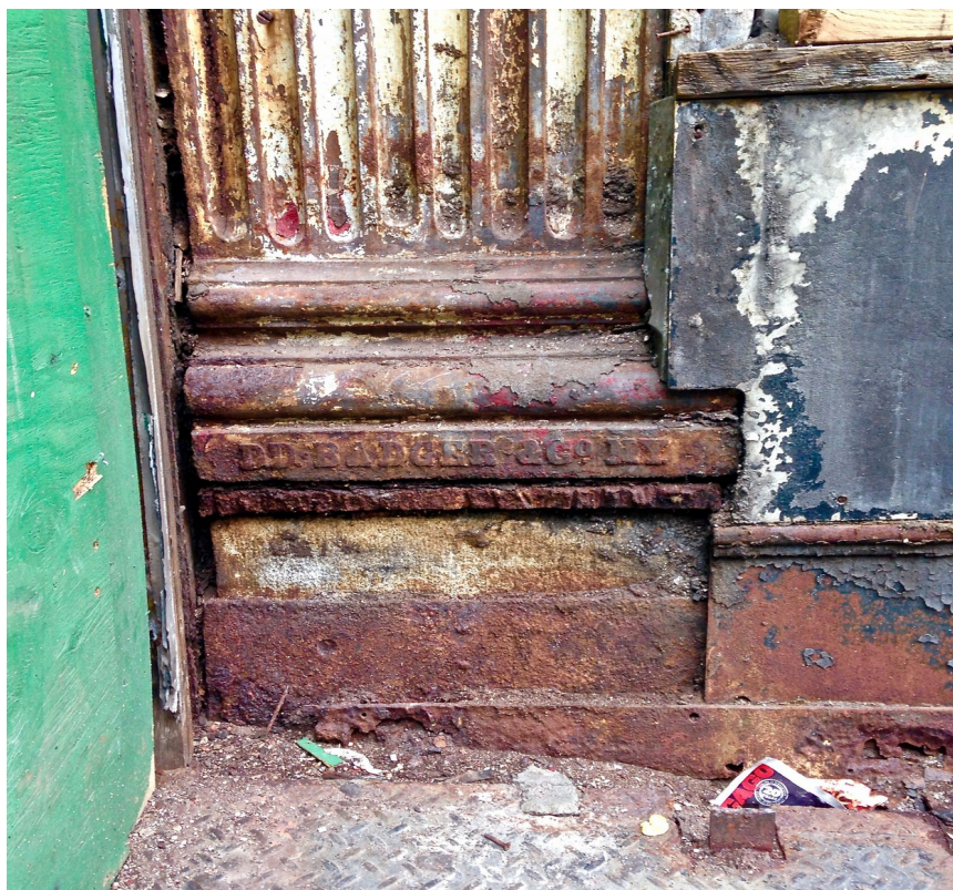
Figura 5.1.4: Base de una columna de fundición en el barrio del SoHo expuesta a raíz de trabajos de restauración. En la base se lee el nombre de la fundición que las fabricó, la “D.D. Badger”. Fotografía del autor (2015).
