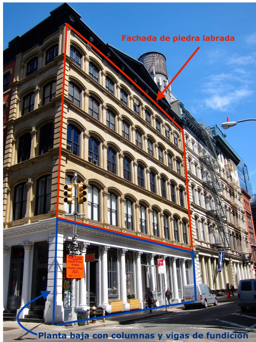
Figura 5.2.1: Edificio comercial (tienda) construido en 1867 en Greene Street, Nueva York. El edificio está resuelto con una fachada de piedra labrada en sus plantas altas y con escaparate en su planta baja realizado con columnas y vigas de fundición. Los posteriores edificios con fachadas de fundición trataban de imitar a este estilo de edificios con un coste menor. Fotografía del autor (2016)
