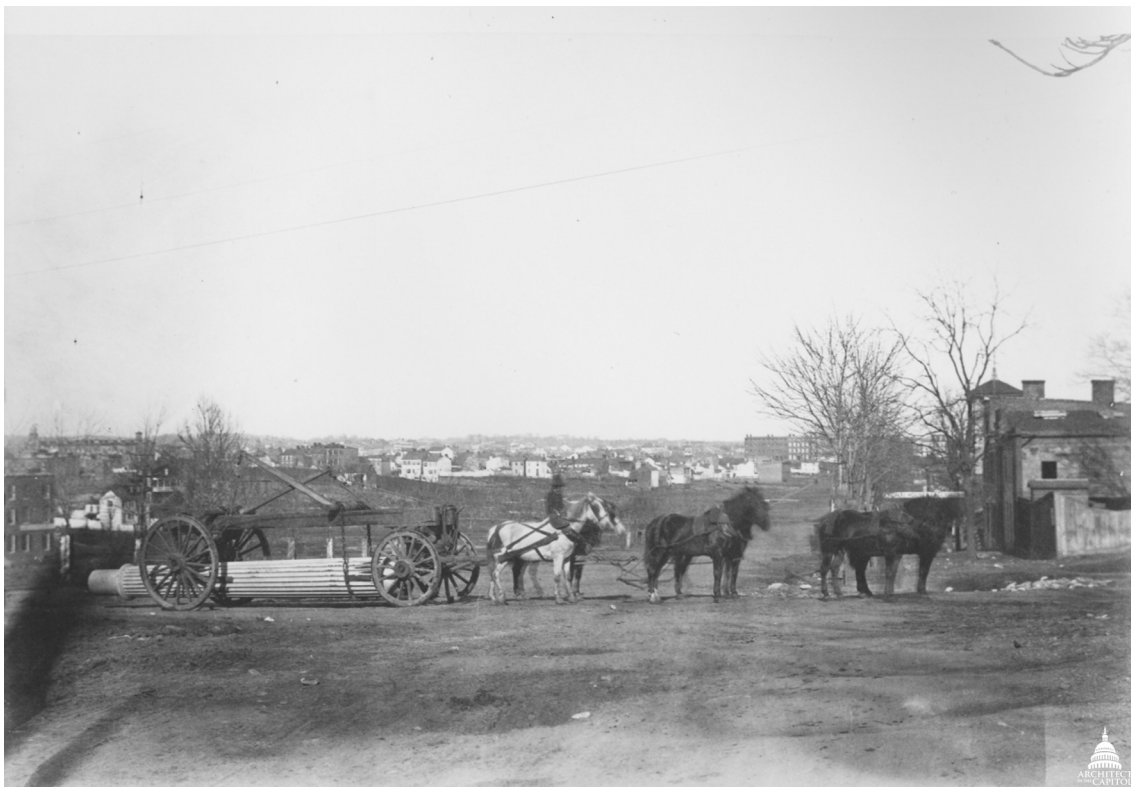
Figura 3.4.2: Carruaje transportando una de las columnas del Capitolio de Washington DC en 1857. Fuente Library of Congress
