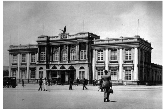
ILUSTRACIÓN 39_ ESTACIÓN DE LA SABANA, BOGOTÁ, 1930
