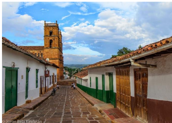
ILUSTRACIÓN 48_ VIVIENDAS EN TAPIA, BARICHARA- SANTANDER
