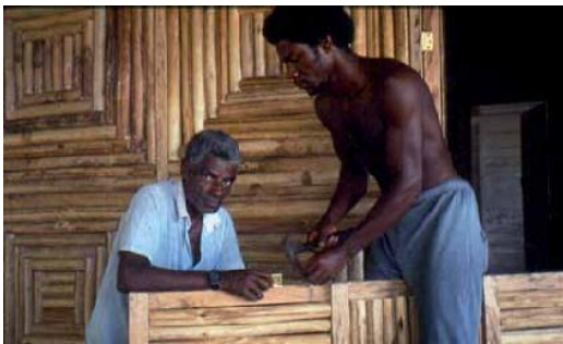
ILUSTRACIÓN 76_ CARPINTEROS ELABORANDO UNA PARED INTERIOR, HUINA
