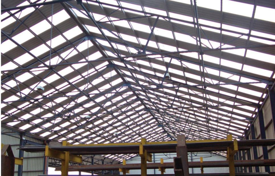
Figura 20. Ejemplo nave industrial con un sistema de iluminación empleando claraboyas.
