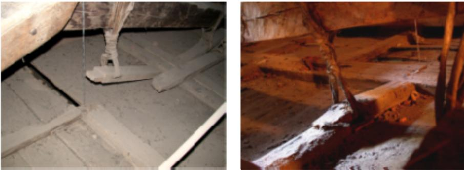
ILUSTRACIONES 3 y 4: Colapso estructural del Cielo raso barroco.
