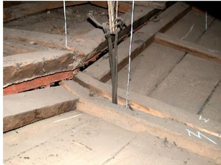
ILUSTRACIONES 31 y 32: Faldón sur del cielo raso. Detalle del desplome de módulos; vista desde el intradós y desde el extradós. Fotografía: Subía, L. (2004).
