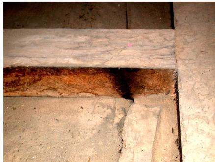
ILUSTRACIONES 37 y 38: Depósitos de hollín y polvo sobre los elementos decorativos; y marca dejada por los mismos compuestos, al pasar hacia el extradós. Fotografía: Subía, L. (2004).
