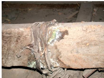
ILUSTRACIÓN 35: Avanzado estado de deterioro de la tablazón ubicada en los extremos bajos del faldón oeste del transepto norte. ILUSTRACIÓN 36: Presencia de organismos xilófagos (insectos y hongos) en los elementos estructurales y de sujeción del cielo raso.
