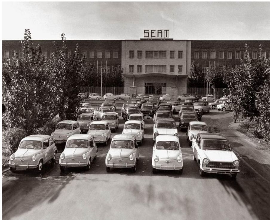
Fig.2.1 Fábrica de Seat situada en la Zona Franca de Barcelona. Ref. [1]
