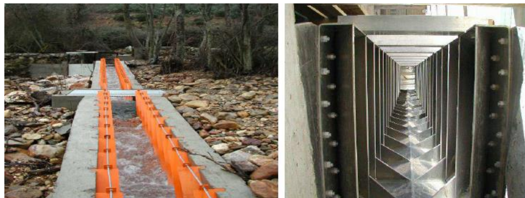
Ilustración 18: Ralentizadores tipo Denil y Alaska
