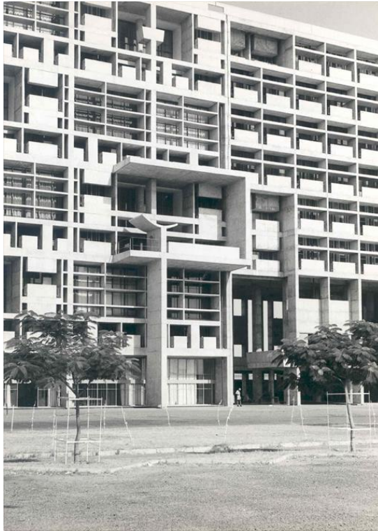
5. Imagen de la fachada del Secretariado de Chandigarh, donde se pueden observar los huecos que permitirían pasar el aire en toda la altura de la misma. Fuente: Fundación Le Corbusier FLC.
