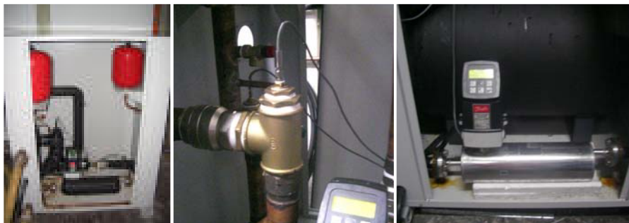
Figura 3.19 Detalles de la instalación del grupo hidráulico externo
