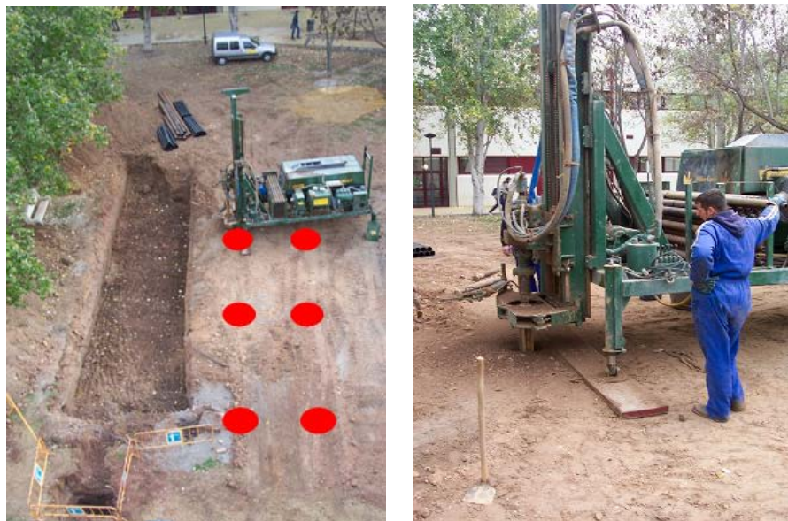
Figura 3.13 Ubicación y ejecución del intercambiador de calor vertical de la instalación GeoCool
