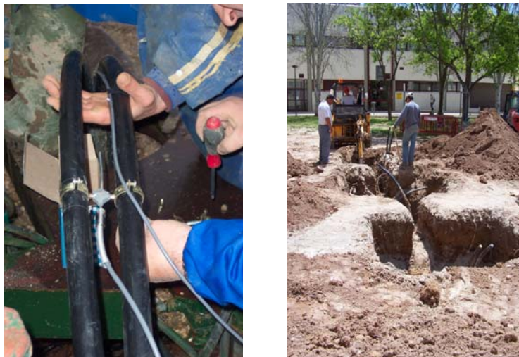
Figura 3.15 Instalación de las tuberías en U y ejecución de la zanja para el colector horizontal y las arquetas
