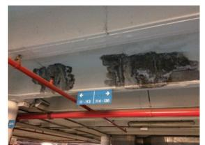
Detalles tipo de la subsanación de filtraciones y humedades en el complejo de L'Oceanogràfic. 2017. Fuente: Detalle propio. Martin Arcos, J. J.
