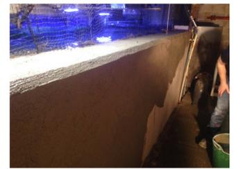
Detalle de terminación de la actividad de reparación de estructuras de hormigón armado. 2017. Fuente: Detalle propio. Martin Arcos, J. J.
