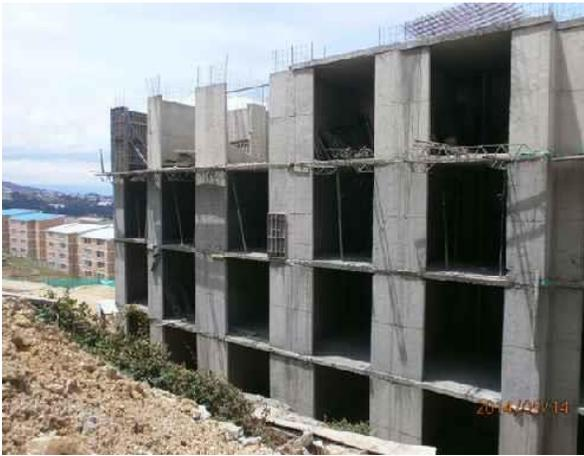
**Ilustración 7-7** Envoltura muros en hormigón.
