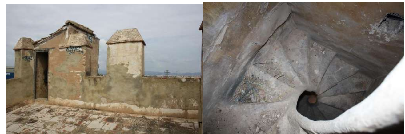
Fig. 40. Imagen de la cubierta transitable de la torre. Imagen de la escalera de caracol
