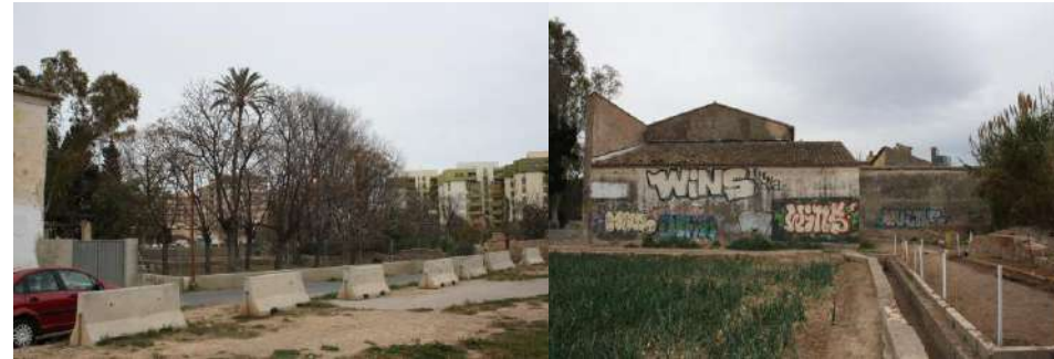
Fig. 29. Carretera Camí Vell de Burjasot / Fachada Norte con la huerta
