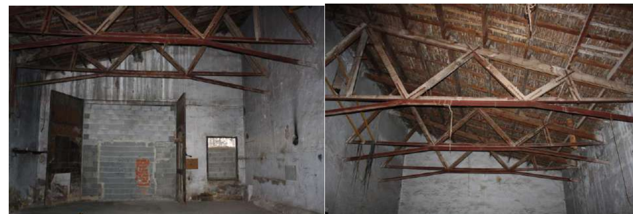
Fig. 35. Imagen de la nave lateral y la cubierta de la misma. Fuente: Propia
