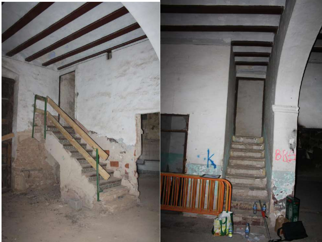
Fig. 50. Escalera del acceso principal y escalera del acceso secundario. Fuente: Propia
