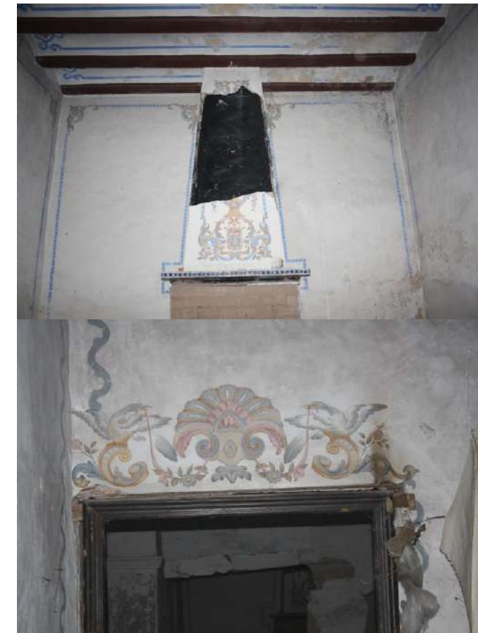
Fig. 54. Imagen de la habitación con chimenea. Otra habitación de planta baja. Fuente: Propia
