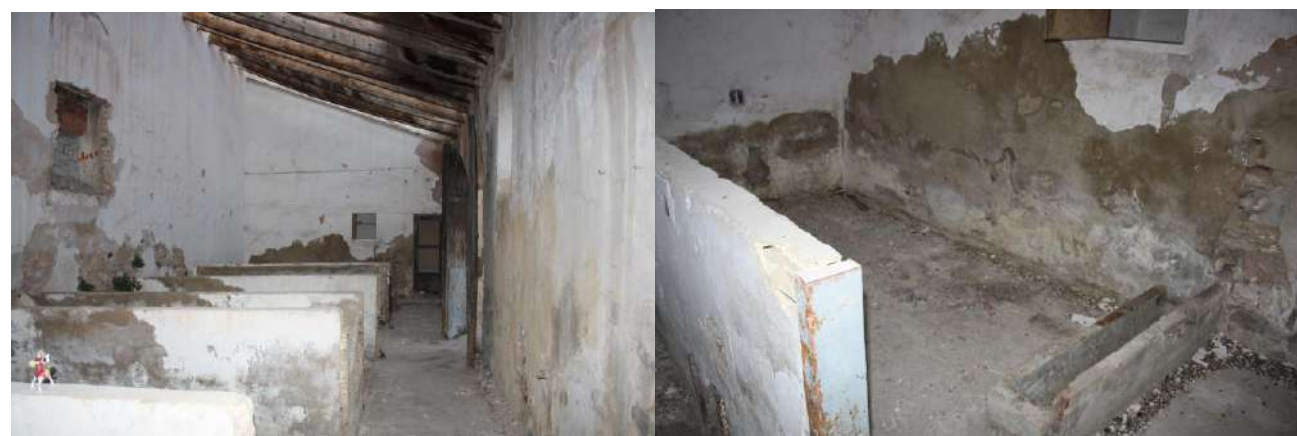
Fig. 34. Imagen de las cuadras 2. Imagen del tabique bajo de separación y bebedero. Fuente: Propia
