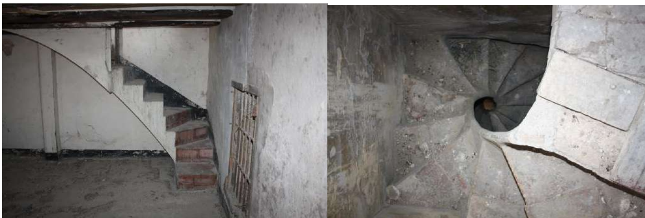
Fig. 51. Escalera de acceso a planta primera desde las cuadras y escalera de ascensión a la torre. Fuente: Propia
