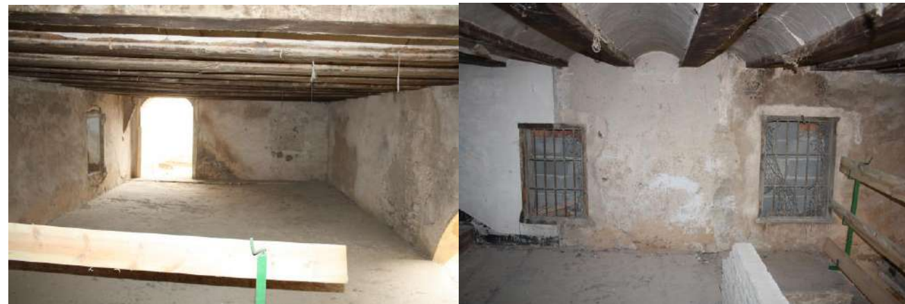
Fig. 37. Imágenes de la entreplanta. Fuente: Propia
