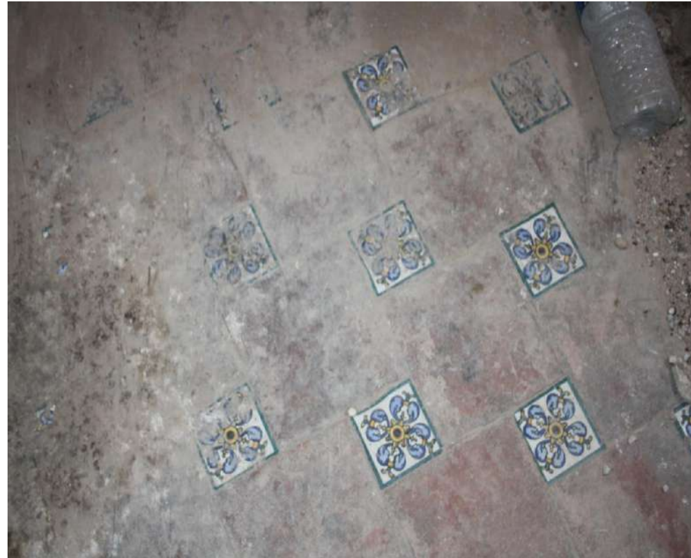
Fig. 55. Pavimento la habitación en acceso secundario y pavimento de las escaleras. Fuente: Propia
