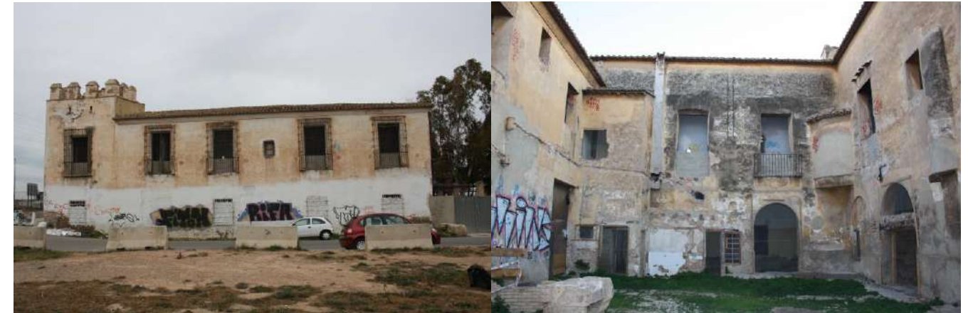
Fig. 41. Fachada Sur y fachadas interiores. Fuente: Propia
