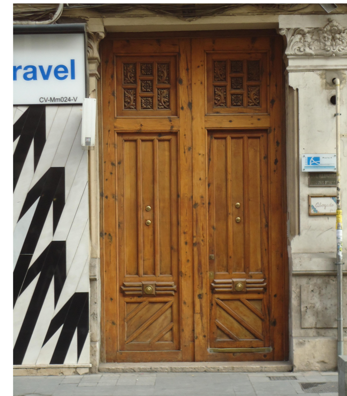
Acceso viviendas nº35. Arch. propio.
