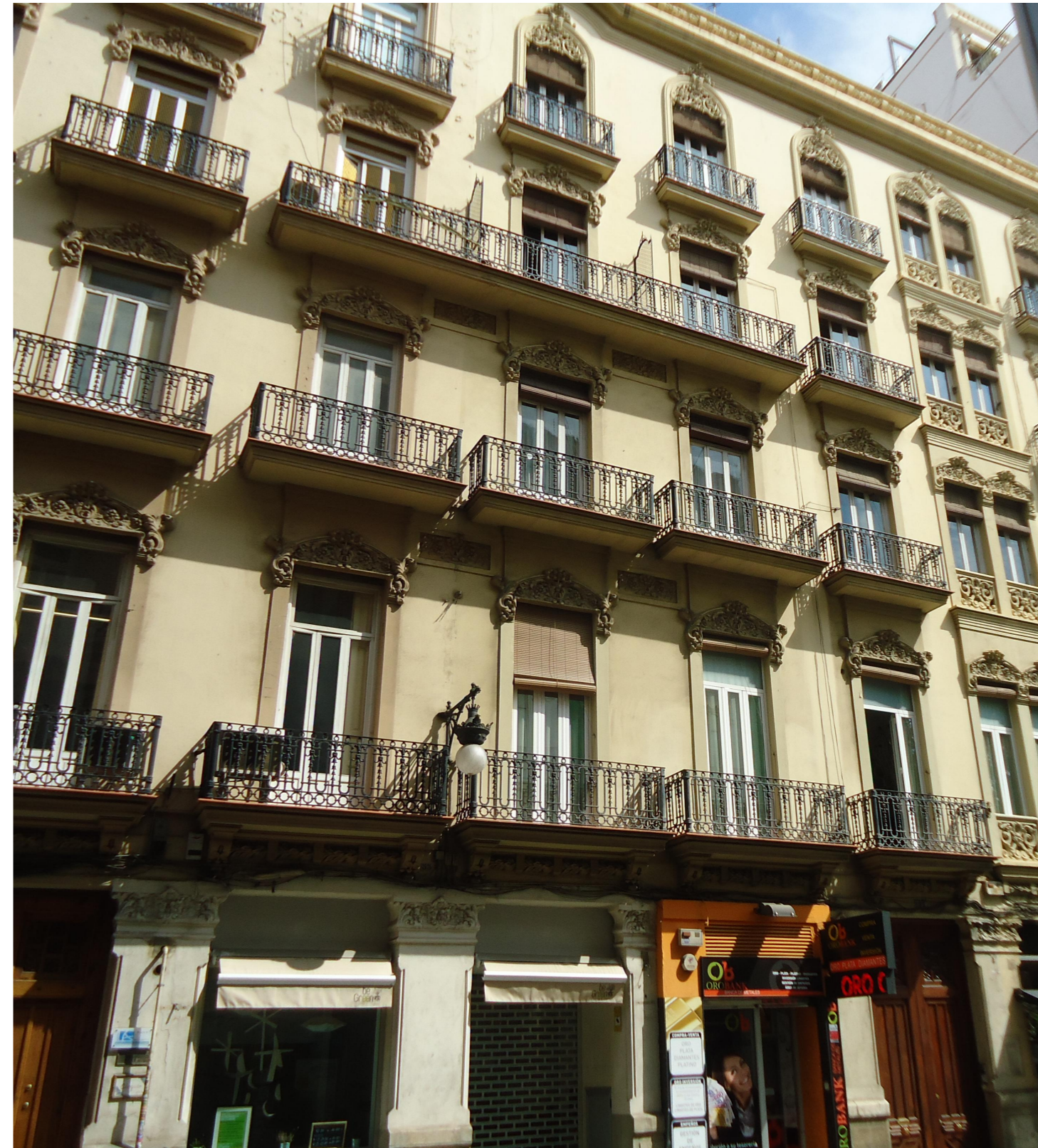
Fachada edificio 35 - 37 calle de la Paz. Arch. propio.
