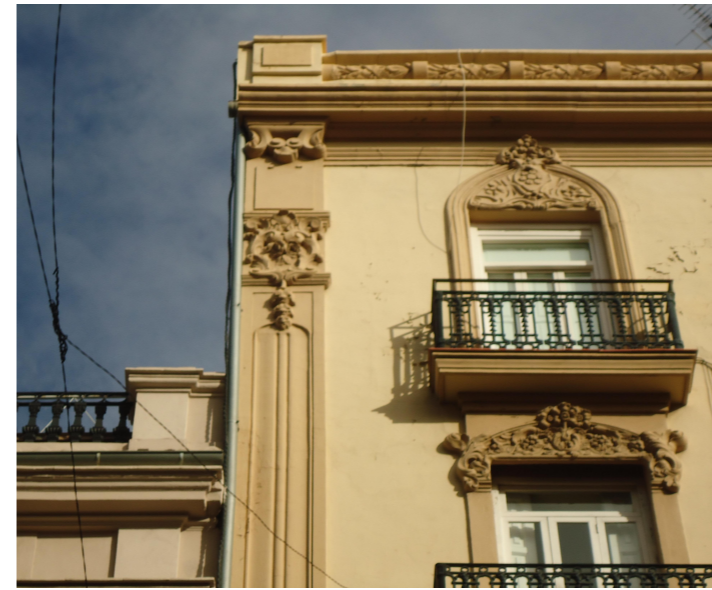
Vista molduras laterales y cornisa. Archivo propio.
