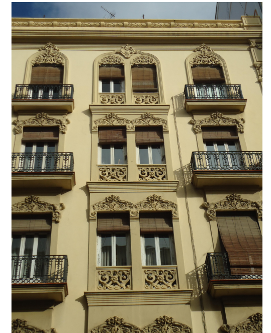
Ritmo de los huecos de fachada. Arch. propio
