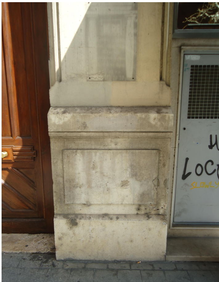
Vista del zócalo en planta baja. Archivo propio.
