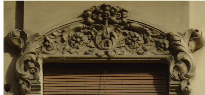
Ornamentación existente en la parte superior de las ventanas. Archivo propio.
