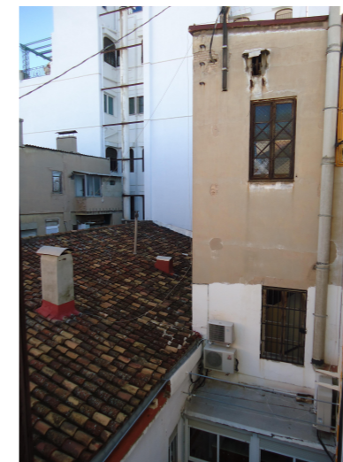
Vista carpintería recayente a patio de luces. Archivo Propio.
