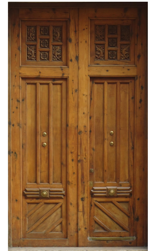
Vista frontal de puerta de acceso principal. Archivo propio.
