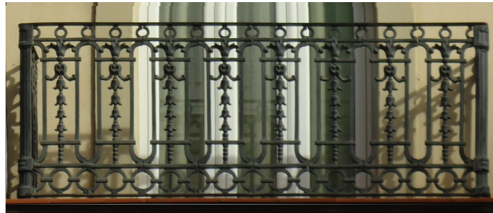
Balcón de hierro de forja situado en planta segunda. Archivo propio.
