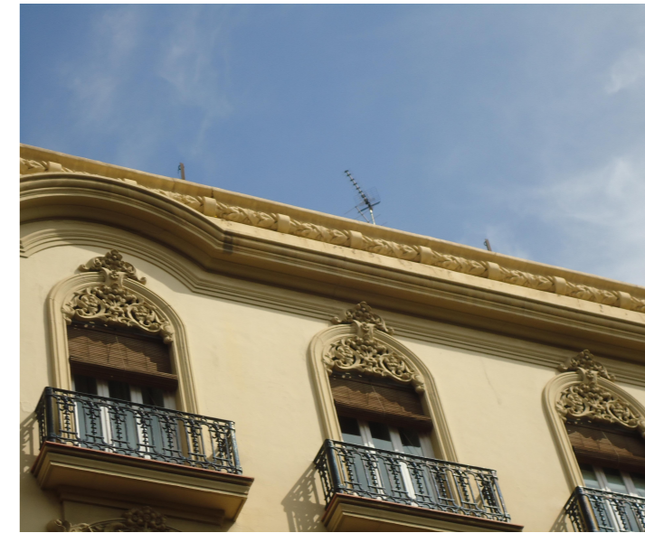
Vista molduras de la cornisa. Archivo propio.
