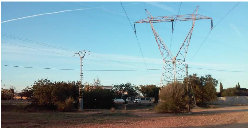
Imagen 1 – Instalación eléctrica en parcela
