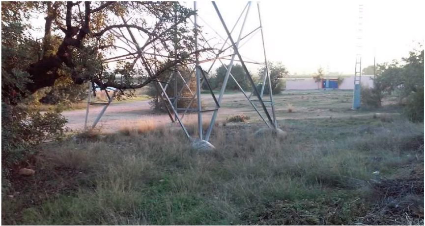
Imagen 8 – Base torre AT
