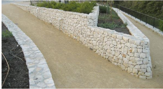
Ilustración 10 – muros de mampostería
