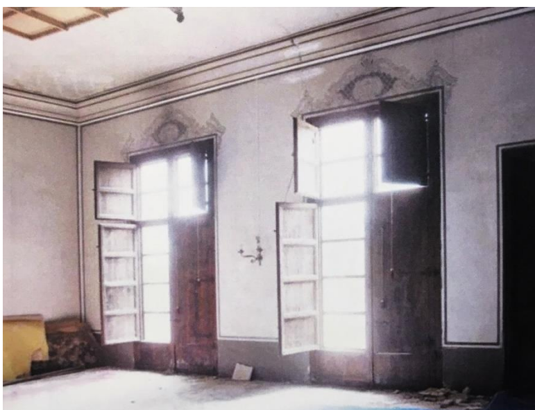
Ilustración 36. Sala de la Fama. Fuente: Fernando Aranda Navarro
