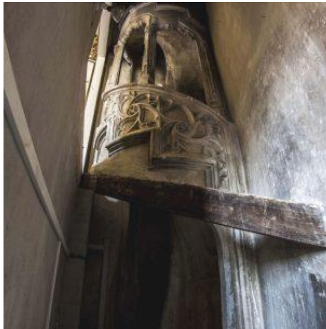
Ilustración 32. Escalera gótica de caracol antes de ser rehabilitada. Fuente: http://www.valenciahistorica.es/colegio-del-arte-mayor-de-la-seda/
