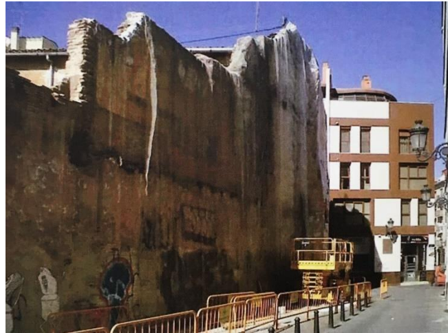
Ilustración 33. Fachada Este. Fuente: Fernando Aranda Navarro
