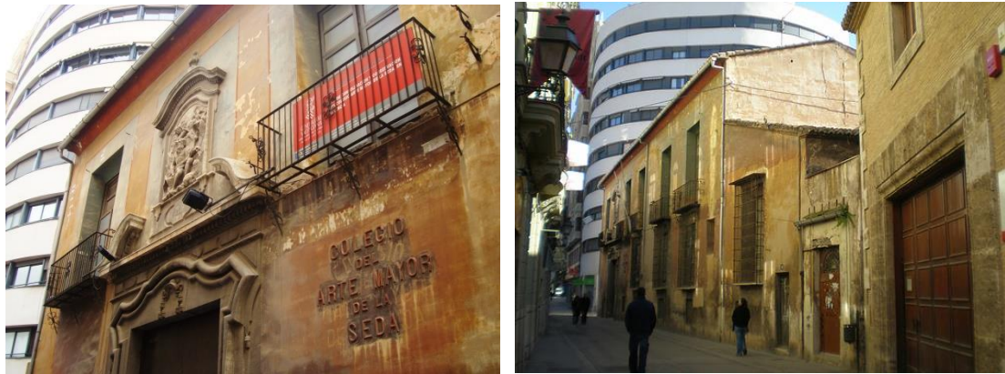
Ilustración 16. Obras de restauración. Fuente: http://valencianews.es/tendencias/inicio-de-la-restauracion-del-colegio-del-arte-mayor-de-la-seda/
