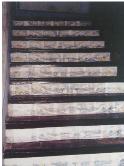
Ilustración 20. Protección de las contrahuellas en escalera. Fuente: NAVARRO F, CANET GUARDIOLA, R, VIZCAINO LEÓN, D; MONRAVAL M. En defensa de la Arquitectura del colegio Mayor del Arte de la Seda de Valencia. Valencia 2003. Ed: Associació d'Àmics de Cristófor Aguado. Pág.111.
