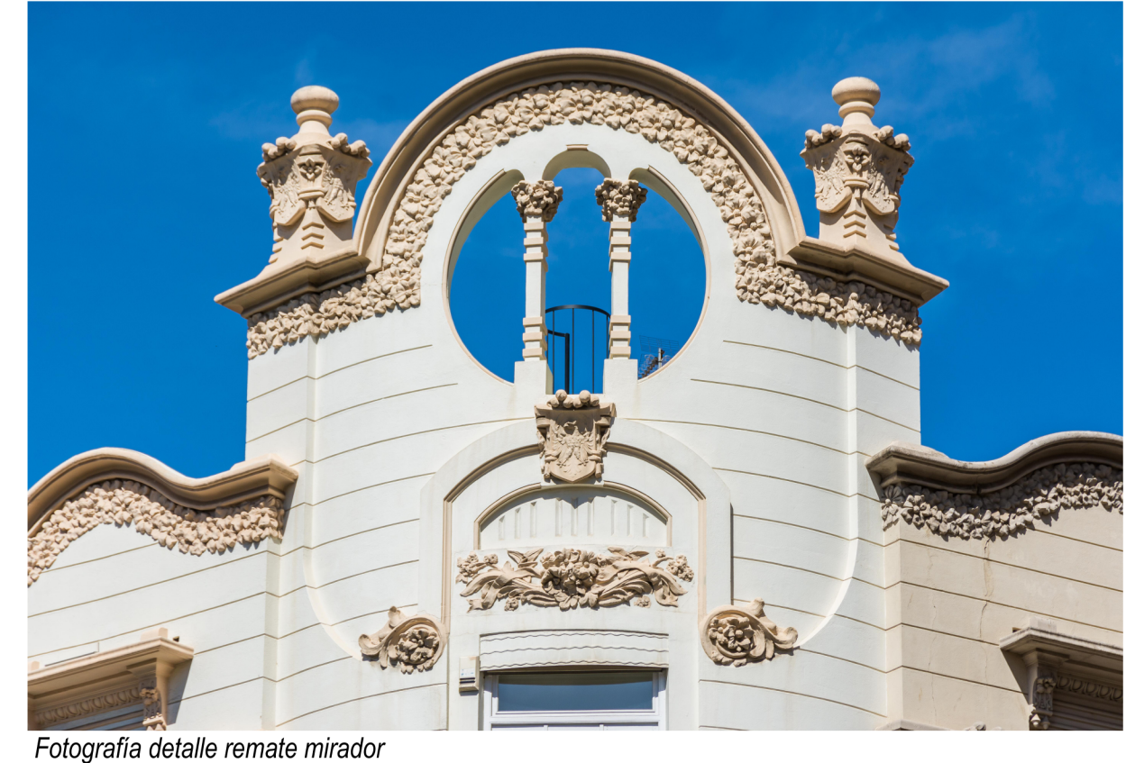
Fotografía detalle remate mirador
