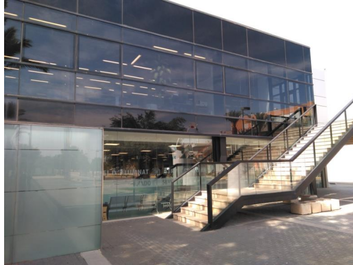
Ilustración 22. Muro cortina de la fachada principal del edificio de alumnado
