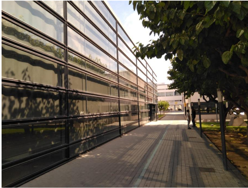
Ilustración 8. Detalle del muro cortina de la fachada este del edificio del paraninfo
