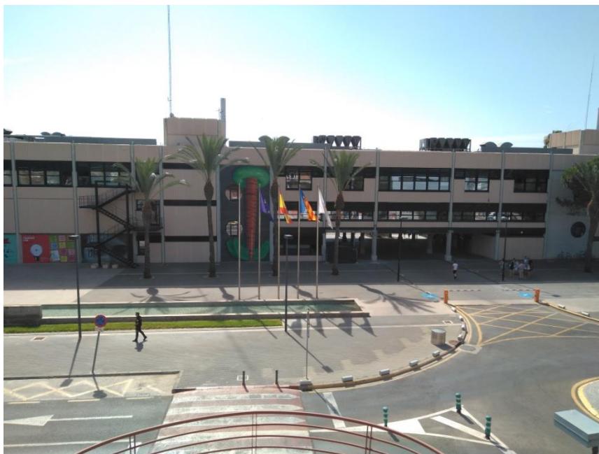
Ilustración 10. Fachada oeste del edificio de rectorado
