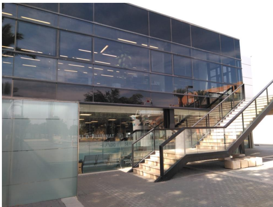
Ilustración 6. Detalle del muro cortina del edificio de alumnado
