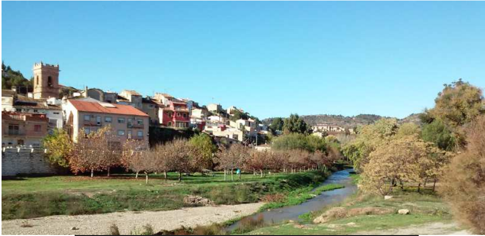
“Sección 10”, desde margen izquierdo del Tuéjar, hacia paseo ribereño y defensa fluvial
