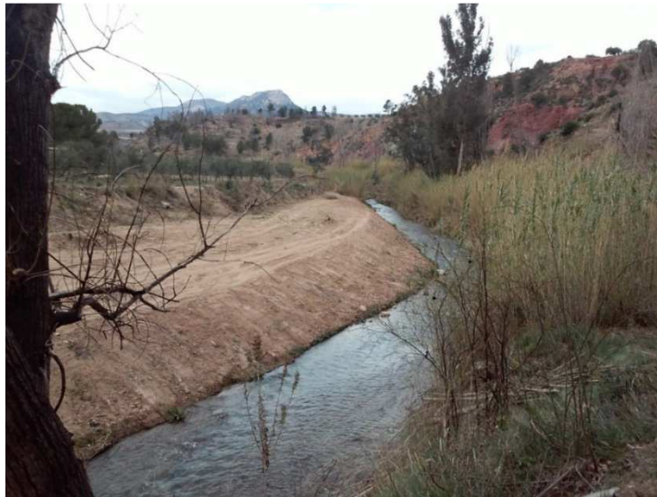
Vista del margen derecho de la "Sección 850" aguas arriba
