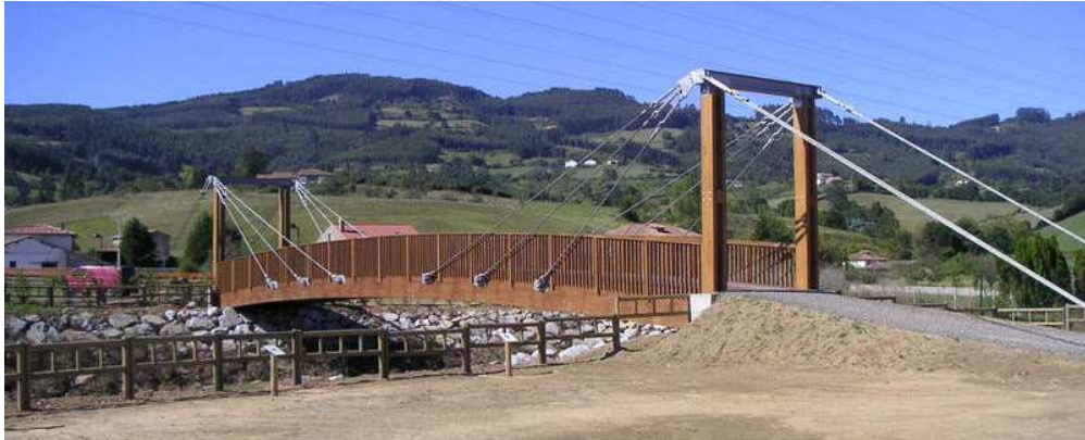
Puente atirantado de 34 metros (Villaviciosa). Fuente: Media Madera
