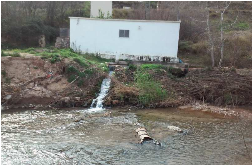
“Sección 410”, desde margen izquierdo del Tuéjar hacia margen derecho; localización EDAR
