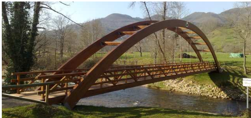
Puente en arco triarticulado con tablero suspendido (Cangas de Onís)
