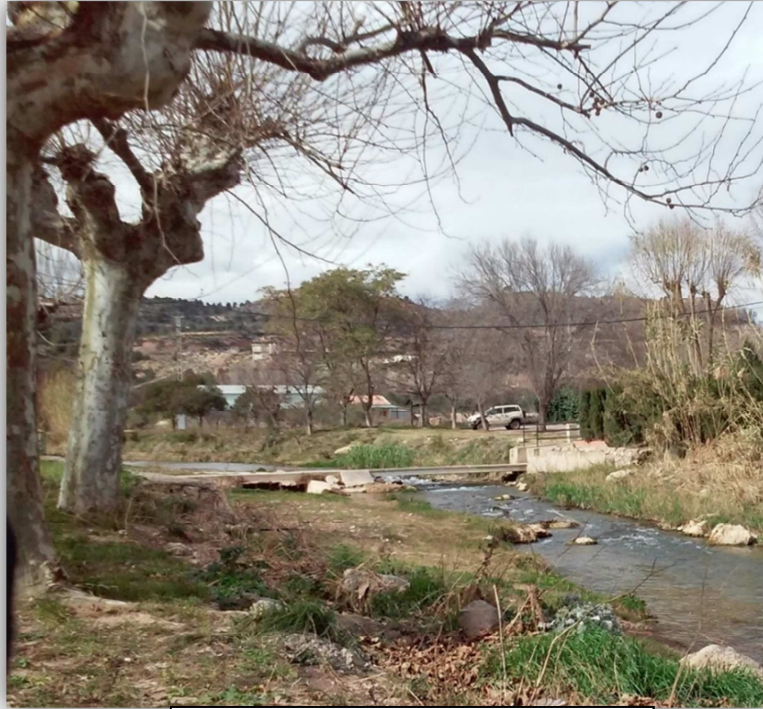
Vista pasarela hormigón desde aguas abajo, margen derecho
