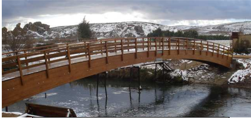
Puente en arco de inercia variable biarticulado (Aguilar del Campoo)
