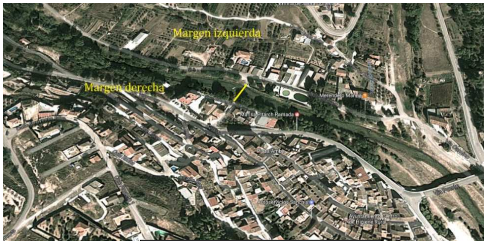
Vista aérea zona de actuación
