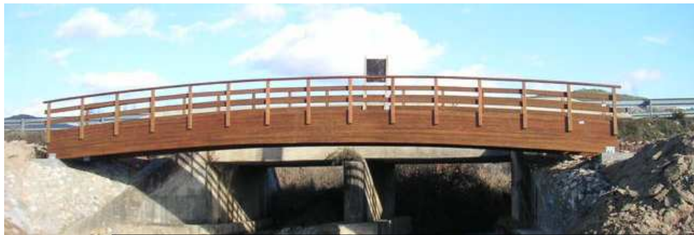
Puente recto con contraflecha. Fuente: Media Madera
