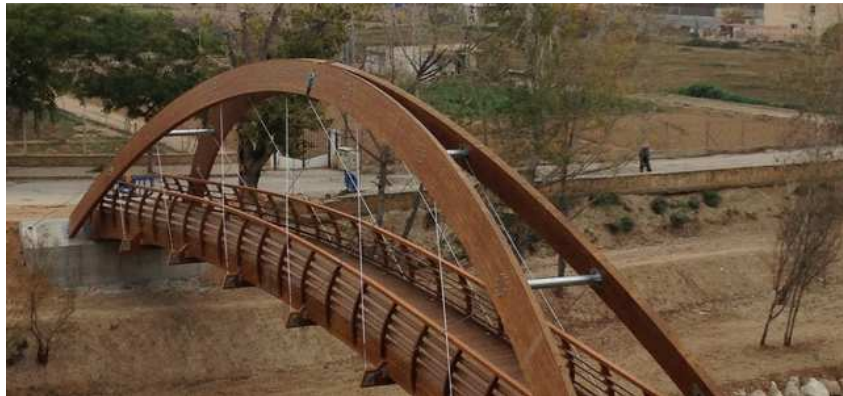
Puente con arcos inclinados y tablero de inercia variable (Cieza)
