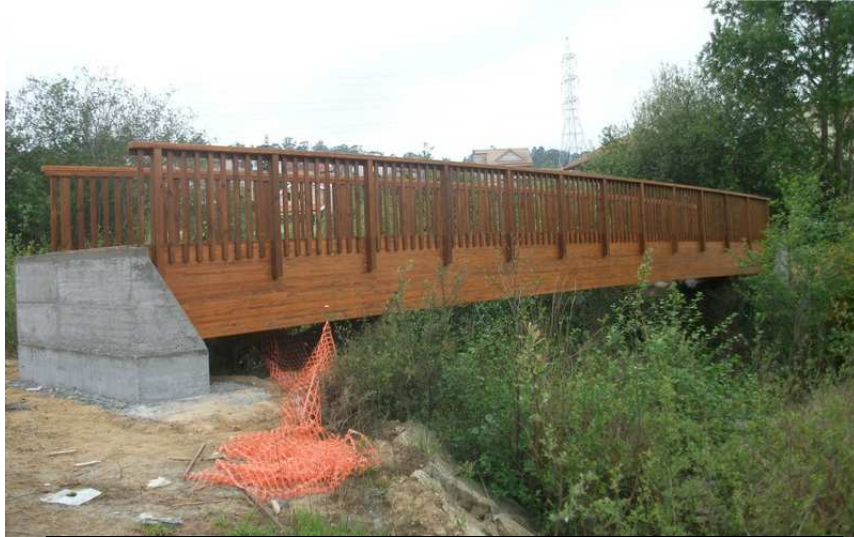
Puente recto de 20 metros de longitud (Vigo. Fuente: MediaMadera
