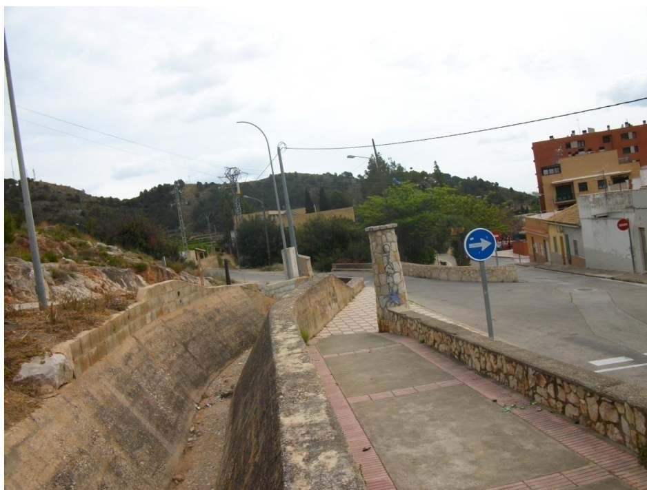
FIGURA 26: Barranco del Mur (Tavernes de la Valldigna).
