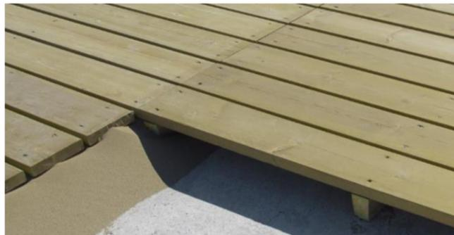
Figura 29. Ejemplo de instalación de listones y rastreles. Fuente: Catálogo MADERA CUNIL S.A.
