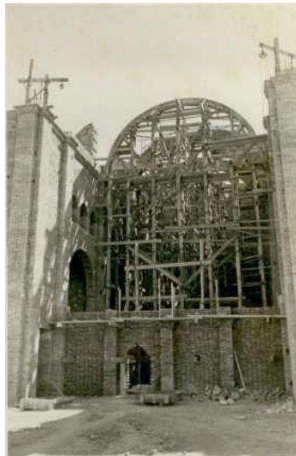
Imagen 16: Construcción de la nave central. Vista desde el presbiterio. (31/03/1945). Fotografía archivo diocesano de Valencia
