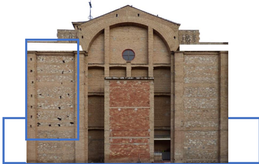
Imagen 24. Rectificación estado actual fachada trasera 2017. Fuente: Fotografía propia.
