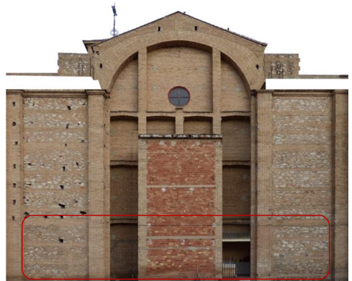
Imagen 34. Fachada trasera rectificada.
