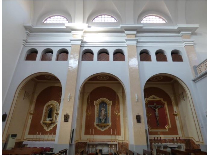
Imagen 21. Interior de la iglesia, zona capillas laterales.2017 Fuente: fotografía propia.
