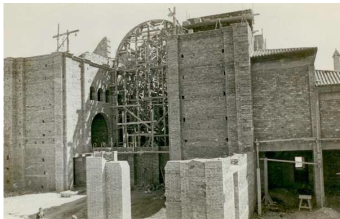
Imagen 18: Construcción del crucero y la nave central. (31/3/1945). Fotografía archivo diocesano de Valencia
