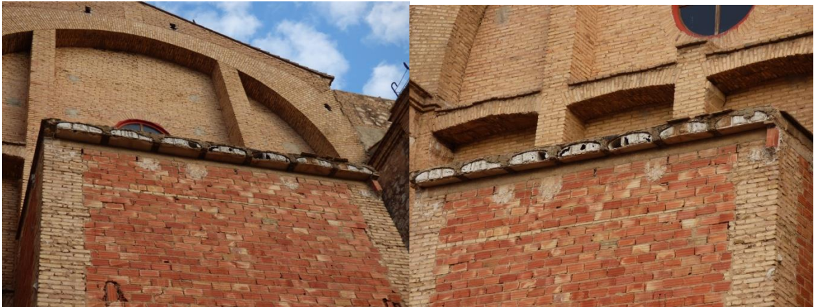
Imagen 43-44. Zona cubierta altar principal Fuente: fotografías propias.
