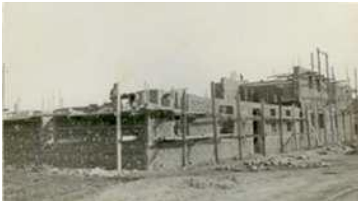
Imagen 7: Construcción de la fachada. Vista Suroeste de la Iglesia. (1/12/1944). Fotografía archivo diocesano de Valencia
