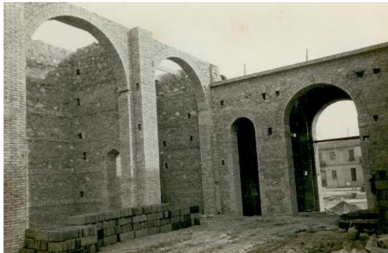
Imagen 10: Construcción de la nave central (1/12/1944). Fotografía archivo diocesano de Valencia
