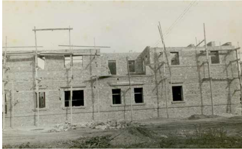
Imagen 9: Construcción de la fachada. Vista desde la calle Abadía. (1/12/1944). Fotografía archivo diocesano de Valencia
