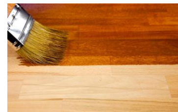
Ilustración 55: Barnizado de madera
