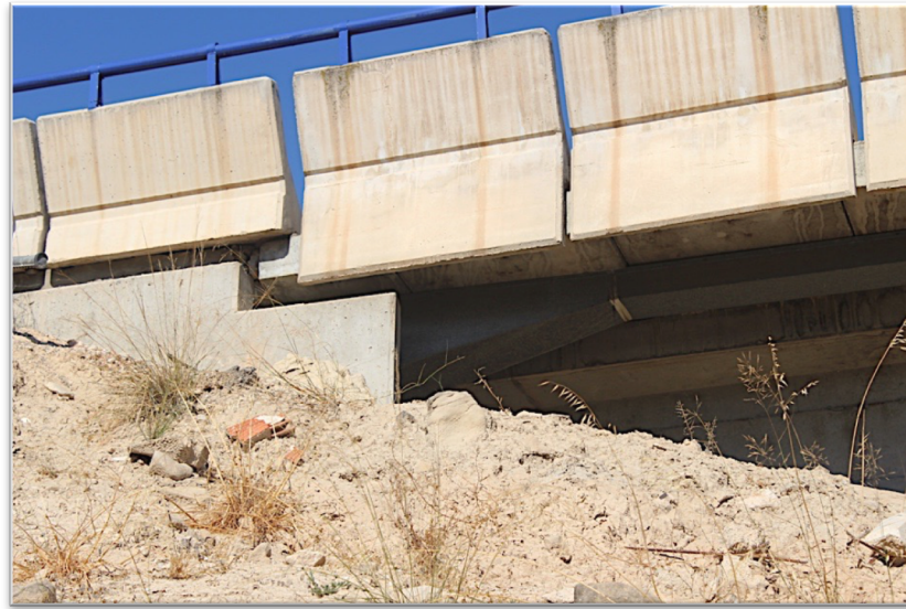
Figura 6. Drenaje de la estructura. Fuente: propia.
