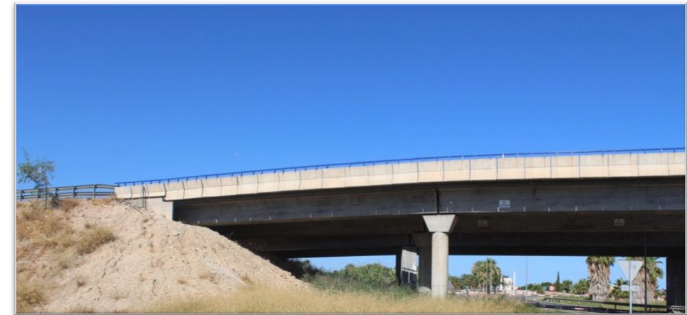
Figura 3. Detalle del estribo 1. Fuente: propia.
