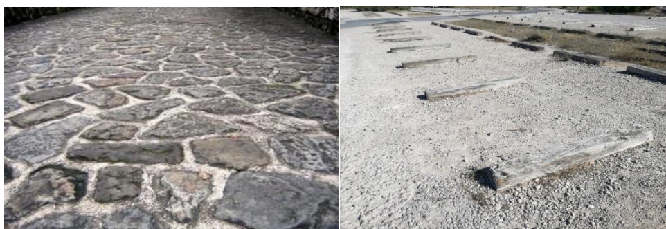
Figura 12 & 13. Aspecto orientativo del pavimento y aparcamiento. (Lugar: Playa de El Saler. Fotografía: Juan Miguel Giner Valero)
