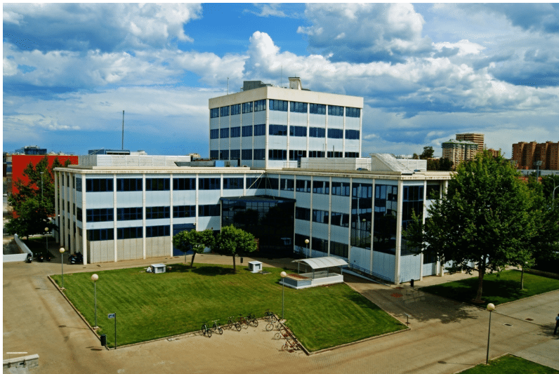
Figura 1.1: Edificio del Centro de Motores Térmicos - CMT
