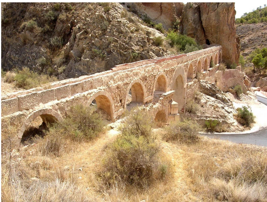
Fig. 9. Acueducto de Els Pontets. En primer término, la plataforma del molino
