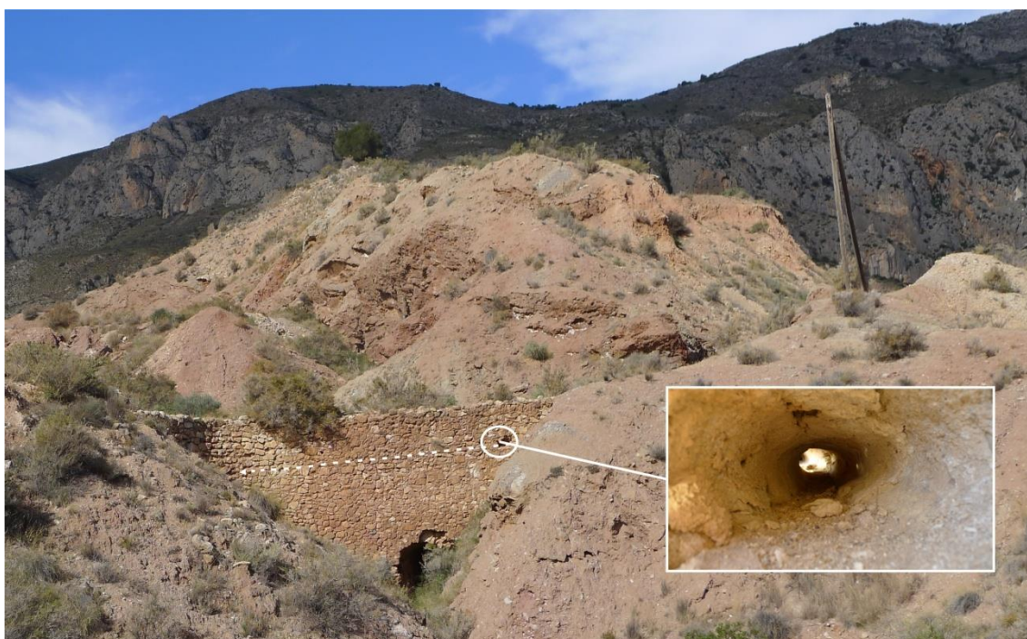
Fig. 13. Puente de La Terrera con indicaciones y detalle de la galería de caños.
