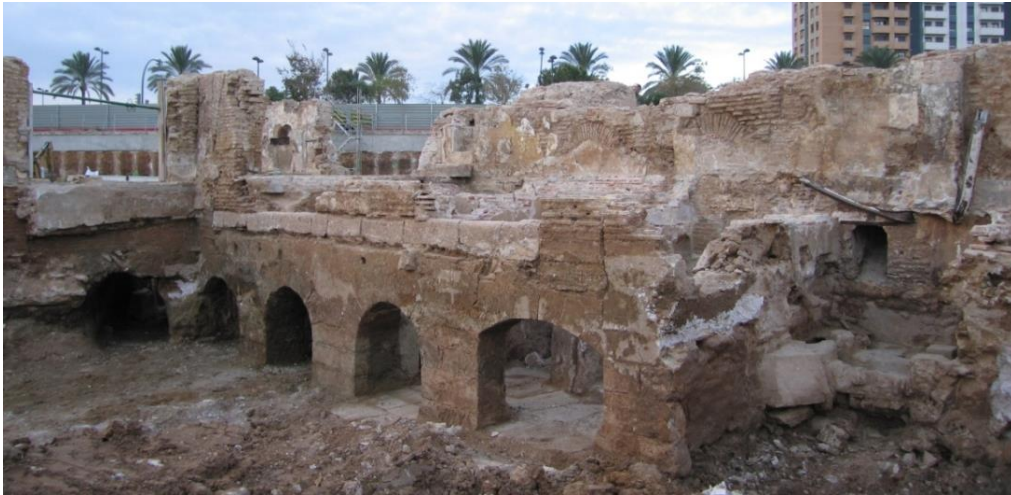
Fig. 16. Arcos de sillería de la salida del agua de las cárcavas. S. XIV.
