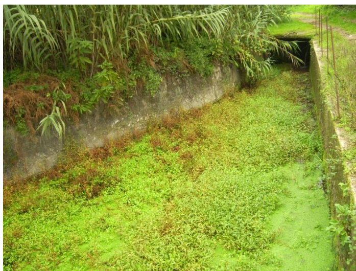
Fig. 6. Presa modificada enormemente, con muros actuales de hormigón y una parte de la misma soterrada bajo el camino lindante.
