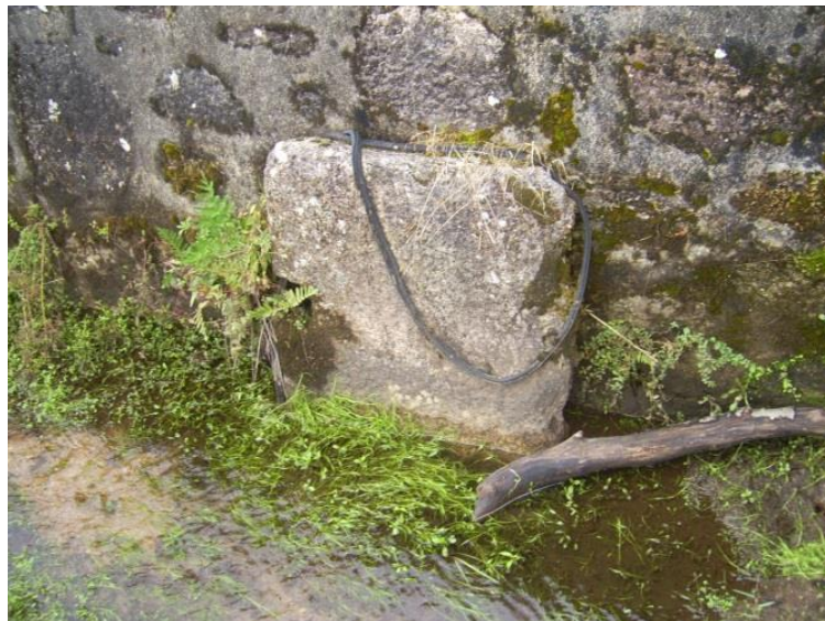
Fig. 3. Pedra de buceiro de grandes dimensiones, actualmente en desuso, apoyada en uno de las paredes de una presa. La sustitución del mecanismo tradicional del buceiro por mecanismos de apertura y cierre modernos han provocado la inutilización de estas piedras labradas, provocando su progresivo abandono y destrucción.
