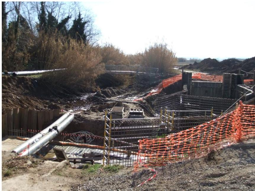
**Fig. 5.** Construcción de la nueva conducción para los riegos, a la derecha de la acequia histórica del Molí de Pals, en el punto de derivación de sus caudales respecto al propio río Ter (arbolado en la izquierda de la imagen). Mientras las obras se ejecutaban, unos tubos provisionales permitían que el agua continuara discurriendo por la acequia histórica a cielo abierto<sup>6</sup>.
