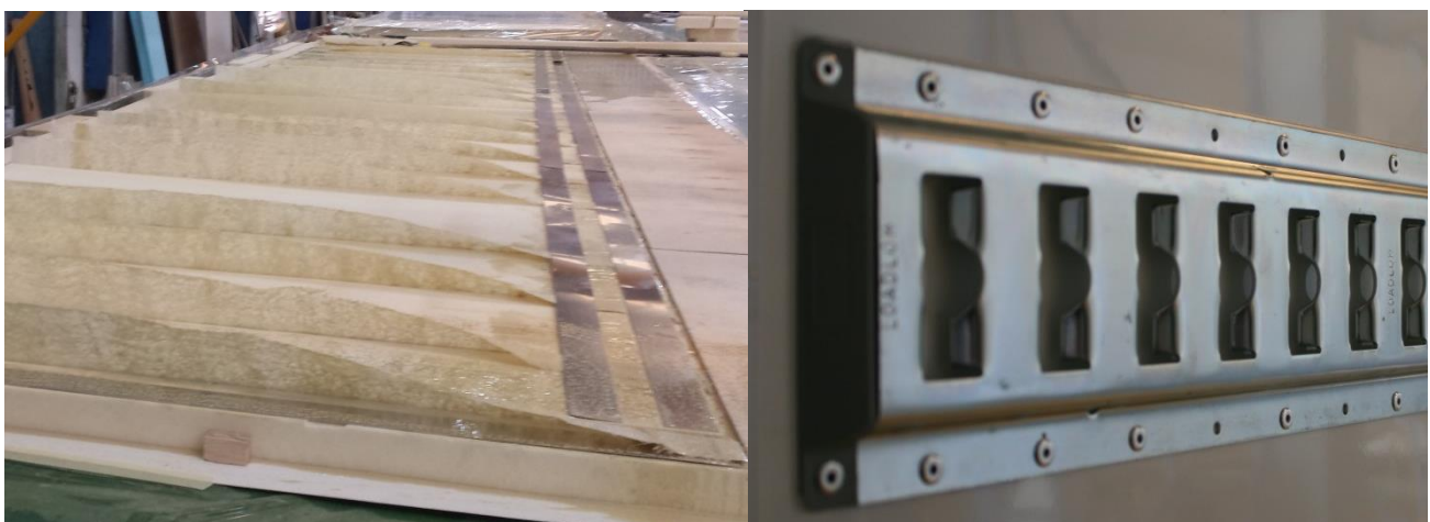
Imagen 30. Refuerzos de aluminio en el panel y banda de amarre colocada.
