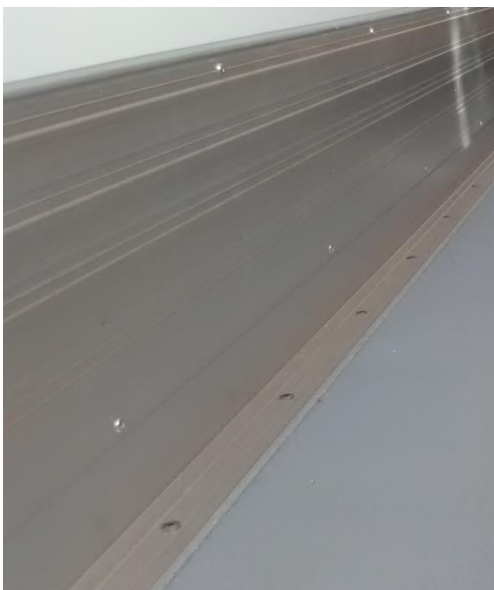
Imagen 33. Detalle del zócalo de 150mm y tipo de suelo.
