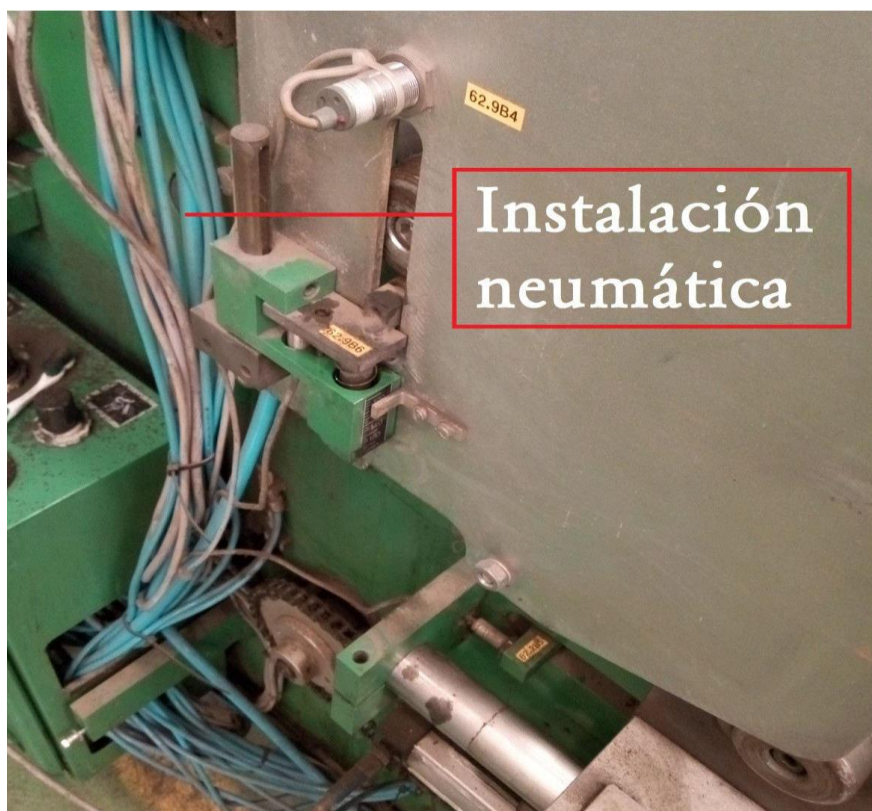
Fotografía 24. "Instalación neumática. Revisión de posibles fugas"
