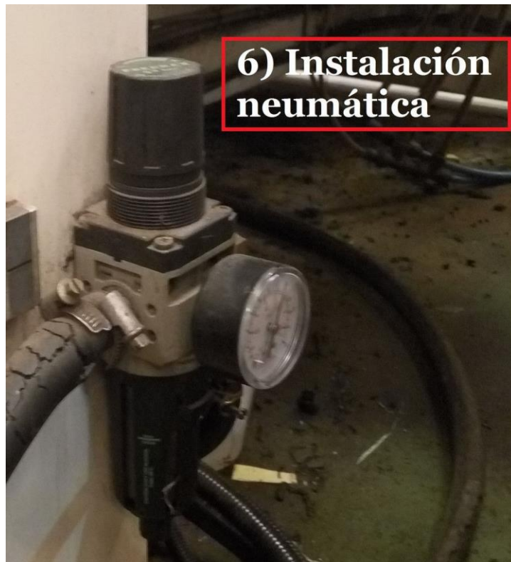
Figura 3.7 – Instalación neumática
