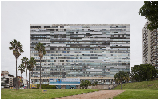
Figura 61: Edificio Panamericano. Arq. Sichero (1964). Pocitos. Montevideo. Fuente: recuperado de www.flickr.com
