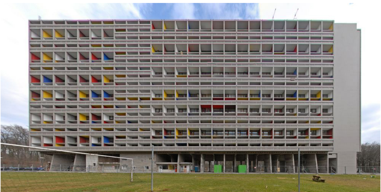
Figura 48: Edificio diseñado por el arquitecto Le Corbusier (1956). Fuente: recuperado de http://www.antoniohernandez.es/Arte/
