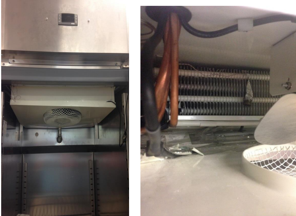
Figura 20. Izquierda: Exterior del Evaporador del arcón. Derecha: Interior del Evaporador
