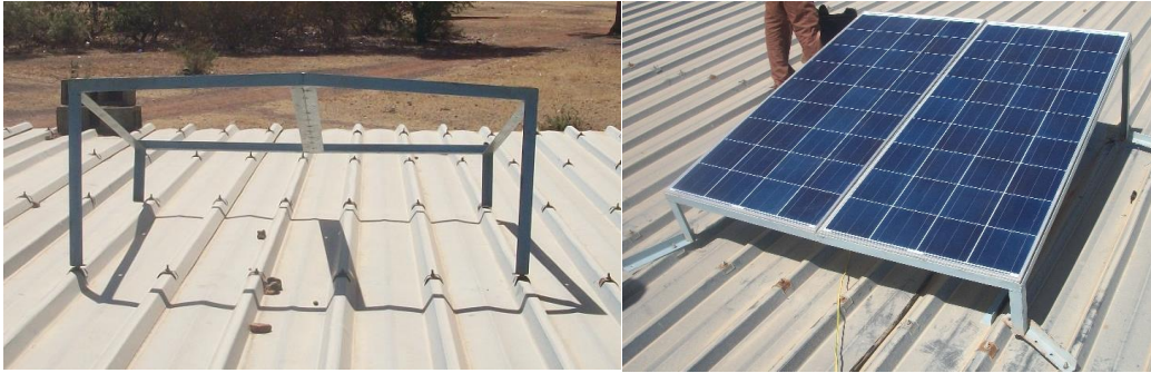
Figura 36. Estructura de soporte de los módulos. Fuente: MÁRQUEZ. M.N.
