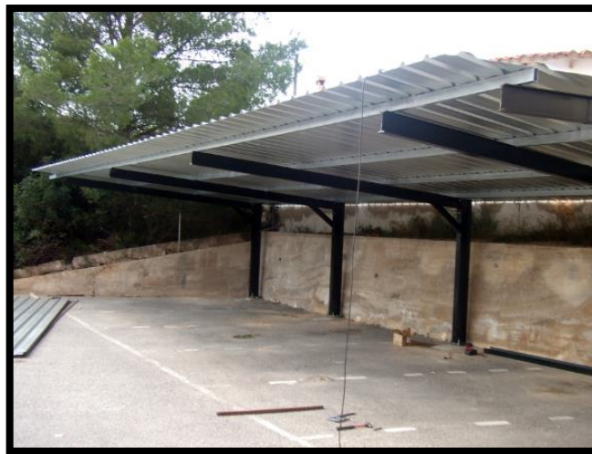
Ilustración 3: Detalle pórtico cubierta parking
