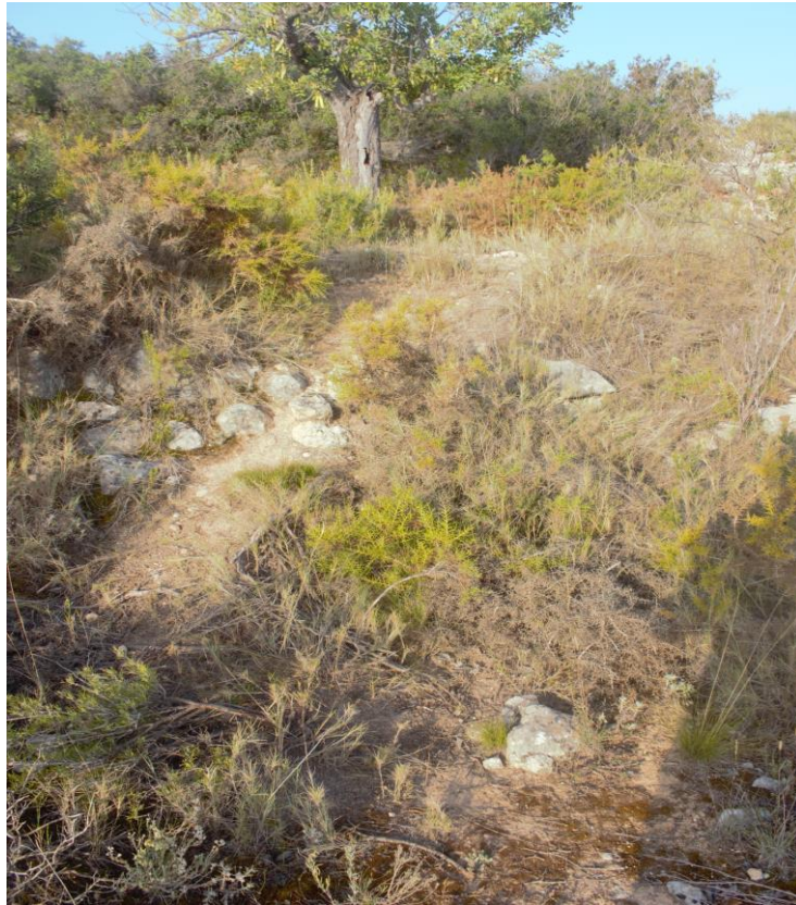
Figura 17: Tramo del camino 9033 estrechado por la vegetación
