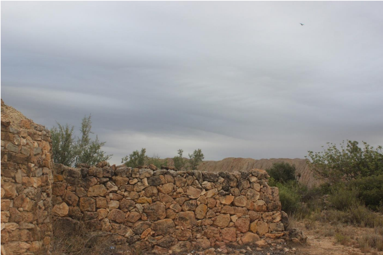
Figura 7: Muro del refugio de la Penyarroya
