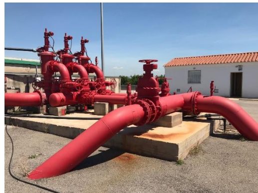
Figura 9. Distribución hacia 2 zonas de la red.
