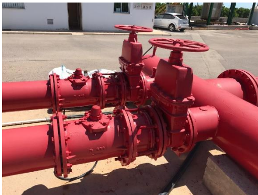
Figura 8. Ubicación de los contadores tras los filtros.
