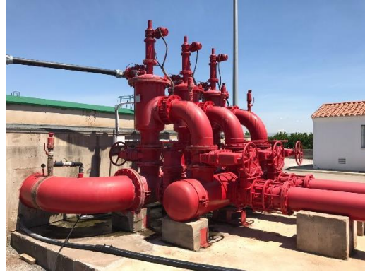
Figura 7. Ubicación de 3 filtros en la impulsión.
