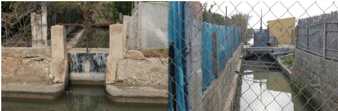
Ilustración 4: Compuertas que regulan el volumen de agua desde la acequia madre desde la EDAR Goleta a la acequia de Ripoll
