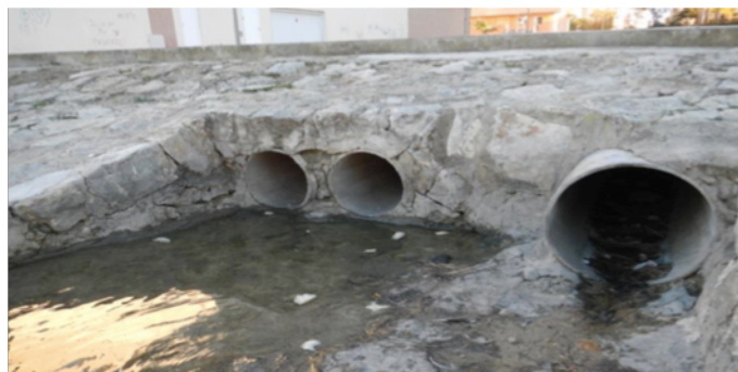
Ilustración 6: Entrada de alcantarillado pluvial al lago
