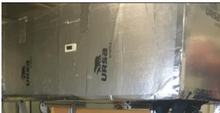
Figura 4.8. Cámara frigorífica del equipo docente.
