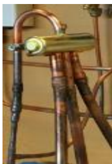
Figura 4.11. Válvula de 4 vías modelo SHF-19002/SHF.
