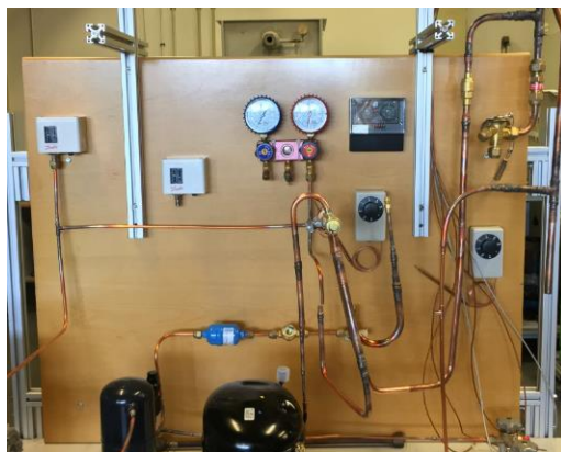
Figura 3.11. Instalación de la línea de desescarche y válvula de expansión.
