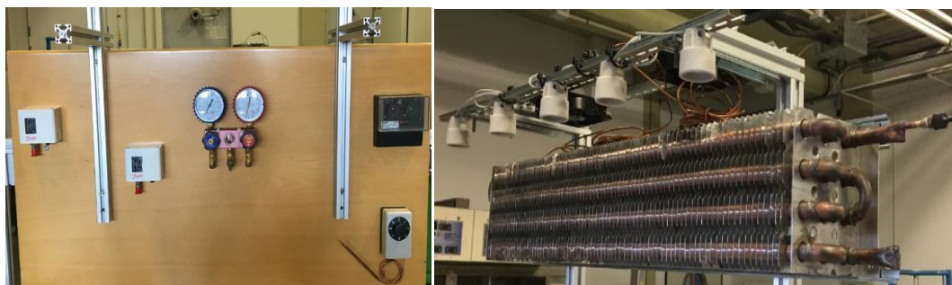
Figura 3.9. Fijación de sensores e instalación interna de la cámara.
