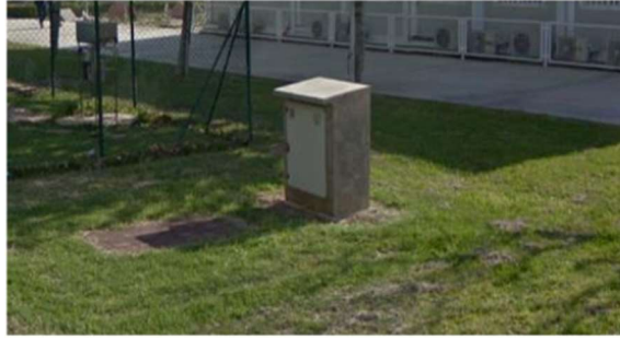
Fig. 4 Instalación Campus de Vera
