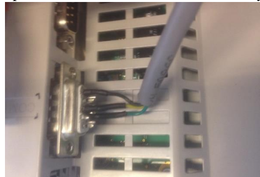
Figura 46. Fotografía del resultado final de la unión de los cables con el conector DB9 hembra que se conecta al COM1 de la pantalla táctil.
