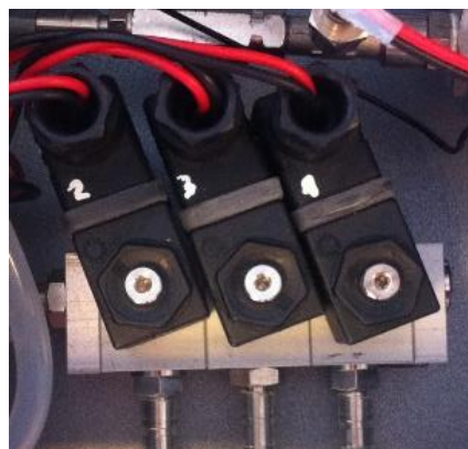
Figura 51. Imagen del resultado final de la conexión eléctrica de las electroválvulas.
