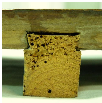
Fig. 129. Detalle de uno de los travesaños
